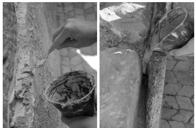
Figura 4. Instantánea durante la colocación de refuerzo perimetral. Figura 5. Pérdida del mortero original de la estructura y aplicación de un nuevo mortero
