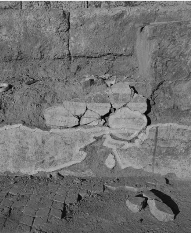
Figura 6. Reubicación de diversos fragmentos tras un derrumbe
