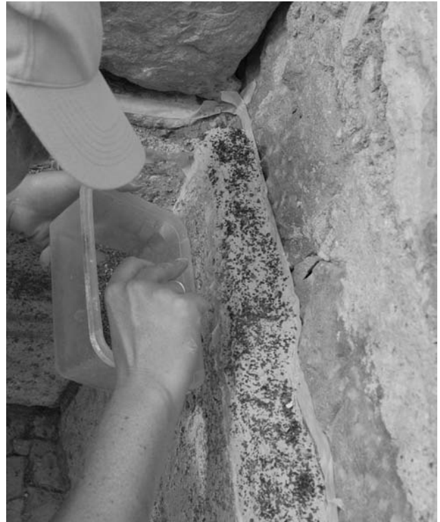
Figura 7. Ajuste cromático y textural del mortero perimetral
