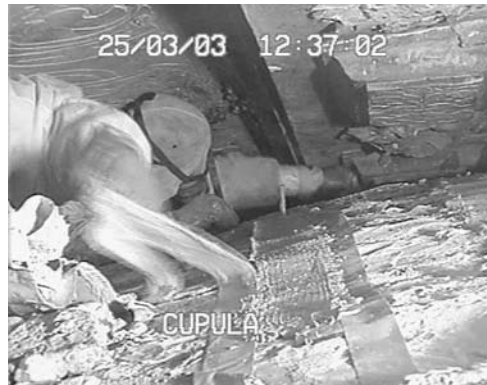
Figura 23. Refuerzo con tejido de fibras aramidicas
