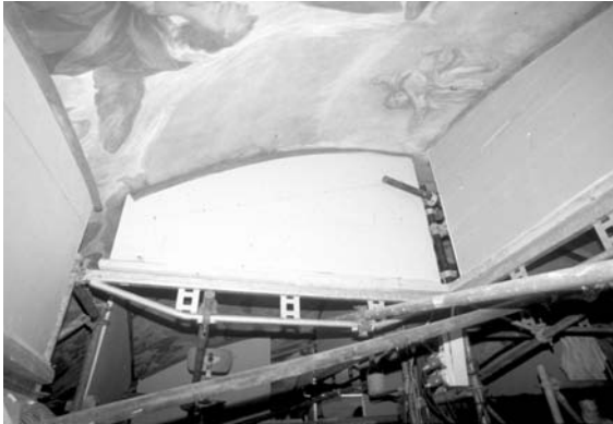
Figura 29. Apeo de la cúpula interior ante el corte de los anclajes
