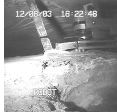
Figura 31. Corte de anclaje con el robot
