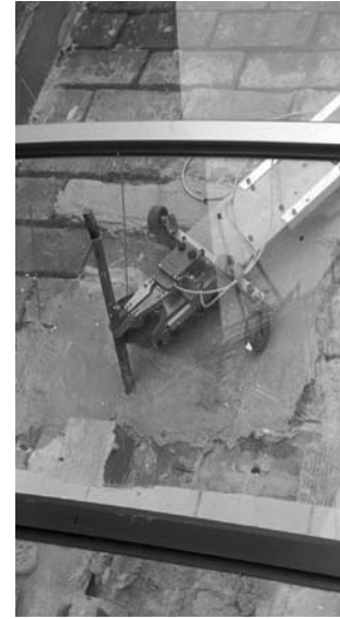
Figura 17. Ensayo de corte de anclajes
