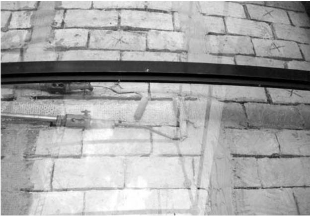
Figura 13. Ensayo de puesta en obra del refuerzo de tejido de fibras aramídicas.
