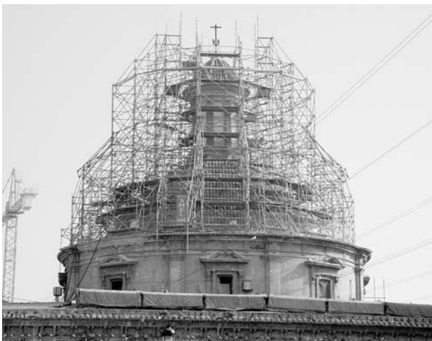
Figura 19. Montaje andamio exterior
