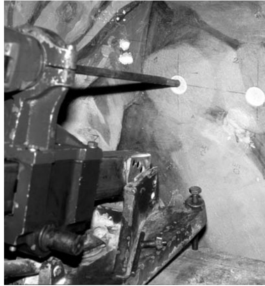
Figura 16. Ensayo de perforación desde el interior
