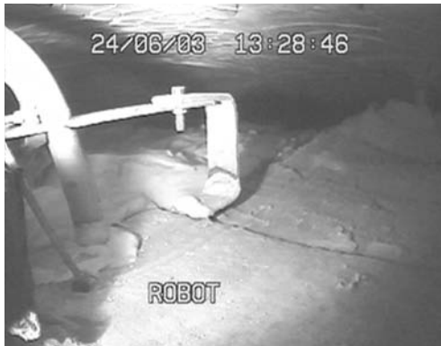
Figura 22. Rejuntado en obra con el robot
