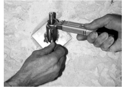
Figura 28. Proceso de tesado de los nuevos anclajes
