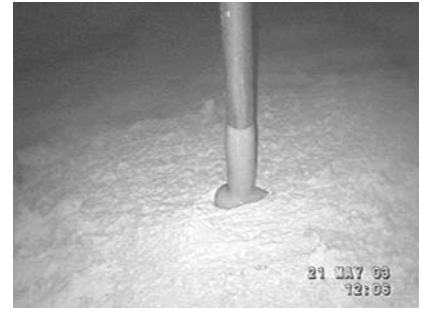
Figura 27. Colocación anclaje de varillas de fibra arámidica.
