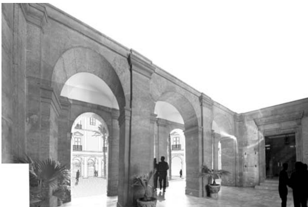
Figura 6. Vestíbulo principal de acceso al claustro
