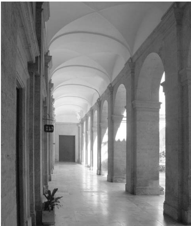
Figura 2. Lateral del claustro
