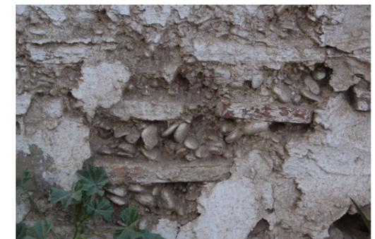
Fig. 108 Muro de hormigón de cal con ladrillos cerámicos macizos de la Alquería de Lleonart. Fuente: Propio autor.
