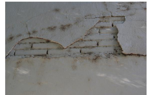
Fig. 113 Muro de fábrica de ladrillo cerámico macizo con mortero de cemento de la Alquería de Leonart. Fuente: Propio autor.
