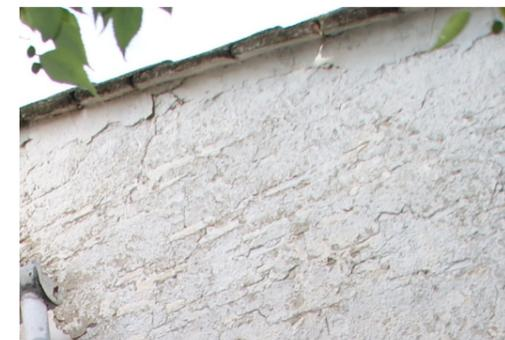
Fig. 109 Muro de hormigón de cal con ladrillos cerámicos macizos de la Alquería de Lleonart. Fuente: Propio autor.
