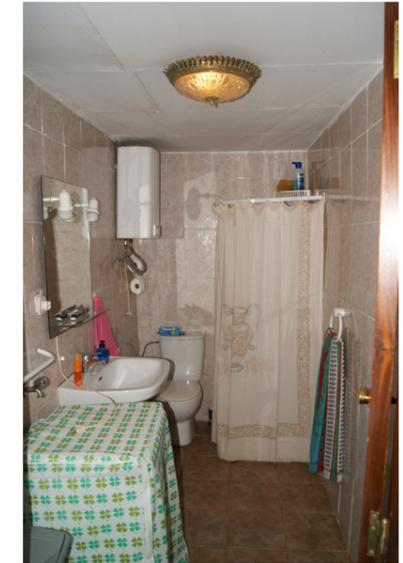
Fig. 122 Alicatado del Baño mediante azulejos cerámicos y solado de gres. Fuente: Propio autor.
