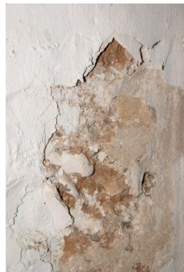
Fig. 106 Muro de hormigón de cal con árido rodado de la Alquería de Lleonart. Fuente: Propio autor.
