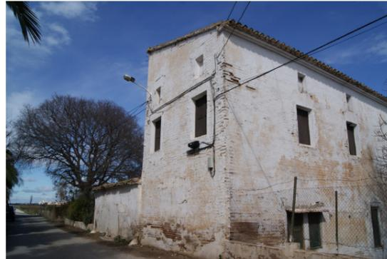
Fig. 117 Revestimiento de cal en los muros portantes que forman las fachadas de la Alquería de Leonart. Fuente: Propio autor.
