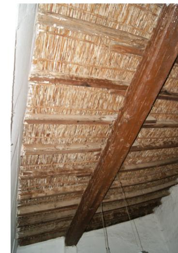
Fig. 95 Vista de la viga que sustenta la cubierta que cubre el Salón Comedor. Fuente: Propio autor.
