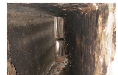
Fig. 93 Ennegrecimiento por ollín en el interior de la chimenea de la Cocina. Fuente: Propio autor.
