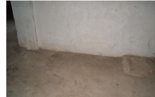
Fig. 123 Pavimento de mortero de cemento visto en la Cambra. Fuente: Propio autor.
