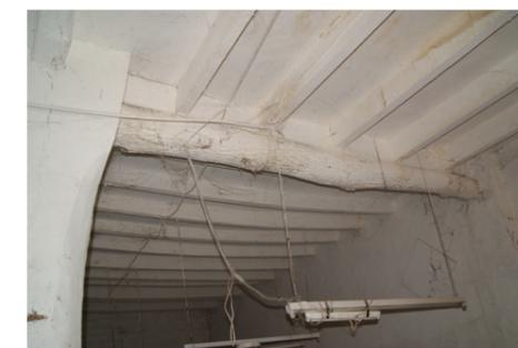
Fig. 100 Vista del forjado tabicado que divide el volumen 'D' en sus dos alturas. Fuente: Propio autor.
