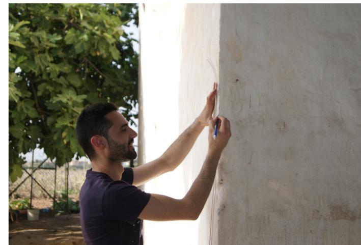
Fig. 18 En estas dos fotografías se observa al autor del proyecto marcando niveles en fachada utilizando el nivel de agua, en el exterior de la Alquería de Leonart, para la toma de datos. Fuente: Propio autor.
