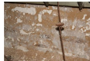
Fig. 88 Sales depositadas en la superficie de un muro de fábrica de ladrillo. Fuente: Propio autor.
