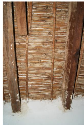
Fig. 104 Vista cenital del entrevigado de la cubierta que cubre el Salón Comedor. Fuente: Propio autor.
