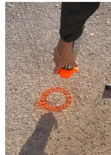
Fig. 11 Marcado de la situación del clavo para estacionar la estación total. Fuente: Propio autor.
