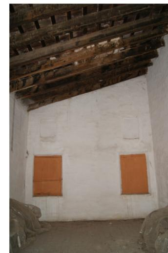
Fig. 96 Vista de los muros que sustentan la cubierta de rasillas que cubre la Cambra. Fuente: Propio autor.
