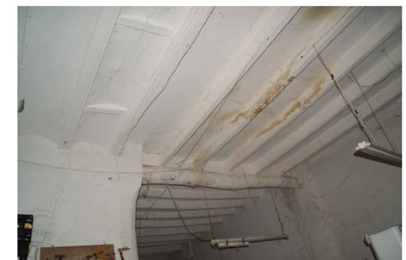
Fig. 97 Vista del rollizo que hace la función de viga de madera que sustenta el forjado divisor de las alturas del volumen 'D'. Se pueden ver también los muros portantes. Fuente: Propio autor.
