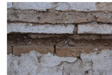
Fig. 86 Pérdida de hormigón de cal en tendeles del muro. Fuente: Propio autor.
