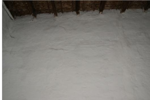
Fig. 116 Revestimiento de yeso en el muro portante del Salón Comedor. Pintura de cal. Fuente: Propio autor.
