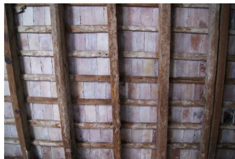
Fig. 101 Vista cenital de uno de los forjados de rasillas de la Alquería de Leonart. Fuente: Propio autor.
