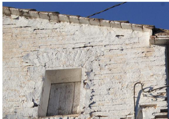
Fig. 111 Muro de fábrica de ladrillo cerámico macizo con hormigón de cal de la Alquería de Leonart. Fuente: Propio autor.
