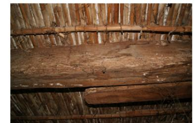
Fig. 90 Carcoma presente en las vigueras de madera. Fuente: Propio autor.
