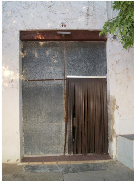
Fig. 125 Puerta de madera, de entrada principal a la Alquería de Leonart, cubierta con chapa de latón. Fuente: Propio autor.
