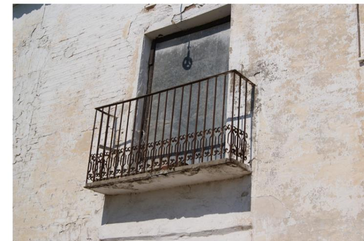
Fig. 124 Cerrajería de hierro forjado que forma la barandilla del balcón de la Cambra. Fuente: Propio autor.
