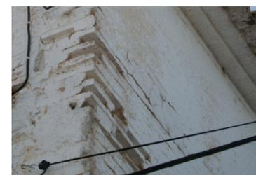
Fig. 91 Pérdida de material en las juntas de un muro de fábrica de ladrillo. Fuente: Propio autor.
