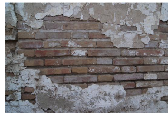
Fig. 112 Muro de fábrica de ladrillo cerámico macizo con mortero de cemento de la Alquería de Leonart. Fuente: Propio autor.
