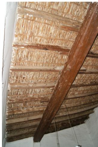
Fig. 103 Vista cenital de la cubierta de cañizo que cubre el Salón Comedor. Fuente: Propio autor.
