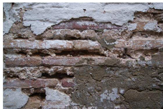
Fig. 110 Muro de fábrica de ladrillo cerámico macizo con hormigón de cal de la Alquería de Leonart. Fuente: Propio autor.
