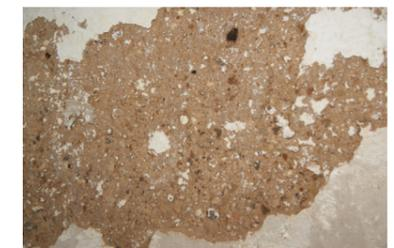
Fig. 87 Desconchado a causa de las eflorescencias presentes en un muro de hormigón de cal. Fuente: Propio autor.
