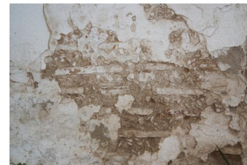
Fig. 107 Muro de hormigón de cal con ladrillos cerámicos macizos de la Alquería de Lleonart. Fuente: Propio autor.
