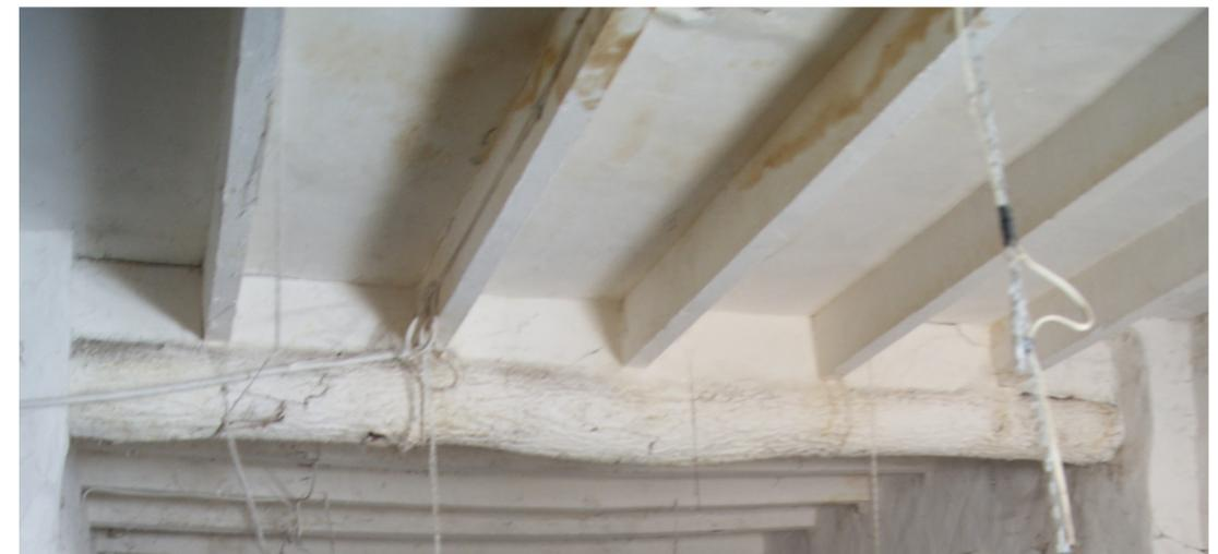
Fig. 150 Rollizo que sustenta las viguetas del forjado que divide el volumen 'D' en sus dos alturas. En él se produce un cambio de dirección del forjado. Fuente: Propio autor.
