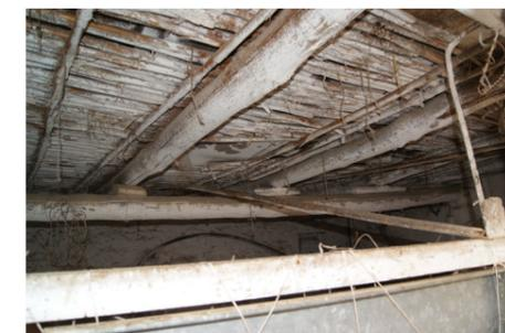
Fig. 102 Vista cenital del forjados de rollizos de la Alquería de Leonart. Fuente: Propio autor.
