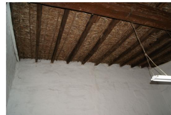
Fig. 94 Vista de los muros portantes que sustentan la cubierta de cañizo que cubre el Salón Comedor. Fuente: Propio autor.
