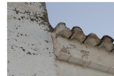
Fig. 89 Grieta en el encuentro lateral del alero con el muro atestado a él. Fuente: Propio autor.
