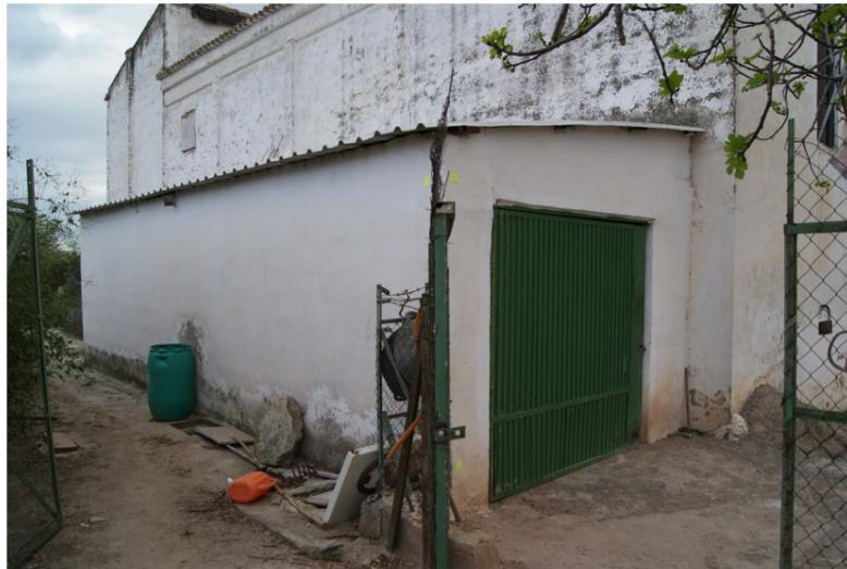
Fig. 114 Muro de bloque de hormigón revestido con mortero de cemento que forma los muros del volumen 'Z' de la Alquería de Leonart. Fuente: Propio autor.
