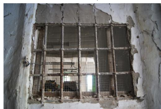
Fig. 136 Cerrajería de hierro de las ventana del Cuarto que comunica con el Almacén 1. Fuente: Propio autor.
