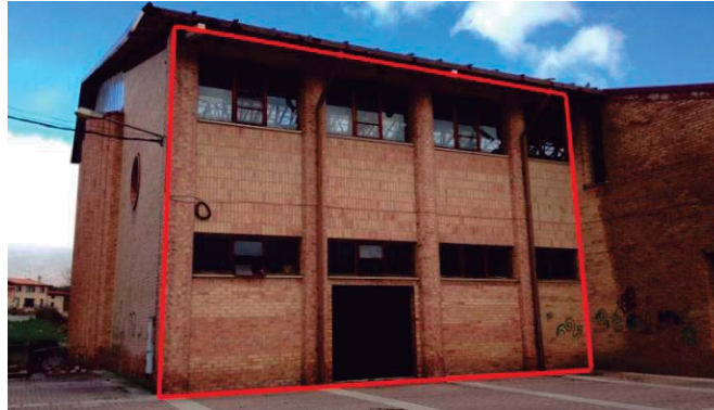
Figura 44. Paño 7 del cerramiento
