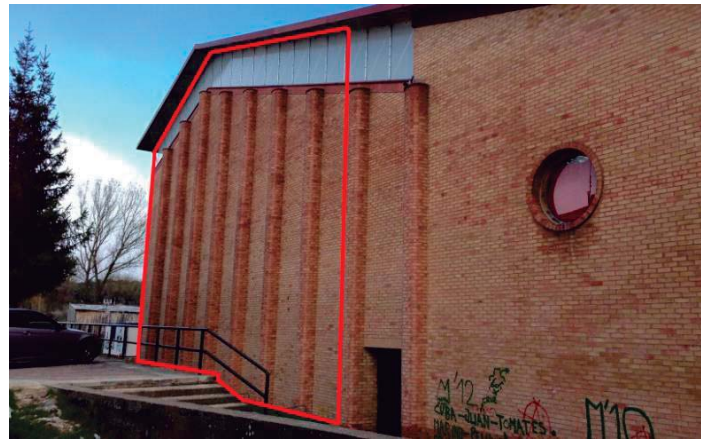
Figura 38. Paño 5 del cerramiento
