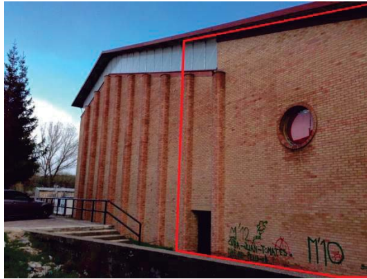
Figura 41. Paño 6 del cerramiento
