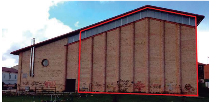
Figura 32. Paño 3 del cerramiento
