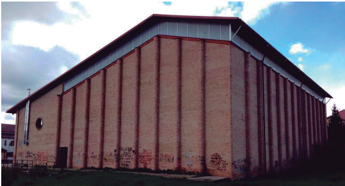
Figura 3. Lateral derecho y fachada trasera
