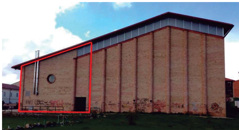
Figura 29. Paño 2 del cerramiento
