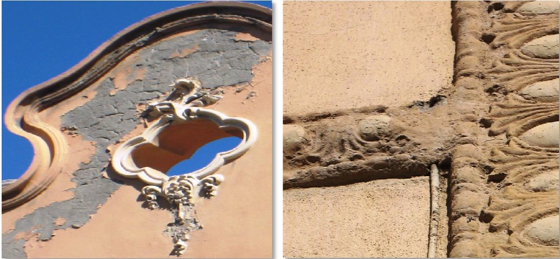
Fig.126. Ejemplos de deterioro en revestimientos y adornos de fachada
