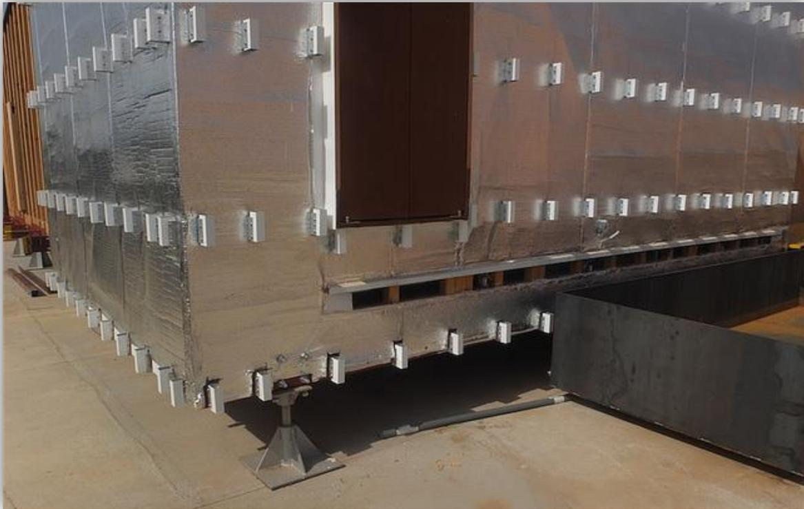
Gracias a un aislamiento exterior reflectante y a los anclajes se consigue una fachada exterior ligera.
