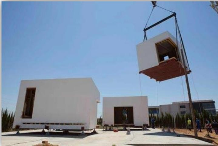
Para la construcción de la vivienda se completa cada módulo habitacional en taller mediante elementos industrializables independientes. Se distinguen tres partes: **envolvente, islas y armarios**. La producción y comercialización de estos tres elementos puede ser autónoma y aplicarse a otros fines: **nueva construcción, reformas y ampliaciones**, e incluso a la rehabilitación energética y funcional de edificios obsoletos existentes.
