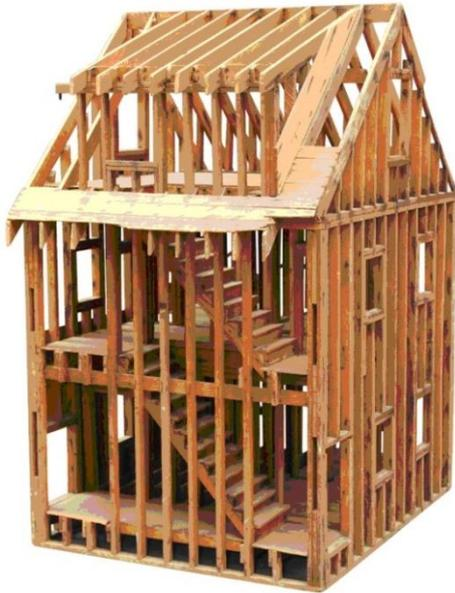
Con el uso de la madera como material estructural, aparece el sistema de construcción Balloon Frame, es un tipo de construcción a base de listones de madera, consistente de una estructura de numerosos listones finos, que son más manejables y pueden clavarse entre sí. Esta tipología constructiva produce generalmente viviendas de una o dos plantas, y tiene la característica de tener una construcción ligera y fácil de construir.
