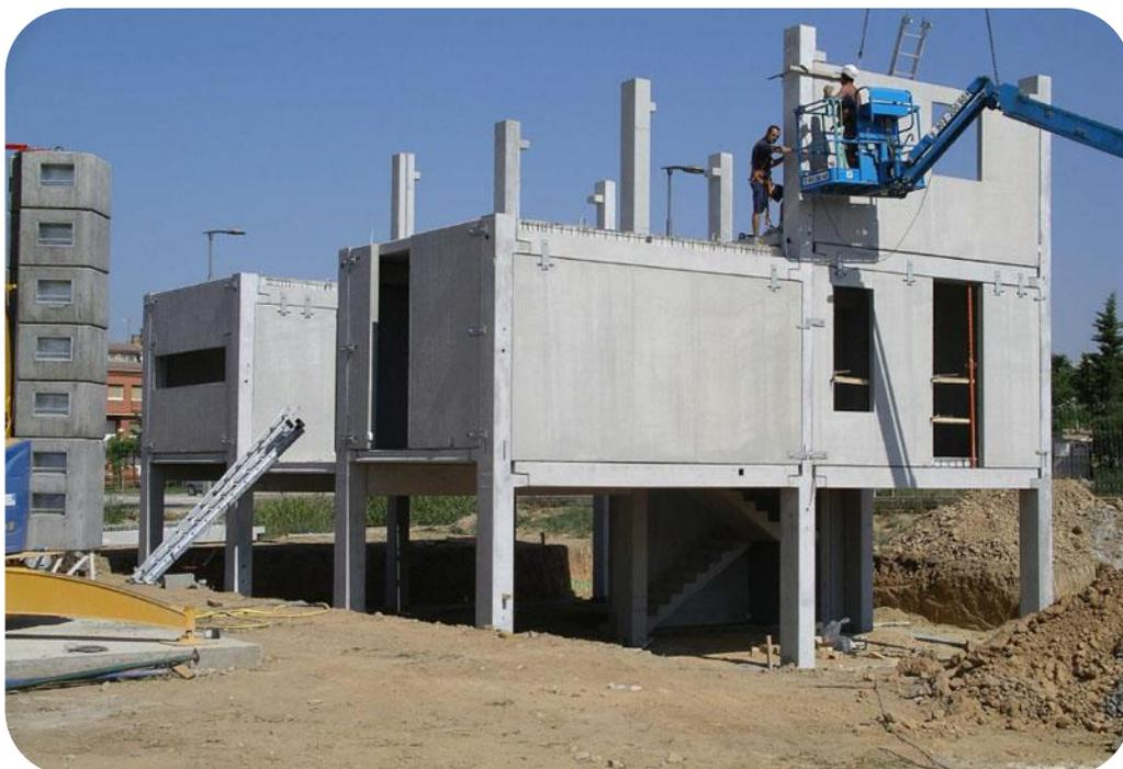
*Sistema prefabricado de hormigón, creando incluso los cerramientos, (Pich Aguilera)*
