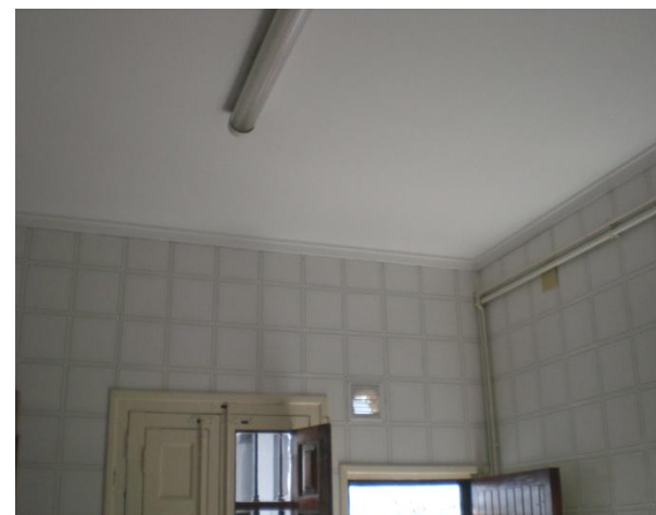
Figura 9. Vista del falso techo de la cocina
