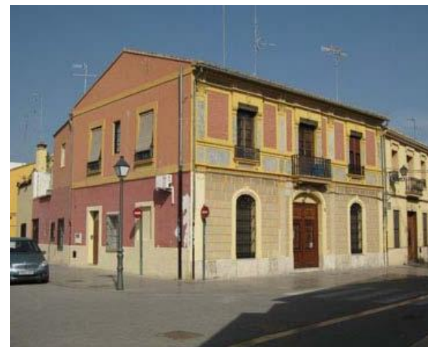
Fig. 4. Vista general de fachadas
