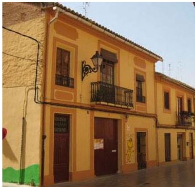
Fig. 19. Vista de la fachada principal
