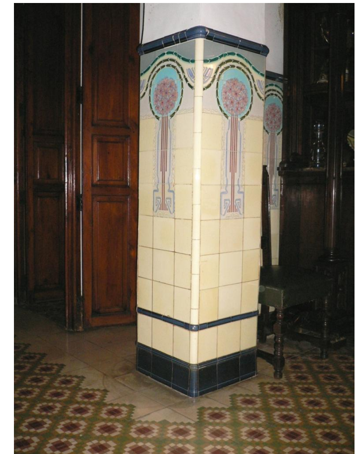
Figura 11. Alicatado de la entrada, pasillo y comedor
