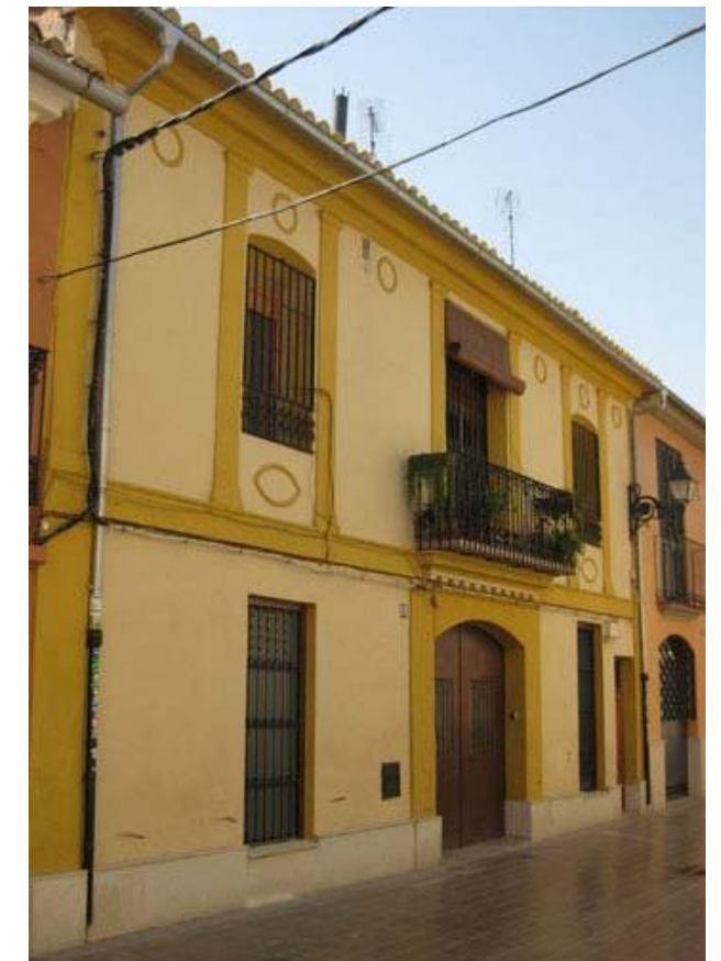
Fig. 24. Vista de la fachada principal
