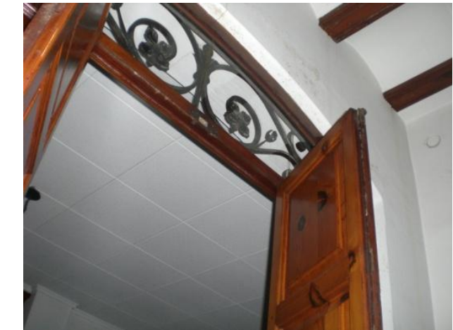
Figura 8. Vista del falso techo del comedor
