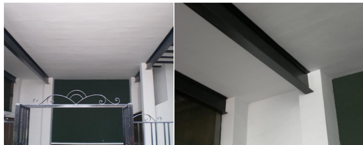
Fig. 8 y 9. Vistas de la estructura de soporte del forjado del altillo desde el almacén
