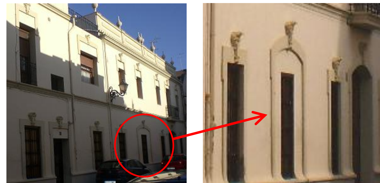
Fig. 12 y 13. Vistas del hueco de acceso inicial convertido en ventana
