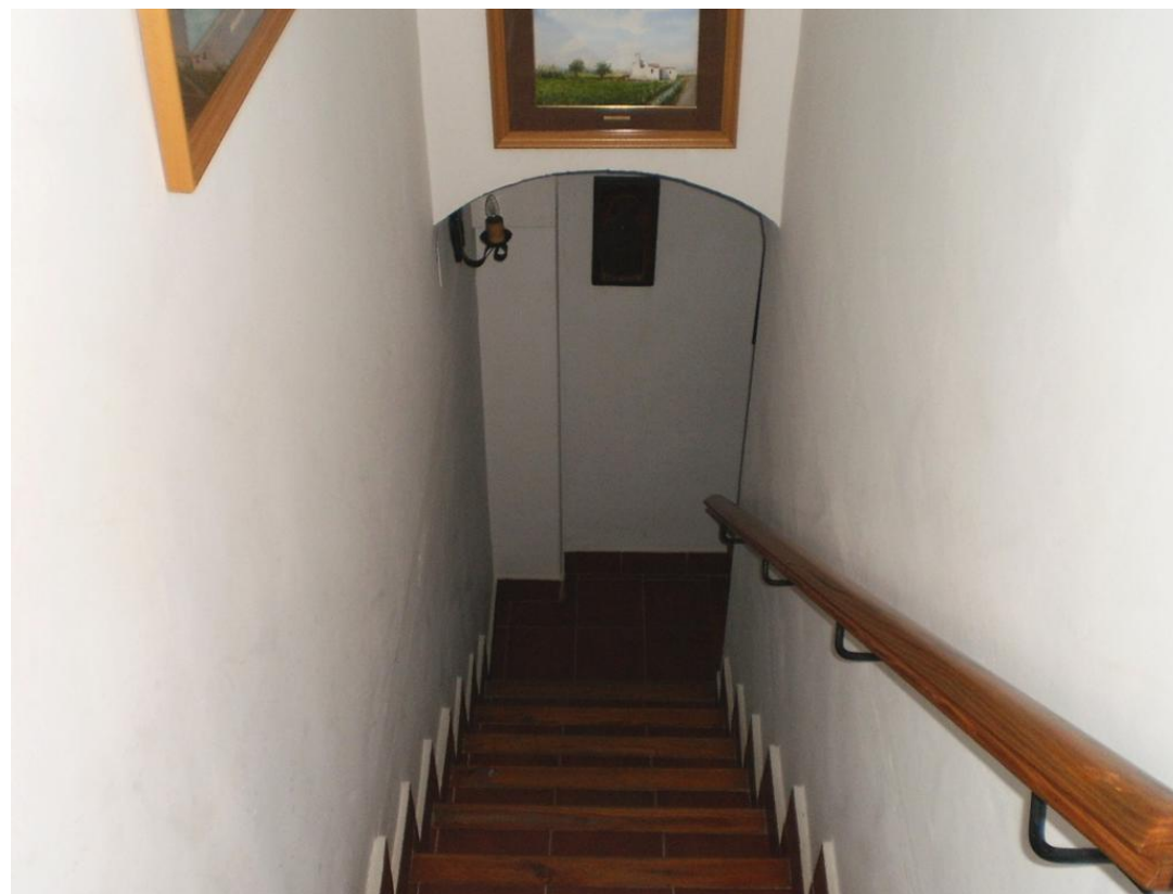
Figura 39. Vista de la escalera de acceso a la sala de juegos desde planta baja
