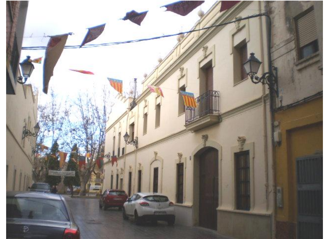
Figura 2. Vista de la fachada lateral (calle Virgen de Campanar)
