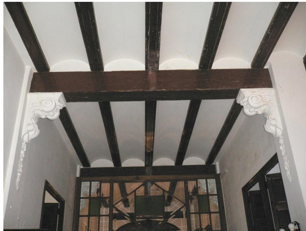
Figura 6. Vista del techo del pasillo
