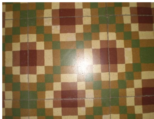
Fig. 4. Vista del pavimento de la entrada y del salón
