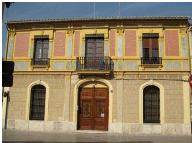
Fig. 3. Vista de la fachada principal
