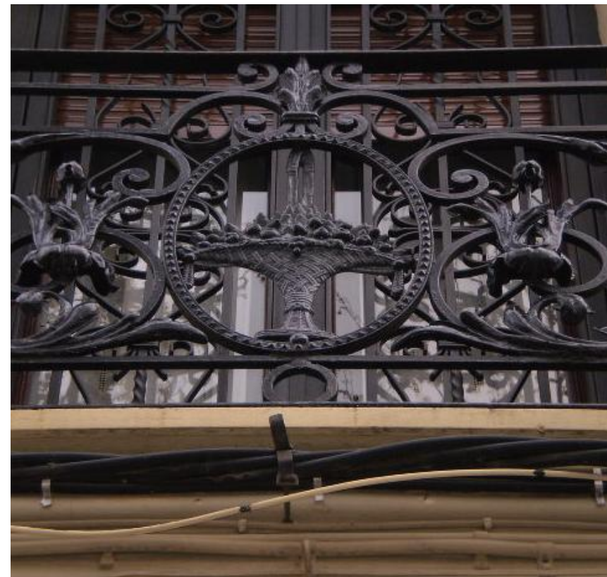
Figura 4. Rejería de balcones de la fachada principal
