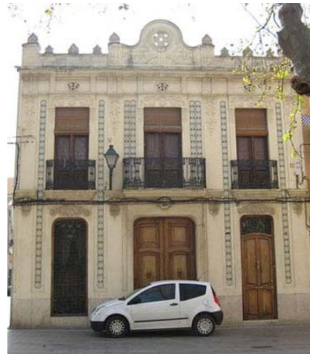
Fig. 13. Vista de la fachada principal
