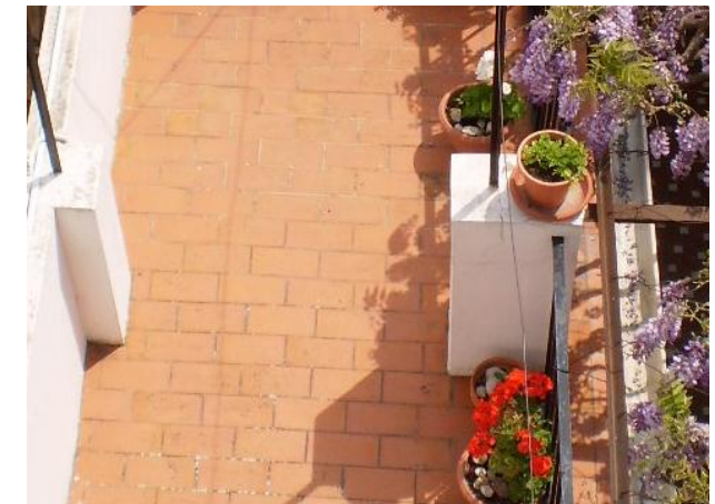
Figura 6. Vista del pavimento del "mirador"
