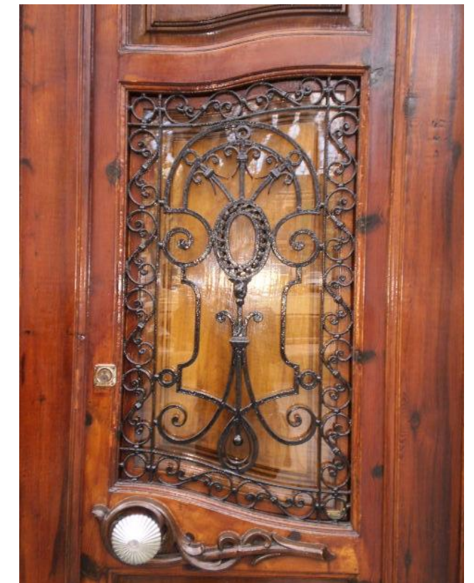
Figura 5. Detalle de la puerta principal
