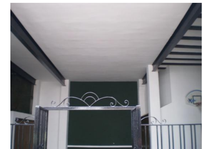
Figura 10. Vista del techo del almacén
