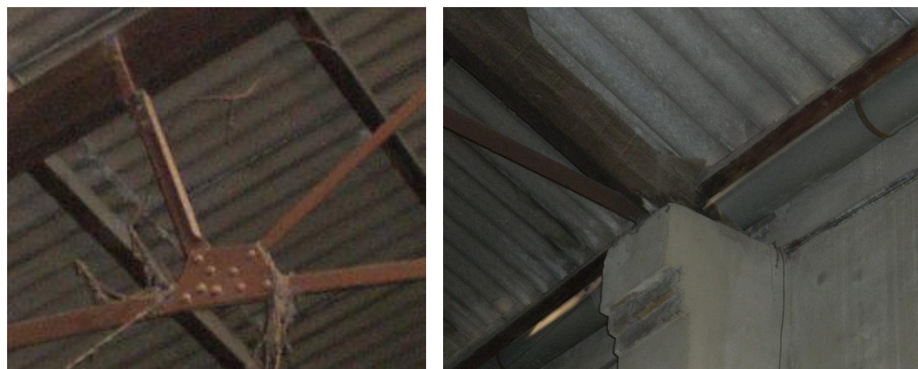
Figuras 7 y 8. Vistas del apoyo y de detalle de las cerchas
