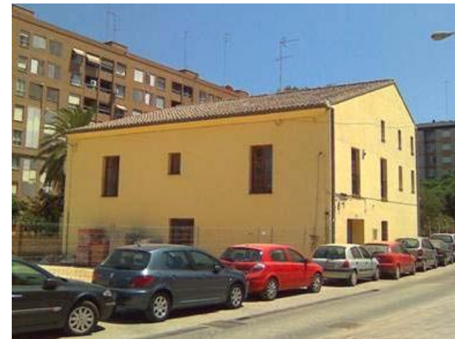
Fig. 7. Vista general de fachadas
