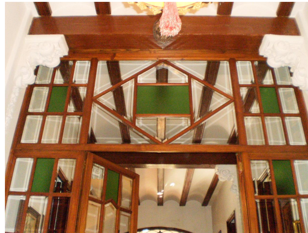
Figura 7. Vista de la puerta del pasillo
