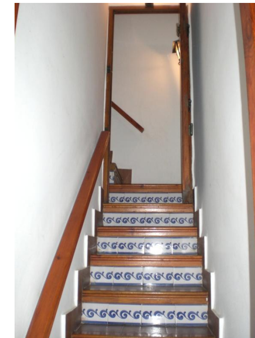
Fig. 3. Vista de escalera original
