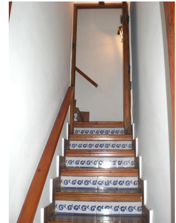
Figura 8. Vista de la escalera original
