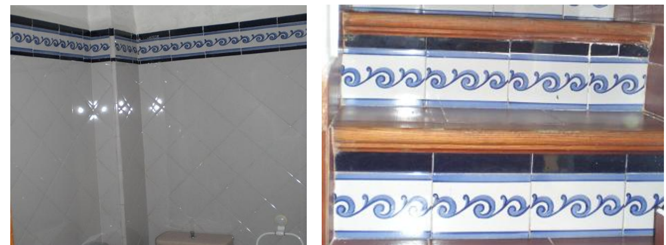
Figura 12. Alicatado del Baño 2. Alicatado 5.
