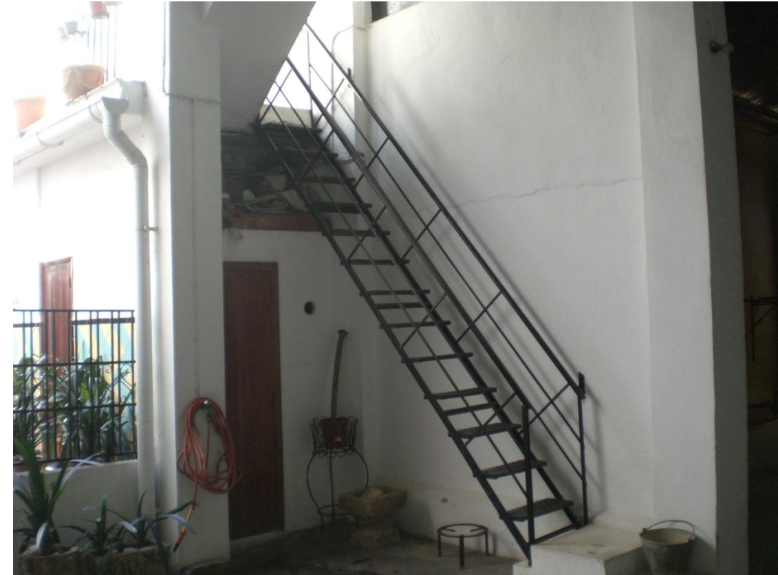
Figura 25. Vista de la escalera metálica de acceso al altillo
