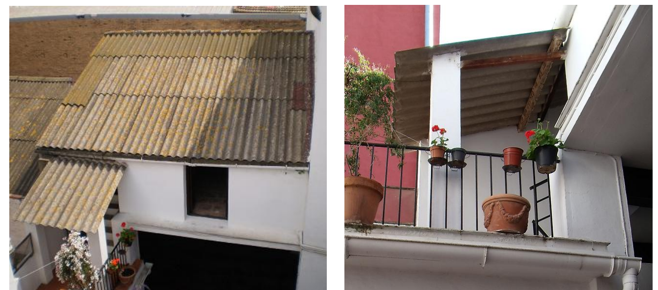
Figuras 3 y 4. Vistas la cubierta del altillo y del mirador
