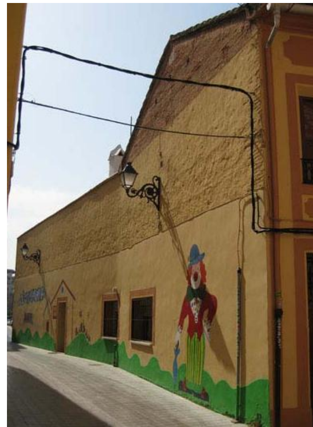
Fig. 20. Vista de la fachada lateral
