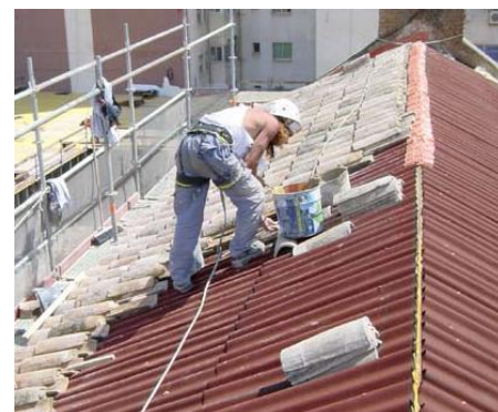
Figuras 4, 5, 6, 7 y 8. Vistas de la ejecución del sistema extraídas del manual de Onduline
