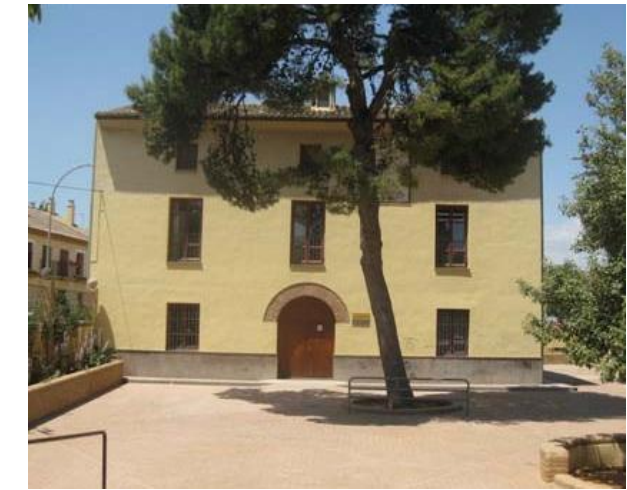
Fig. 8. Vista de la fachada principal
