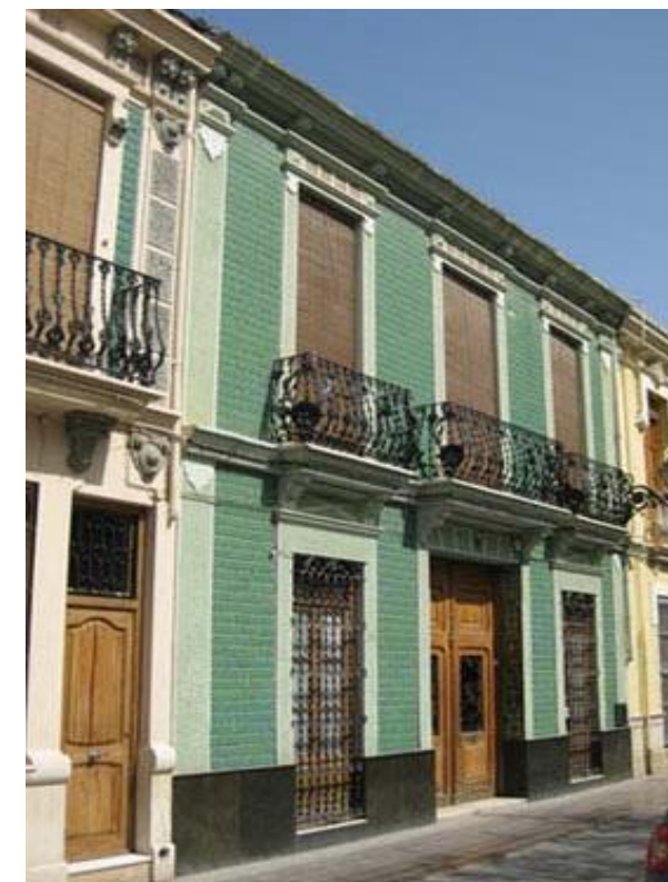
Fig. 30. Vista de la fachada principal
