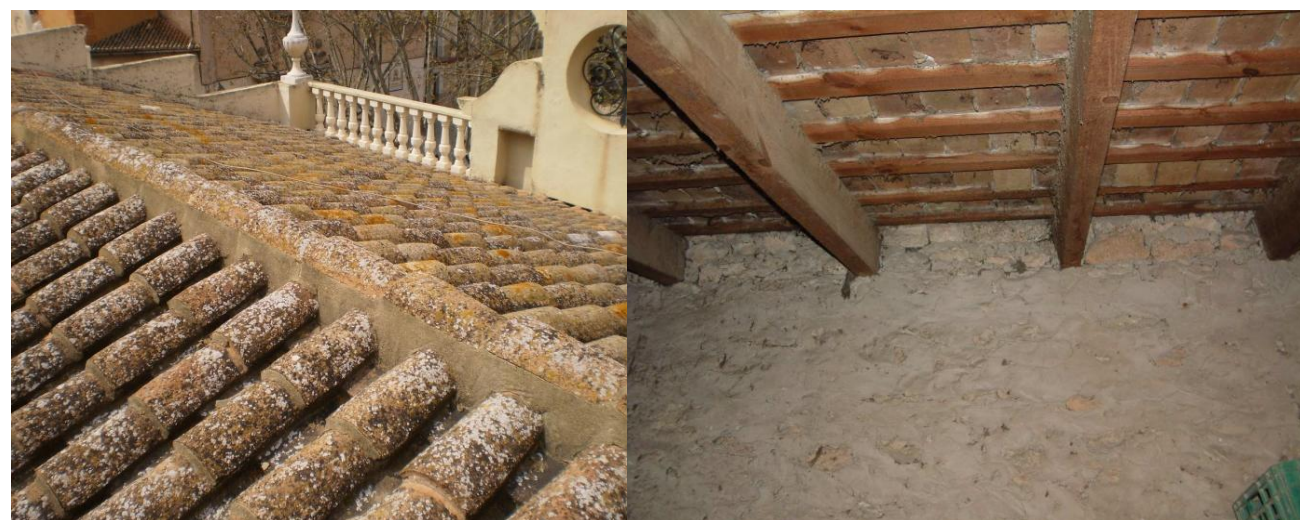
Fig. 1. Vista del acabado de la cubierta
