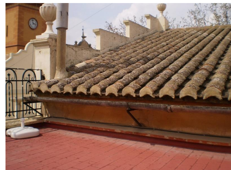
Figura 1. Cubierta plana superior
