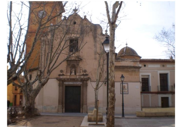
Figura 4. Vista de la fachada principal
