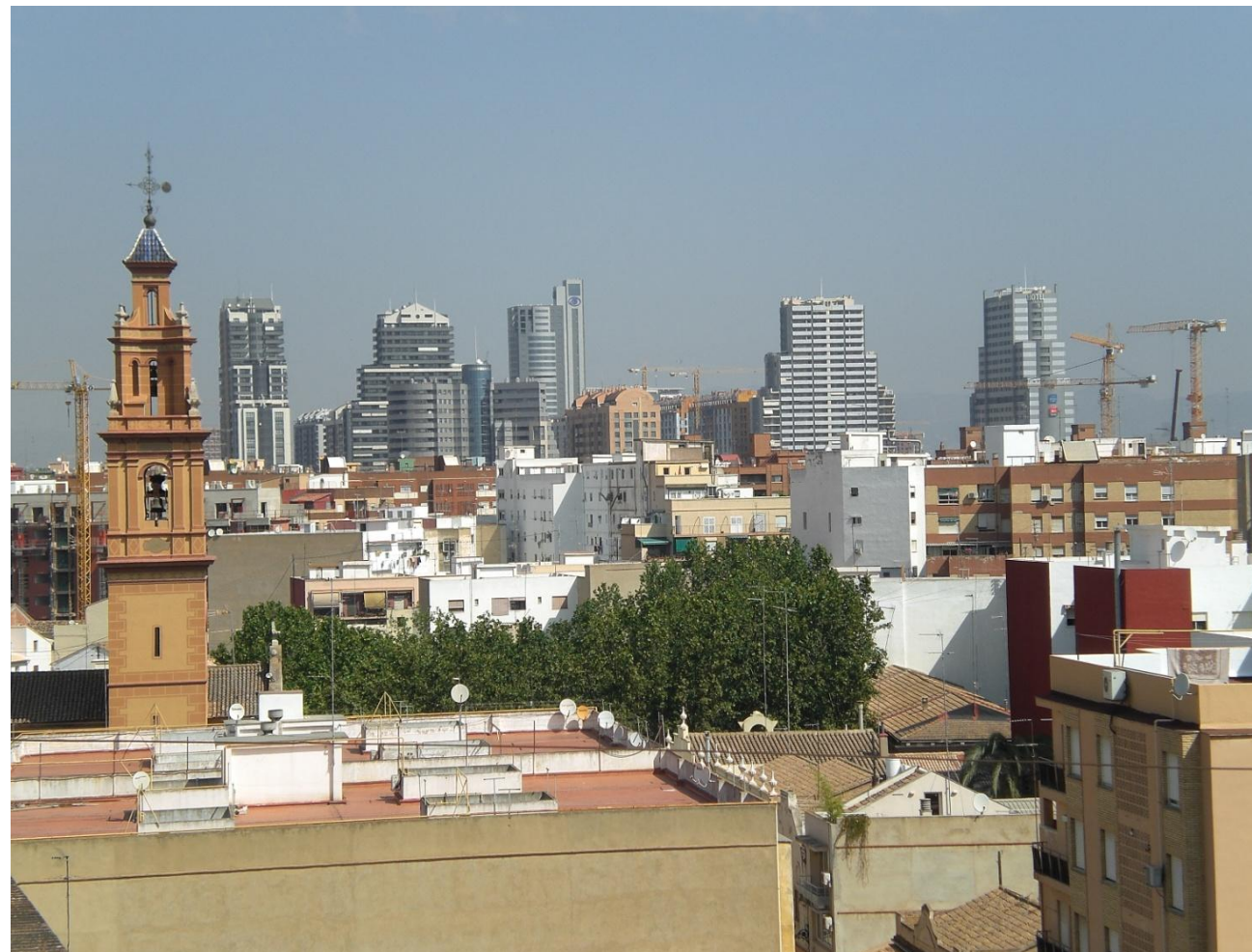
Figura 1. Vista general de la nueva edificación en altura
