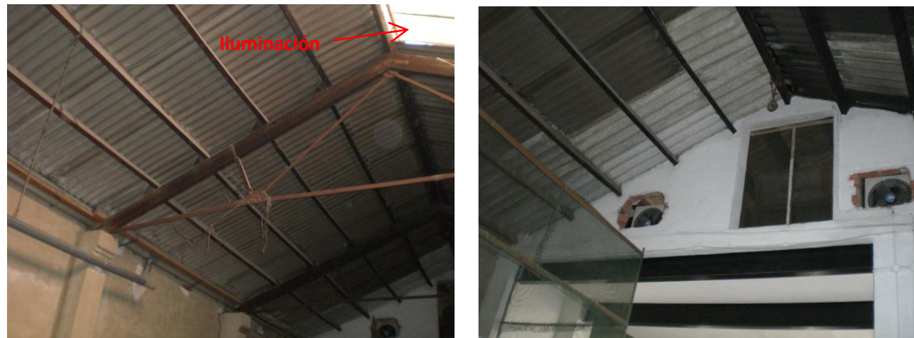
Figuras 5 y 6. Vistas de la estructura de soporte de la cubierta del almacén
