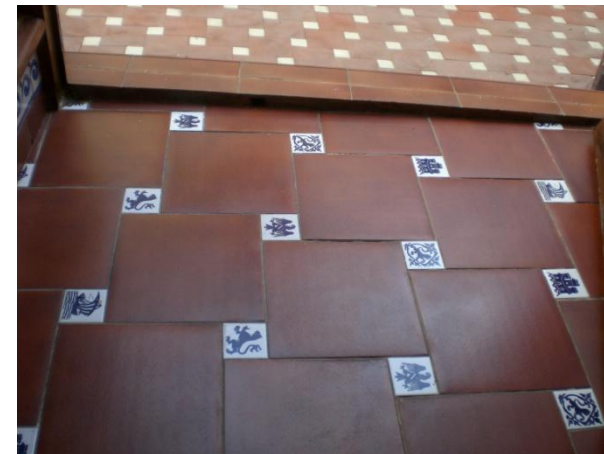
Figura 5. Vista del pavimento del distribuidor
