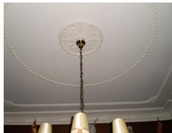
Figura 7. Vista del falso techo de la biblioteca
