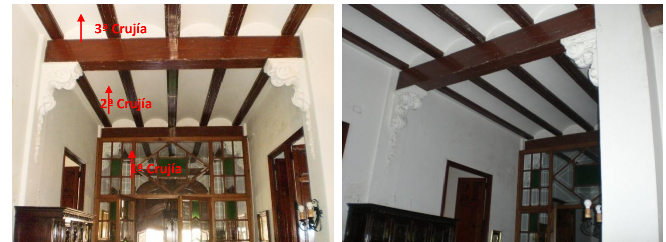
Figuras 4 y 5. Vistas del forjado original del cuerpo de la vivienda
