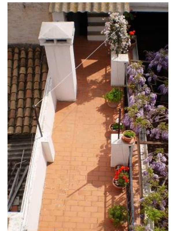
Figura 23. Cubierta del mirador
