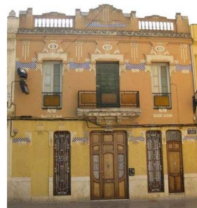
Fig. 16. Vista de la fachada principal
