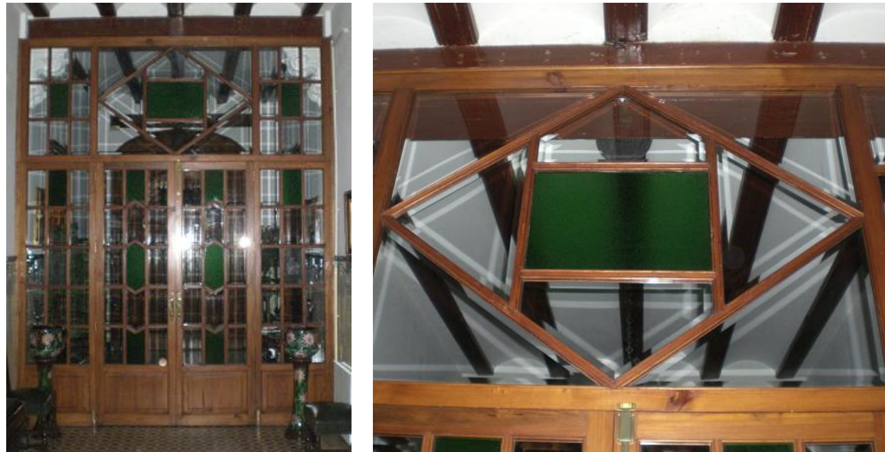
Figuras 12 y 13. Puerta vestíbulo de entrada-pasillo (P1)
