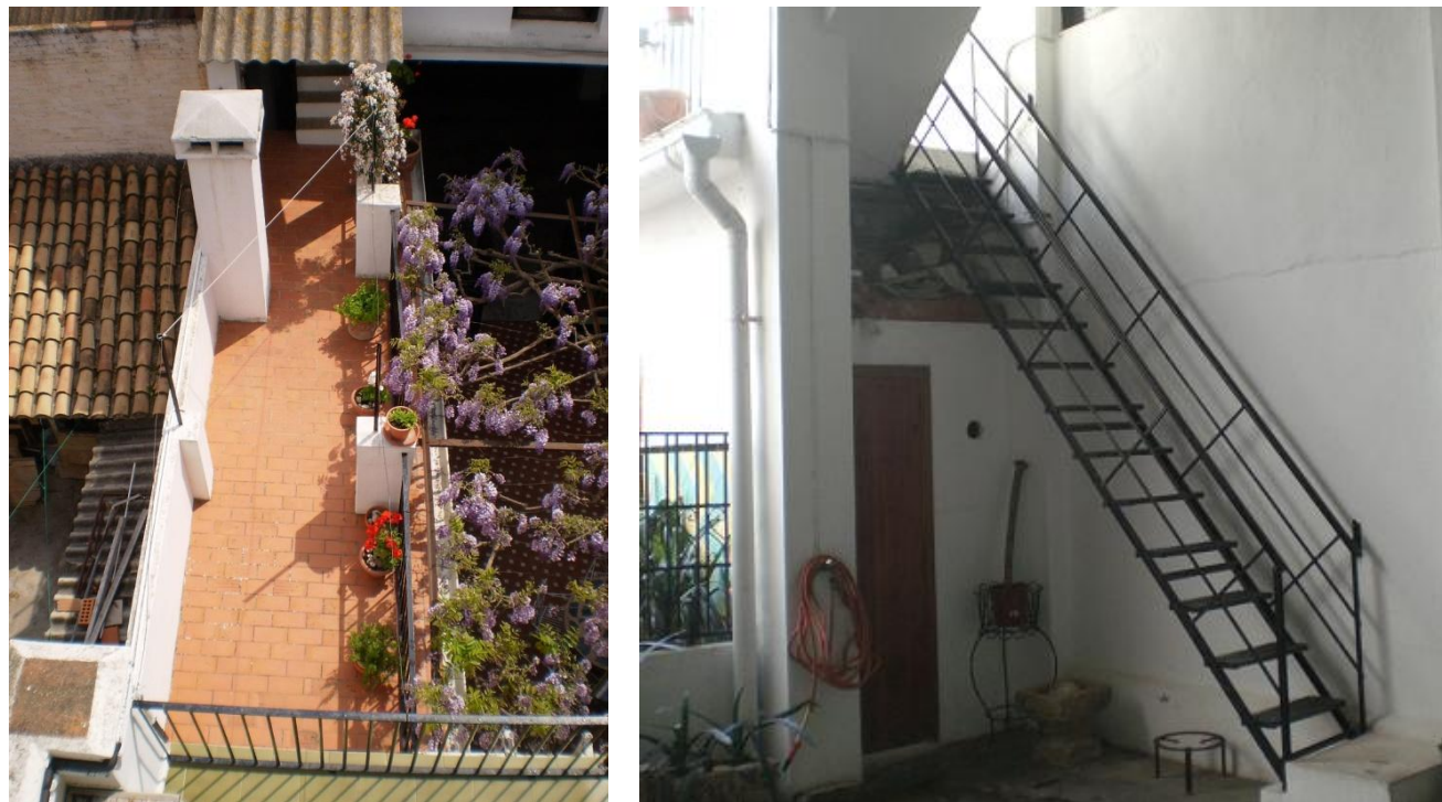
Fig. 16. Vista de la azotea del “mirador”
