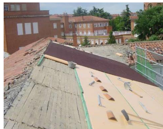
Figuras 4, 5, 6, 7 y 8. Vistas de la ejecución del sistema extraídas del manual de Onduline
