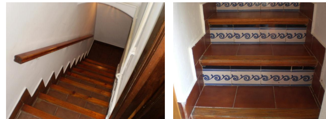
Fig. 24, 25, 26 y 27. Imágenes de la escalera que comunica la planta baja con la sala de juegos
