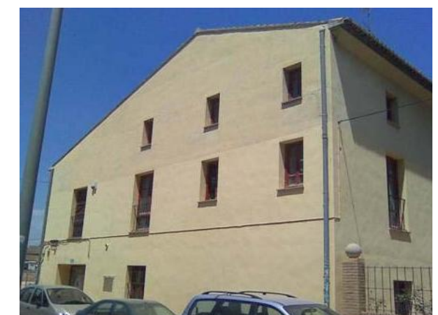
Fig. 9. Vista de la fachada lateral
