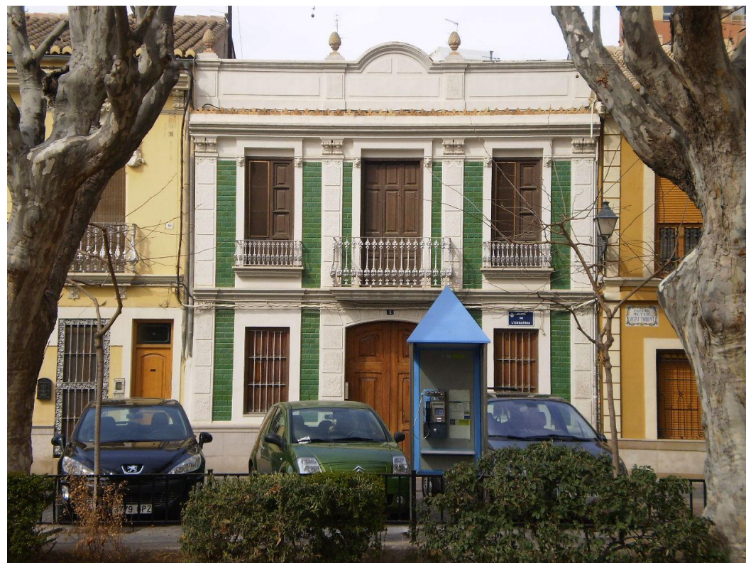
Fig. 27. Vista de la fachada principal
