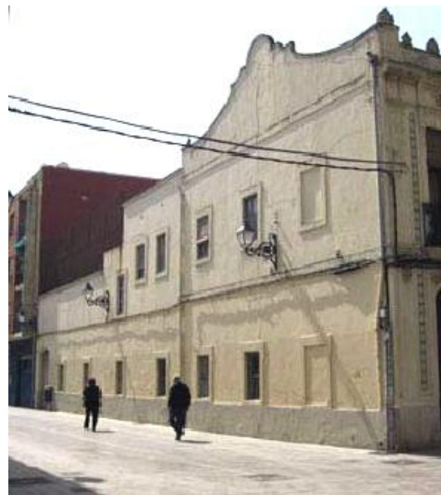
Fig. 12. Vista de la fachada lateral
