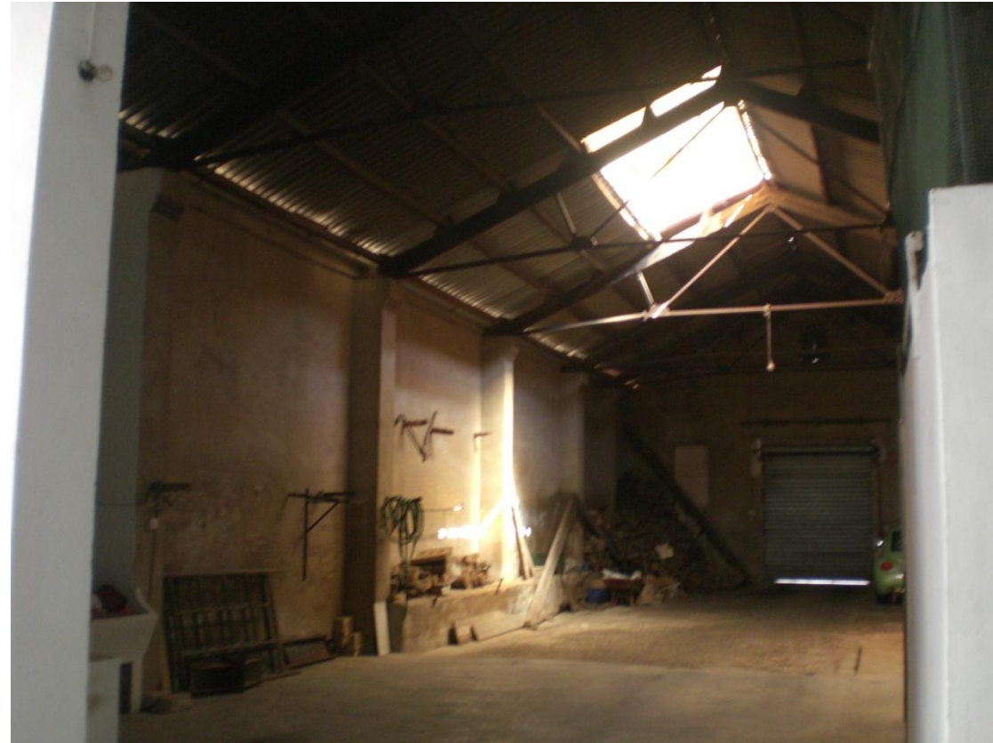
Figura 24. Vista de la nave del almacén
