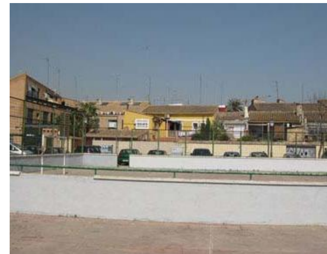
Fig.23. Vista general posterior desde el espacio libre
