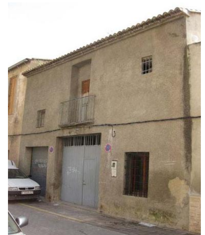
Fig. 31. Vista de la fachada posterior
