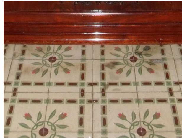
Figura 2. Vista del pavimento del dormitorio
