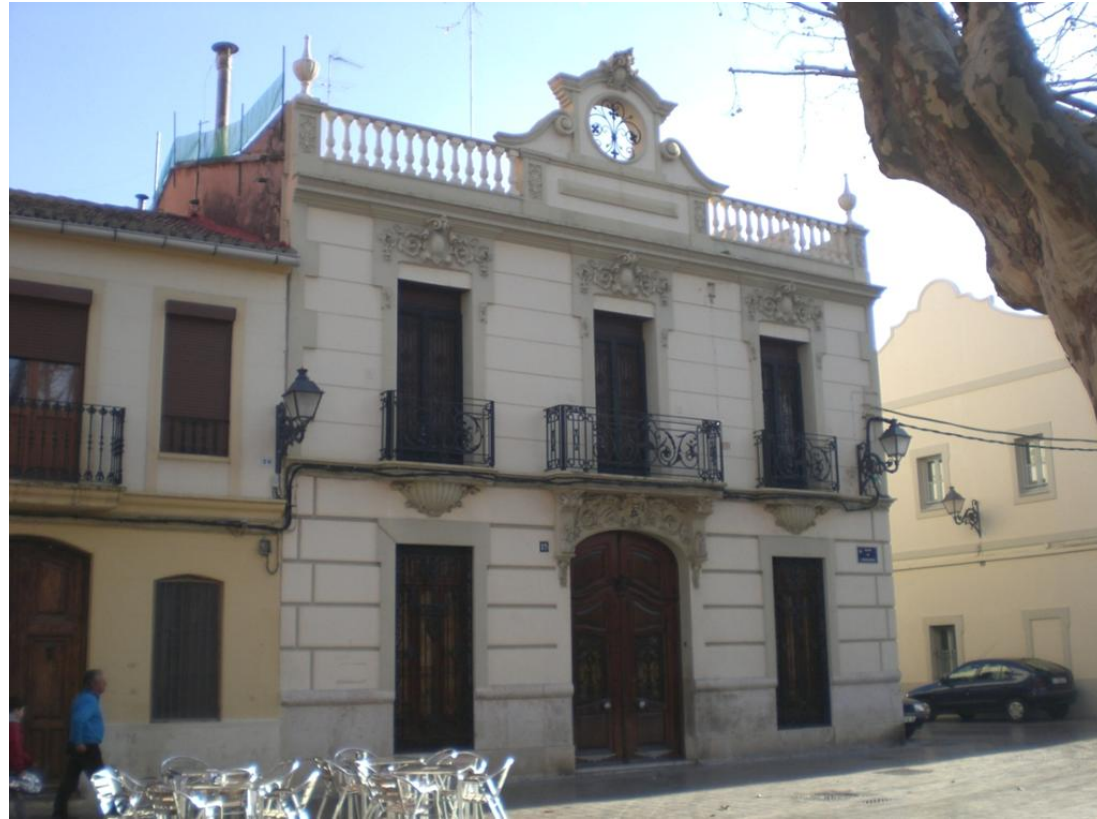
Figura 1. Vista de la fachada principal (Plaza de la Iglesia)
