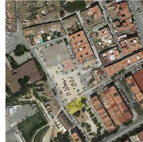
Fig. 5. Vista aérea. Localización
