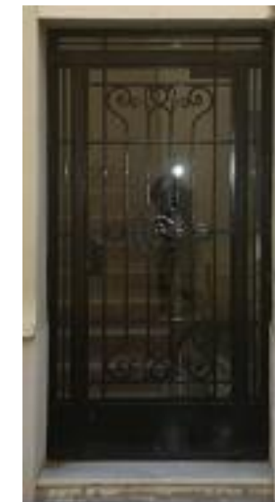
Figura 2. Puerta entrada a escalera Calle Virgen de Camanar (PE2)
