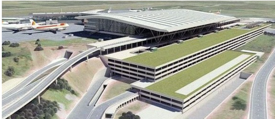
Fig 4.5 - Aeropuerto de Santiago de Compostela
