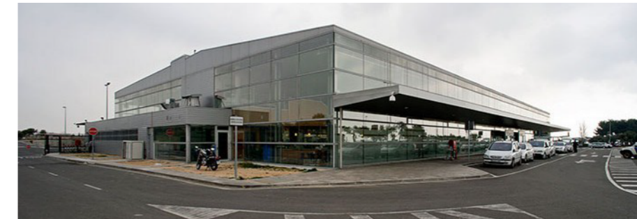
Fig 4.2 - Terminal de Llegadas del aeropuerto de Reus
