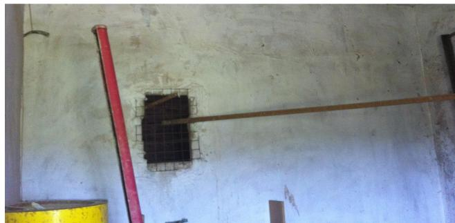
Las particiones interiores son las encargadas de dividir cada una de las estancias del interior de la vivienda, están ejecutadas mediante fábricas de ladrillo macizo y revestidas con mortero de cal.
