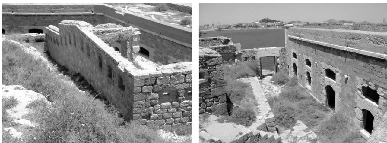
Figura 3. Izq.: espalda del Fuerte de Navidad desde la falda del Monte Galeras. Vista del Muro aspillerado que cubre el reducido foso que lo separa de la pendiente rocosa. Dcha.: Vista del patio interior del Fuerte de Navidad, con los accesos a las casamatas y la puerta principal que comunica con el Puerto
