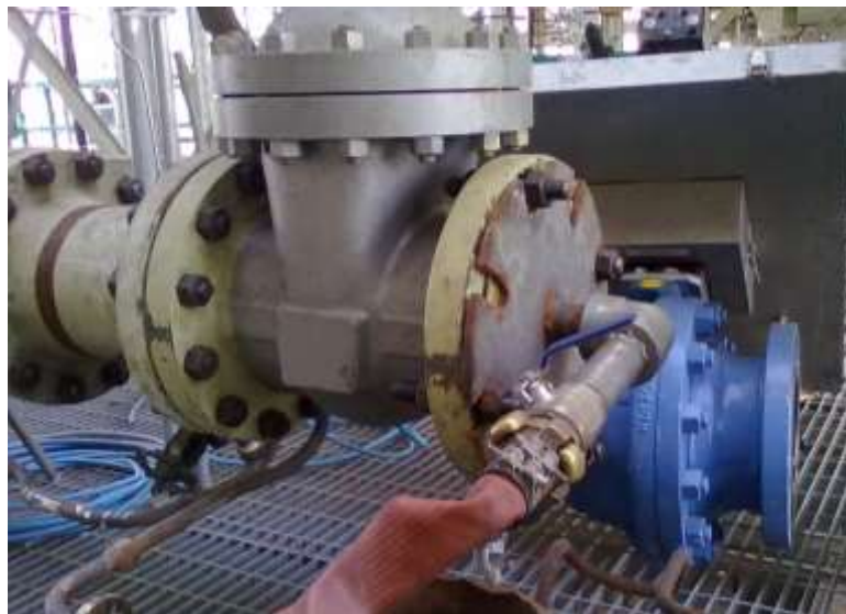
Conexión para llenado de circuito durante pruebas hidráulicas.
