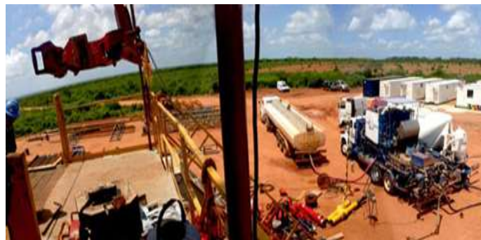
Labores de terminacion.
