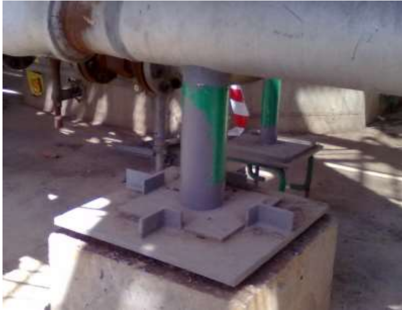
“Trunnion” de apoyo con límite de desplazamiento en todas sus direcciones.
