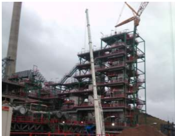
Remate final reactores con hornos y chimenea finalizados.
