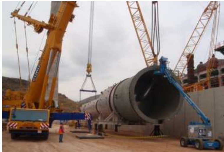
Izado equipo estático zona hydrocracker proyecto C-10
