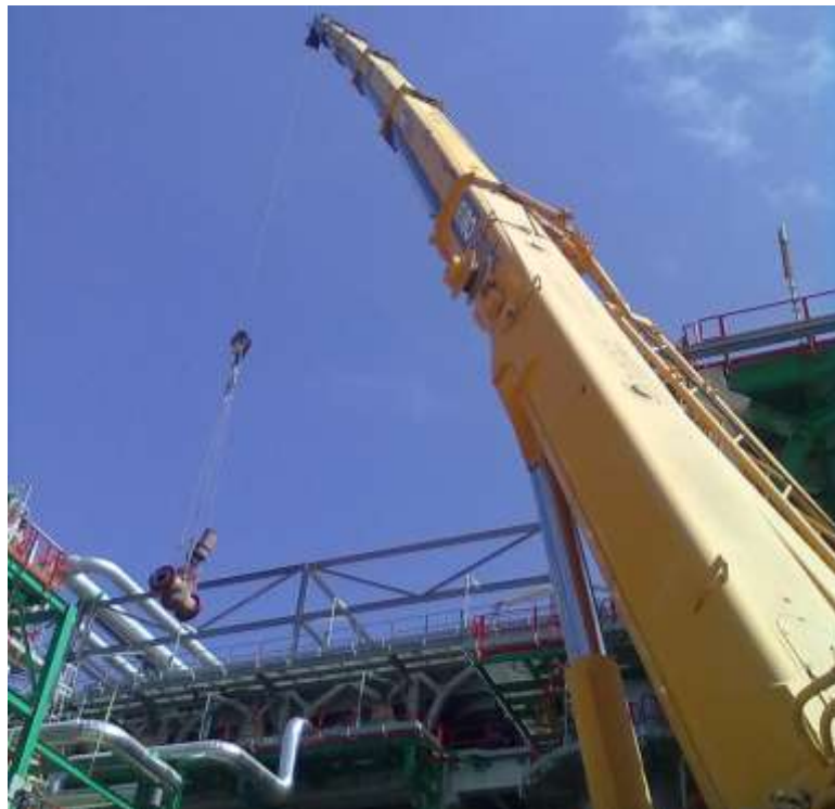
Izado válvula a zona de aéros.
