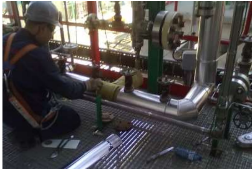
Ejecución de calorifugado de línea de instrumentación en inoxidable.
