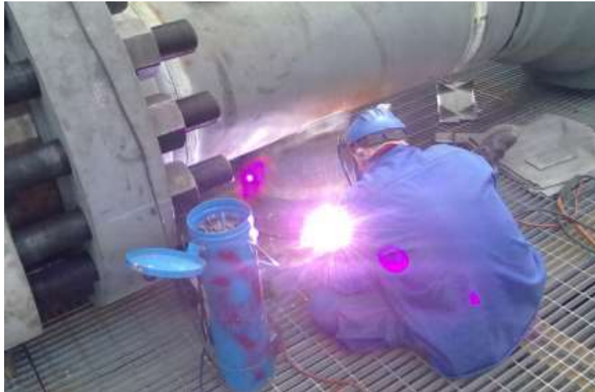
Ejecución de soporte, "trunnion" de apoyo.
