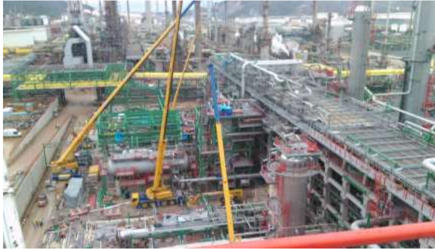
Maniobras de montaje de estructura y tubería mayor.
