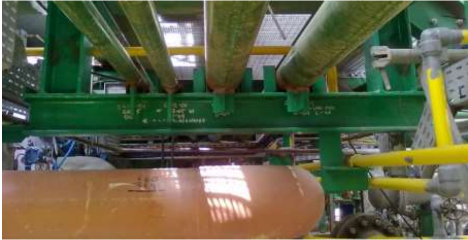
Apoyo líneas sobre portería invertida con guías y stops.
