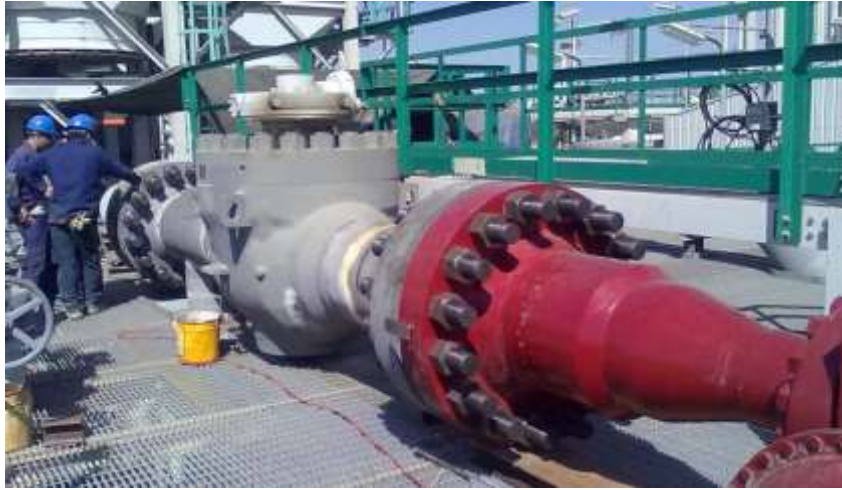
Operaciones de montaje válvulas en zona aéreas.
