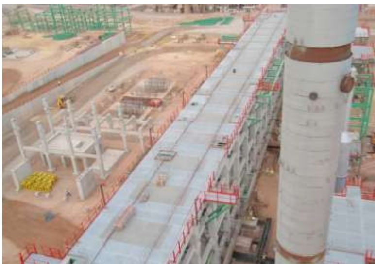
Estado previo al montaje de equipos estáticos y tubería.
