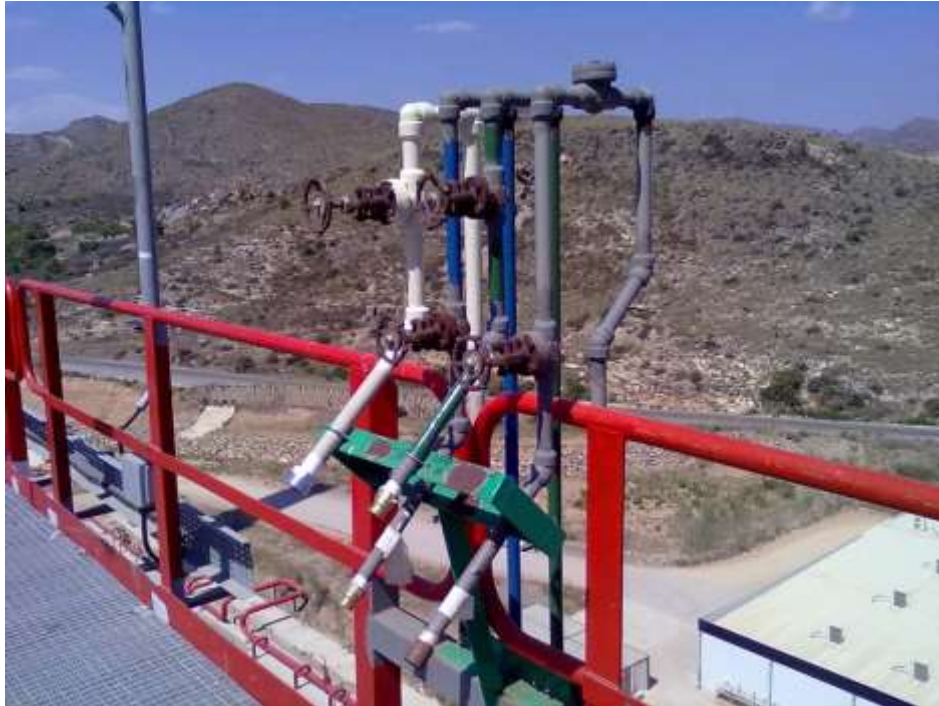
Estación de servicio zona reactores proyecto C-10, Cartagena.
