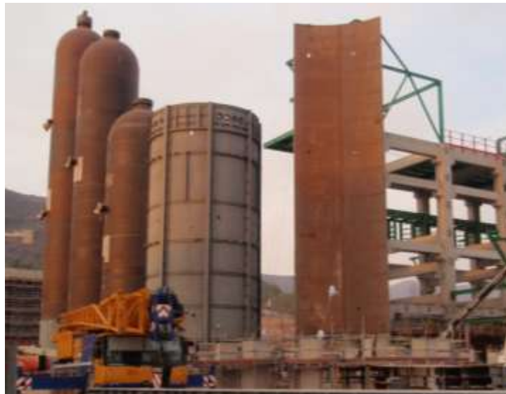
Montaje de los reactores, hornos y encofrado chimenea.
