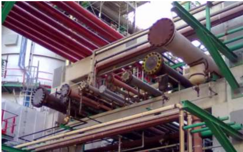
Pozos de goteo con salida para trampa de vapor y drenaje.
