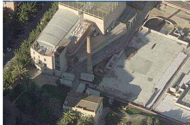
Imagen nº76. Vista aérea chimenea. 119
