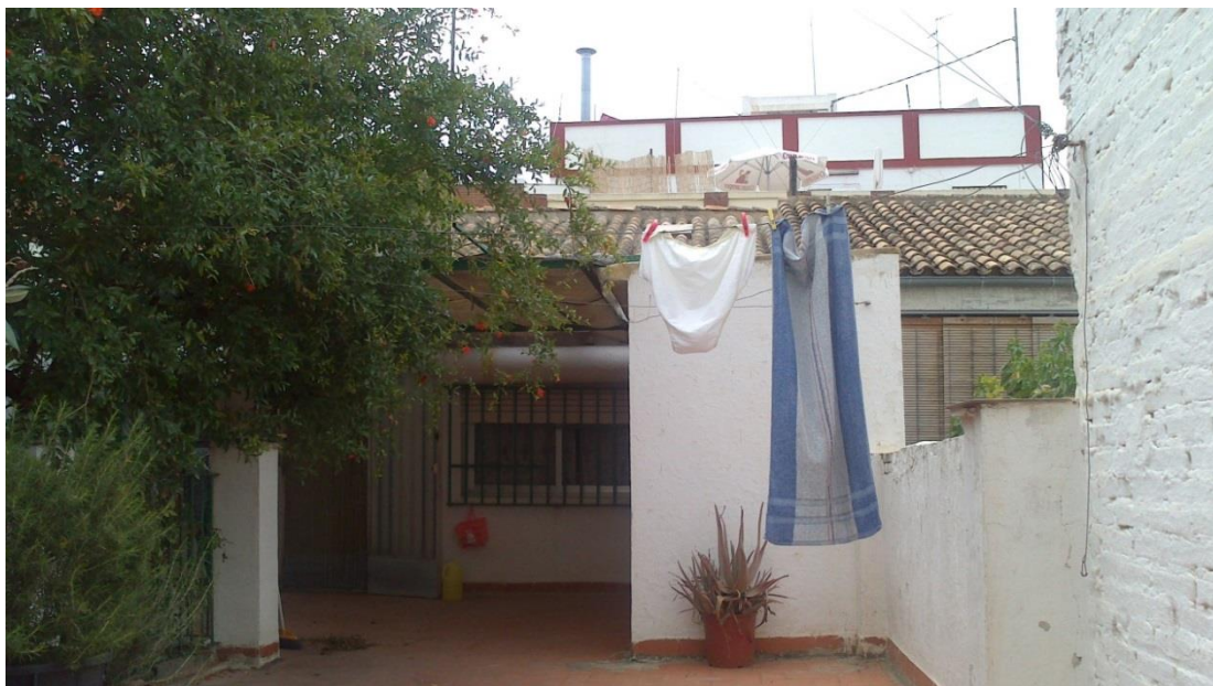
Imagen nº118. Cubierta de vivienda en la c/ Maestro Caballero, 2013.
