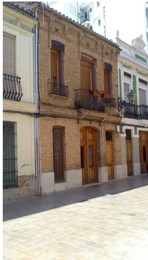
Imagen 122A. Acabado exterior de vivienda en la c/ Puzol 9, 2013.
