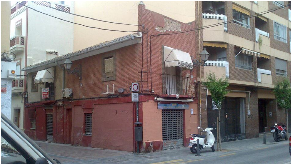
Imagen nº103. Edificación superficie inferior a la mínima en c/ Barón de San Petrillo, 2013.
