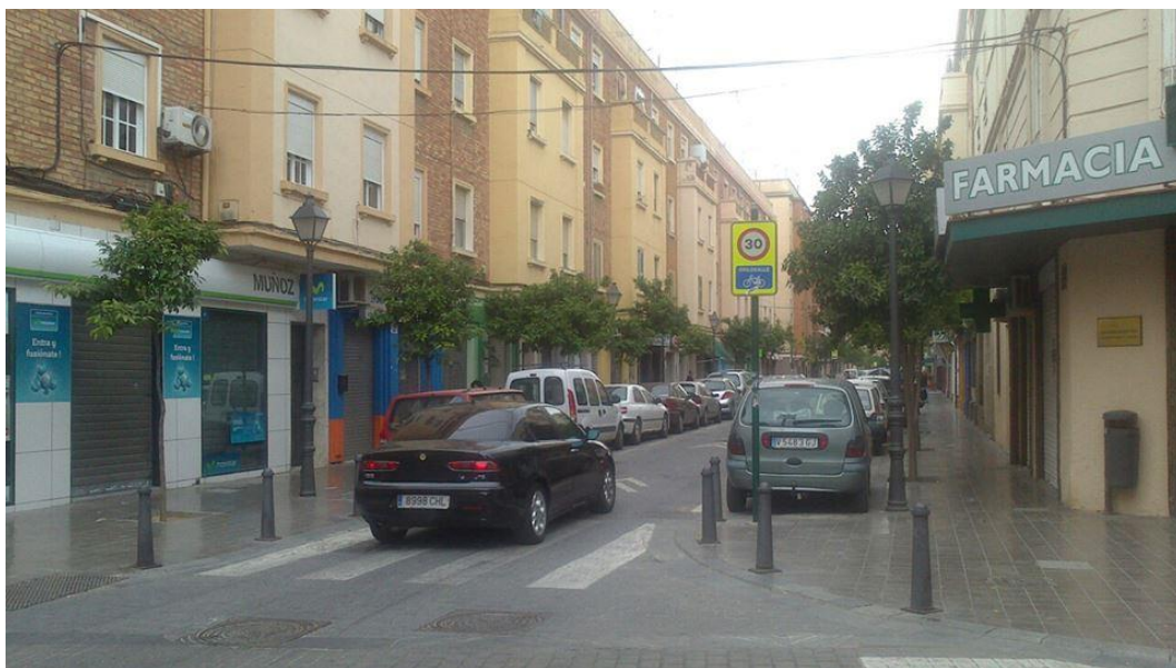
Imagen nº125.Fachadas bloque de edificio en c/ Enrique Navarro, 2013.
