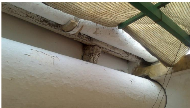
Imagen nº112. Cubierta de una vivienda en la c/ Maestro caballero, 2013.
