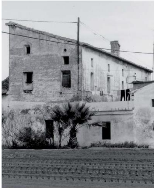
Imagen nº83. Alquería de Serra. 131
