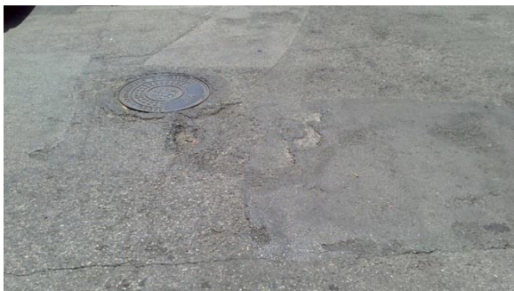
Imagen nº191. Parcheado mal ejecutado en Cruce c/ Benicarló – c/de Viver.
