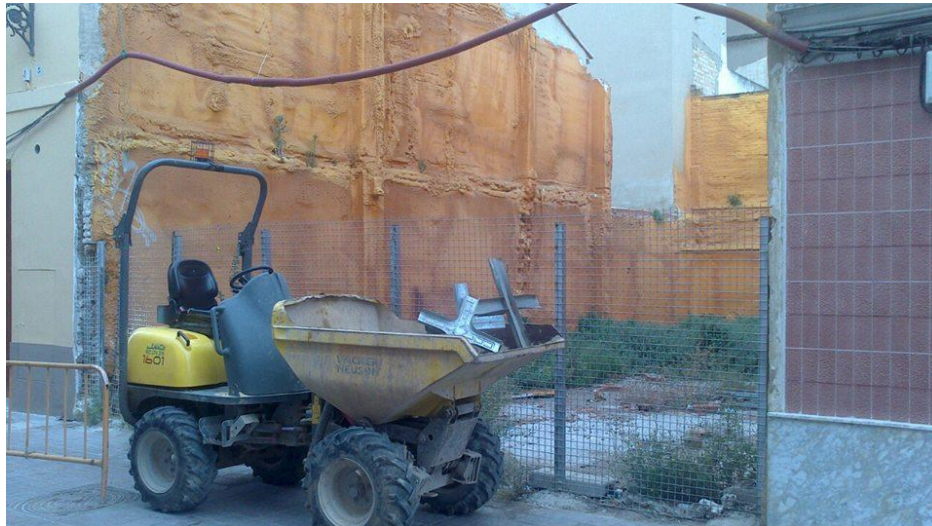
Imagen nº105. Solar en fase acondicionamiento para su edificación, 2013.
