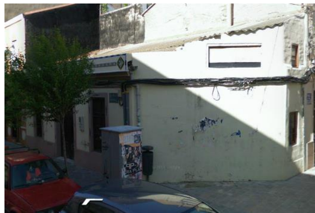
Imagen nº113. Vivienda de una altura en la calle Mistral., 2013.
