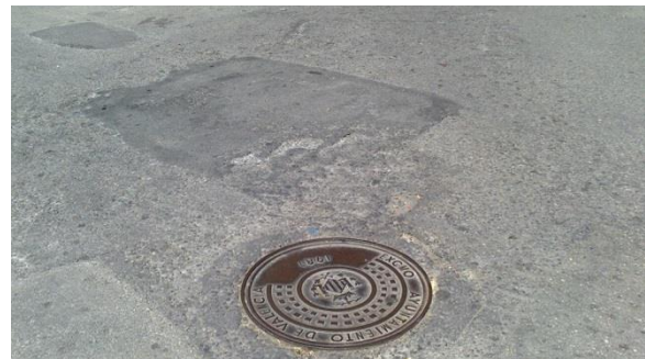
Imagen nº191. Parcheado mal ejecutado en Cruce c/ Benicarló – c/de Viver.
