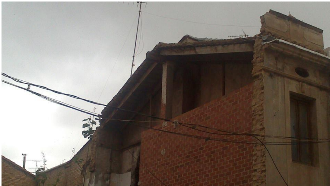
Imagen nº117. Cubierta de vivienda en la c/Juan Giner, 2013.
