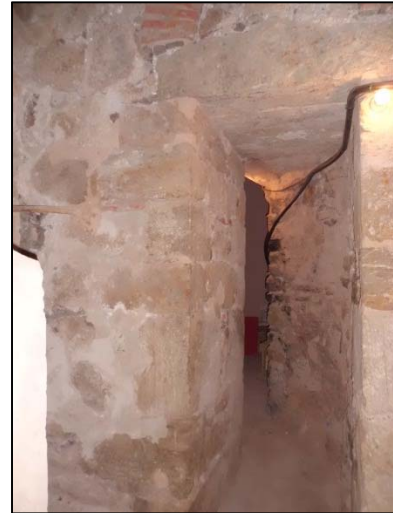
Figura 28: Acceso a la Torre
