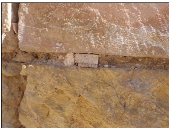
Figura 19: Colocación de cuñas
