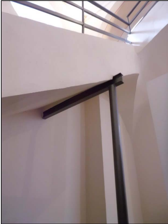
Figura 35: Escalera tabicada sobre soporte metálico
