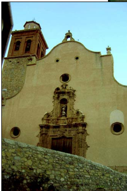
Figura 17: Vista de la entrada principal a la Iglesia de la Inmaculada Concepción.
