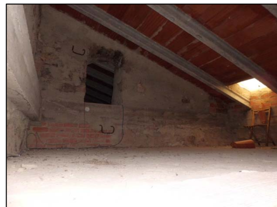
Figura 30: Viguetas de la cubierta
