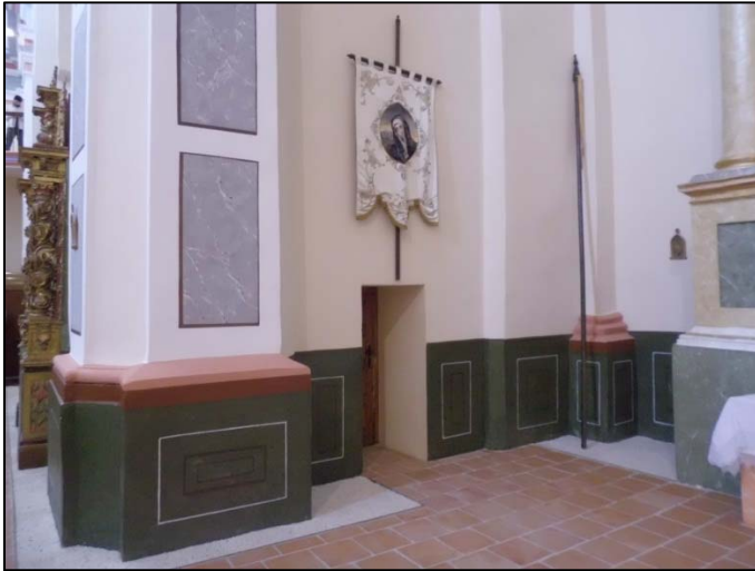
Figura 27: Vista de puerta principal de acceso a la capilla
