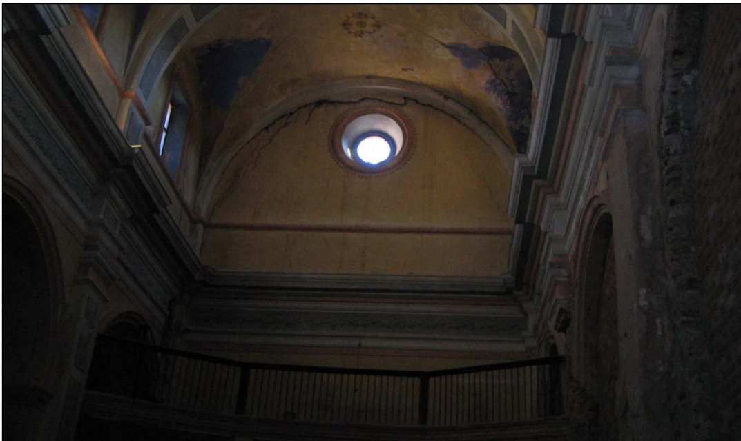
Figura 65: Grieta que muestra cómo se separó la fachada principal del resto de elementos. (José Torrent Martínez).
