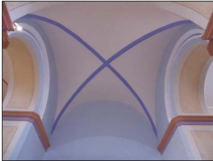
Figura 25: Bóveda de crucería
