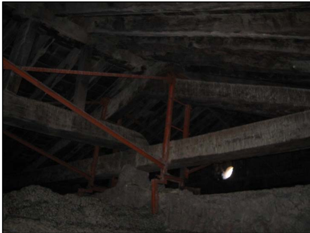
Figura 60: Cercha de madera de la cubierta. (José Torrent Martínez).
