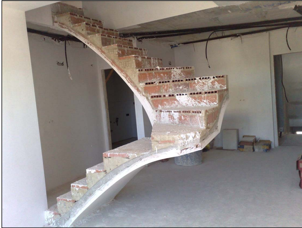
Figura 102: Escalera tabicada de dos roscas.
