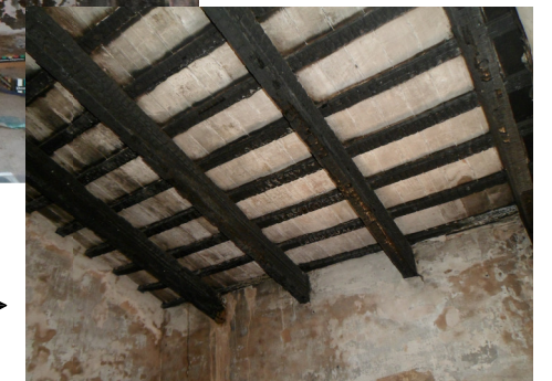
▲ La zona afectada por el incendio presenta un estado ennegrecido a causa del hollín en la imagen de arriba se ve una habitación que tiene falso techo y protegio la estructura frente al incendio, en la imagen de la derecha se observa el estado de la estructura que no estaba protegida.
