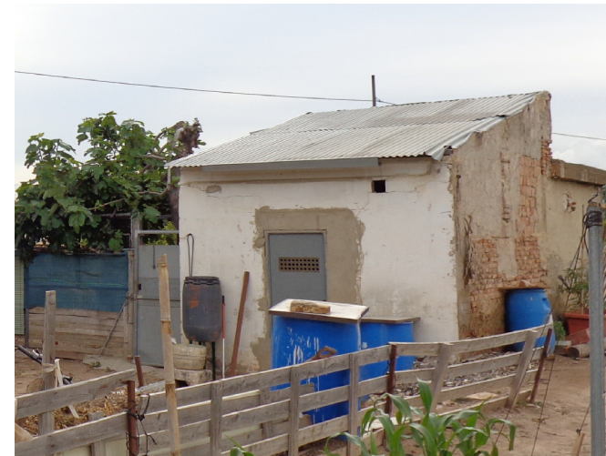
▲ Fachada edificación adyacente 1.
