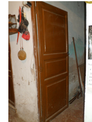
◀ Carpinterías interiores de madera
