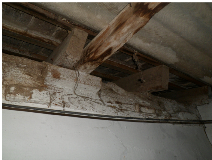
Apoyo viga de cubierta de placa ondulada de fibrocemento
