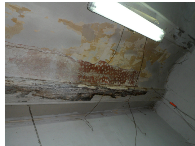
▲ Cara inferior del forjado de Planta Primera de la zona ZC.
