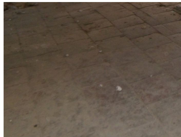
Pavimento general de Planta Primera
