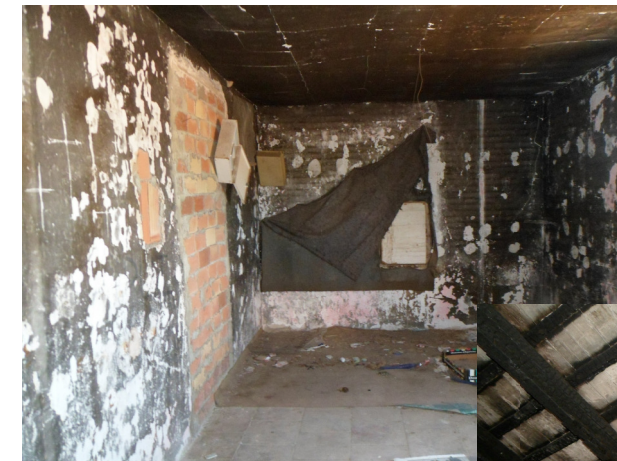
▲ La zona afectada por el incendio presenta un estado ennegrecido a causa del hollín en la imagen de arriba se ve una habitación que tiene falso techo y protegio la estructura frente al incendio, en la imagen de la derecha se observa el estado de la estructura que no estaba protegida.
