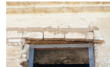
◀ Dintel realizado con viga de madera forrado con ladrillo macizo.
