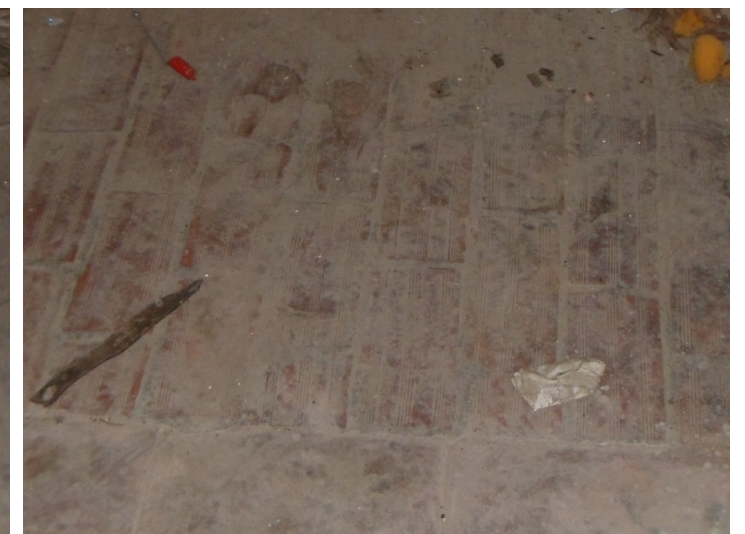
Pavimento habitación 5 Planta Primera
