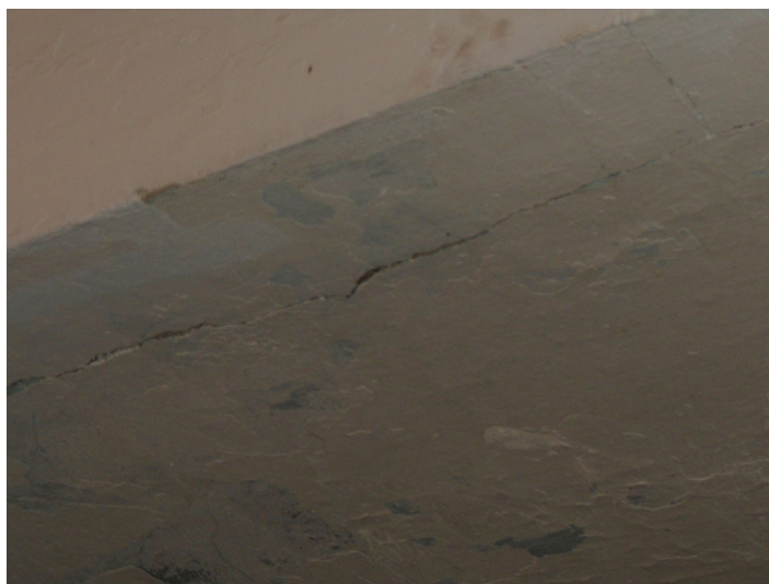
Falso techo estancia central 1
