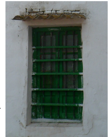
▶ Carpintería de madera con rejas ancladas al marco de la ventana y hojas abatibles acristaladas y contraventanas ciegas.
