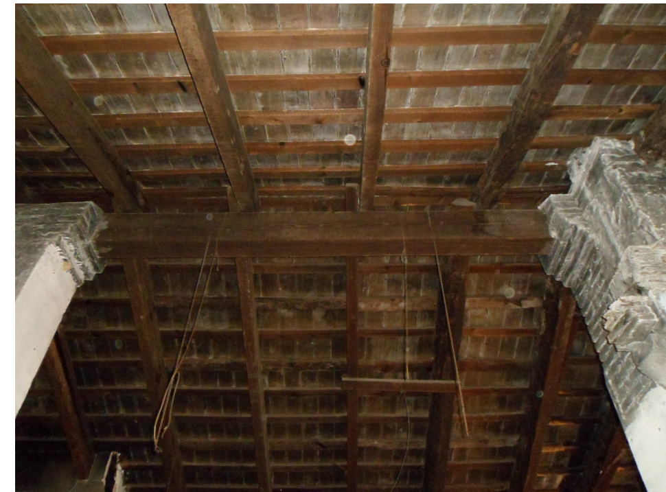
▲ Cara inferior de la estructura portante de cubierta y tablero de ladrillo macizo.
