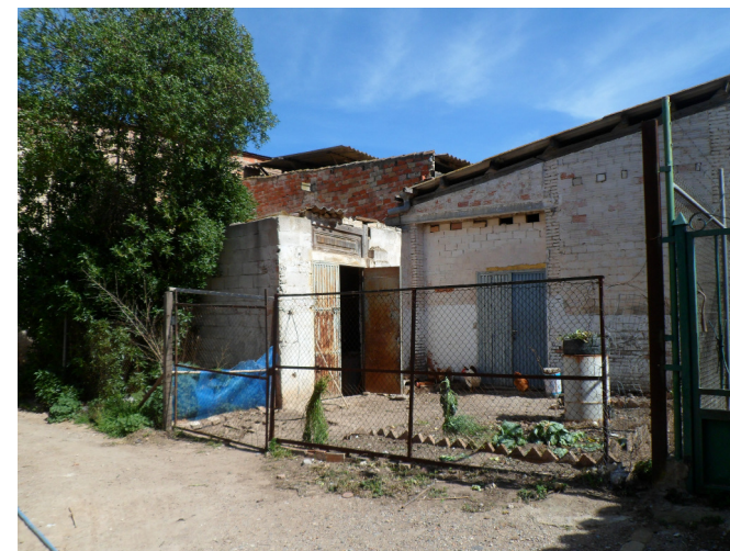
▲ Fachada edificación adyacente 2
