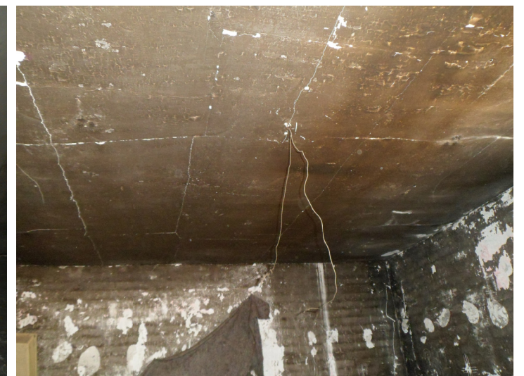
Falso techo habitación 7
