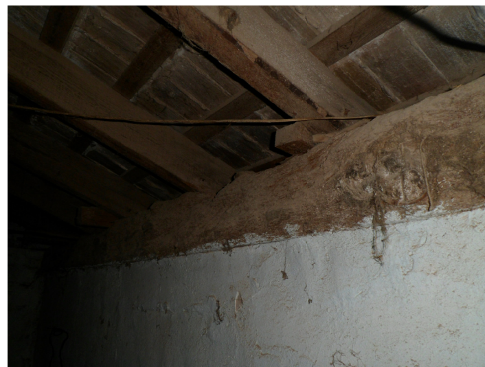
Viga de apoyo de pares cubierta posterior
