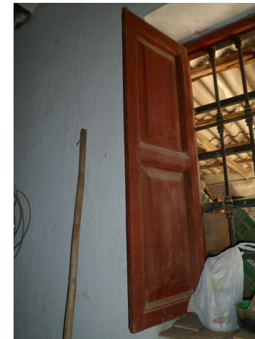
◀ Carpintería de madera con rejas ancladas al marco de la ventana y hojas abatibles ciegas.
