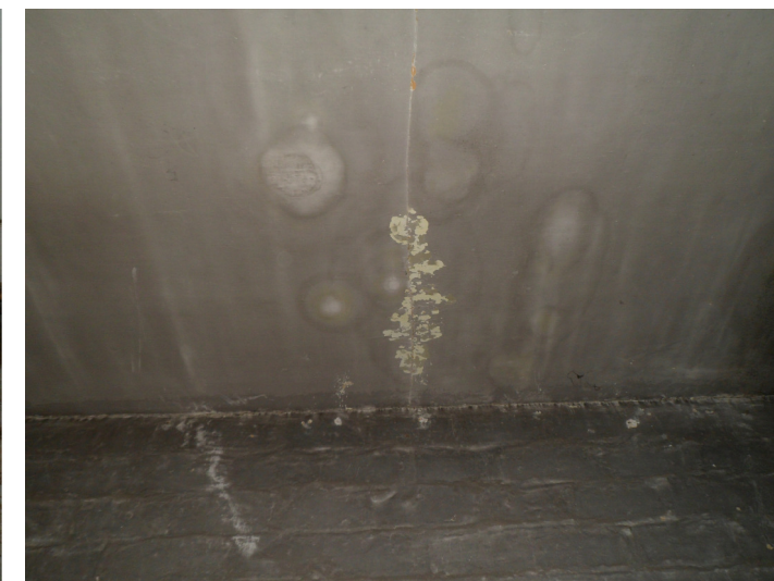
Falso techo habitación 5
