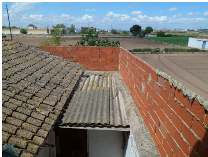
Cubierta de placa ondulada de fibrocemento de leñera y trastero
