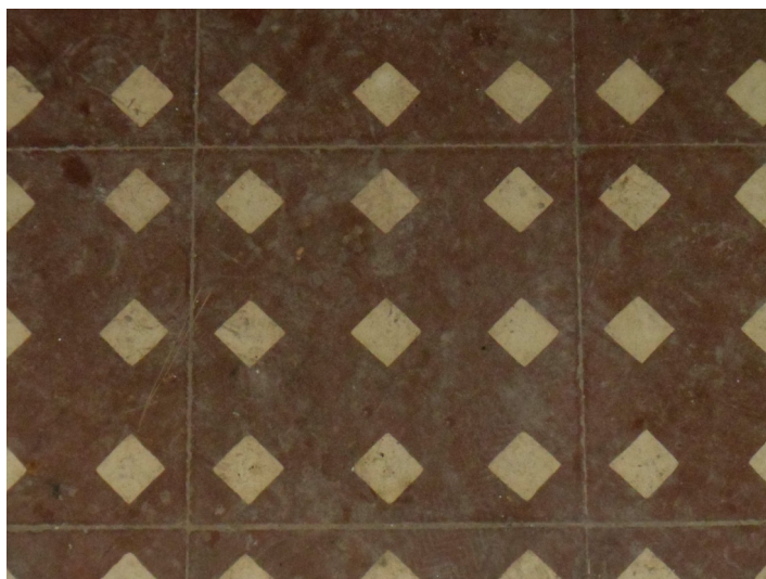
Pavimento de la cocina
