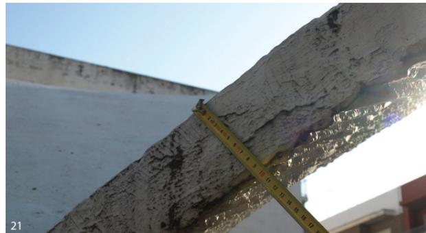
Toma de muestras del espesor de los paraboloides in situ
