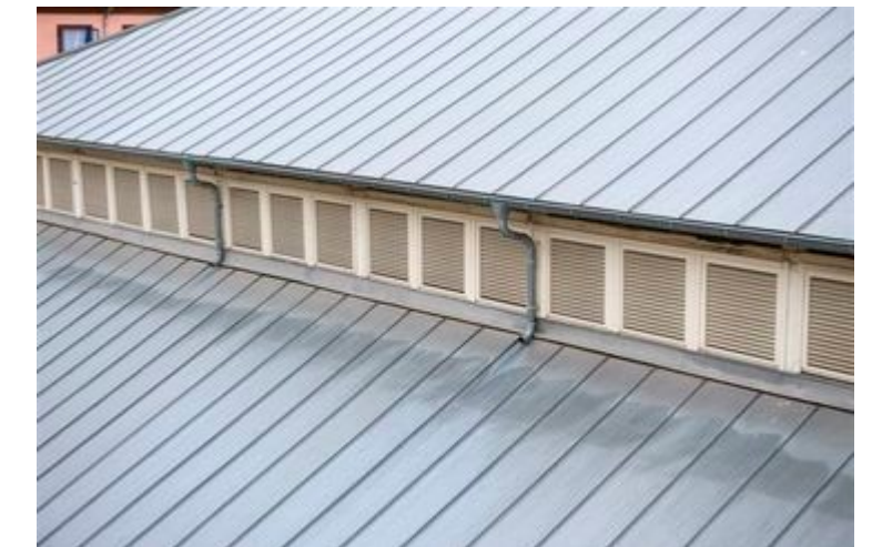
Coberta de zinc
