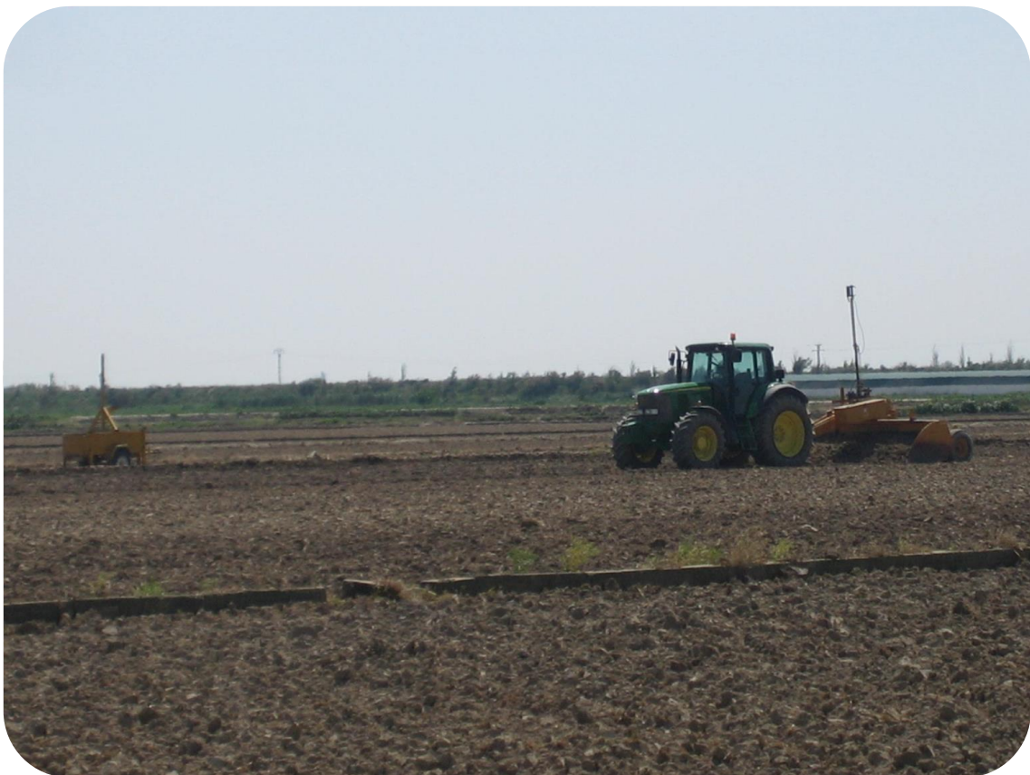
Nivelación del terreno mediante tecnología laser
