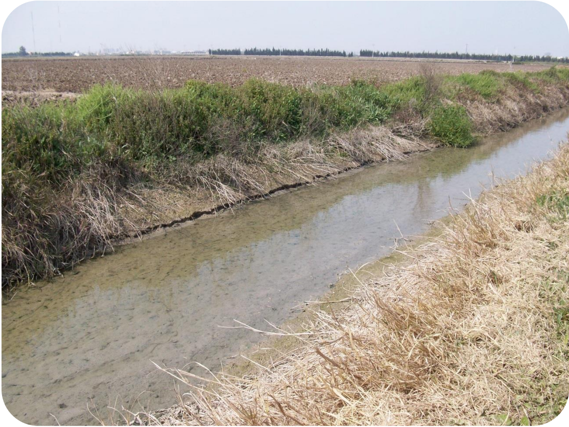
Acequia sin caudal en el período de preparación de campos
