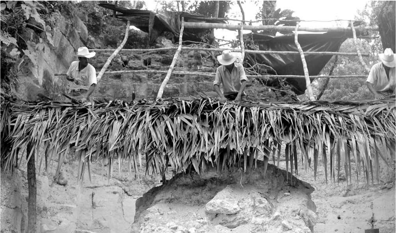
Figura 3. Construcción de una cubierta con materiales reversibles, destinada a proteger uno de los cuartos de la Acrópolis tras su inmediata excavación
