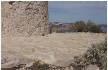
**CERRAMIENTO:** ejecutado con mampostería y mortero de cal, se aprecia en algunas zonas restos del antiguo enfoscado.
