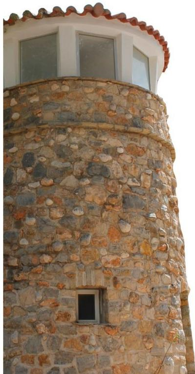
Actualmente consta de un primer cuerpo troncocónico de cinco metros y medio de altura, aunque los indicios señalan que en su estado primario la envergadura en altura sería mayor. Su diámetro en la base es de cuatro metros y medio sobre el cual se ha ejecutado un volumen sin conexión con el anterior tipo mirador acristalado, a modo de cerramiento superior la fisonomía actual de la torre presenta una cubierta inclinada de teja cerámica curva.
