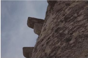
**CORSERA:** constituida por varios elementos aislados realizados en sillares tallados, que rodean todo el perímetro superior de la torre y sirven además de apoyo para el matican.
