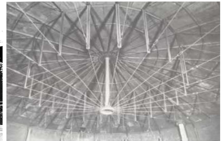
Interior de la cubierta del gasómetro
