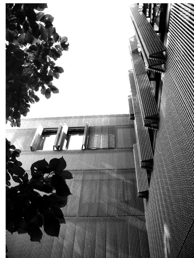
Detalle lamas metálicas
