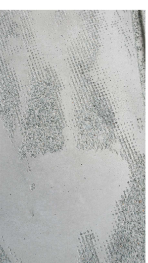
técnica de hormigón impreso
