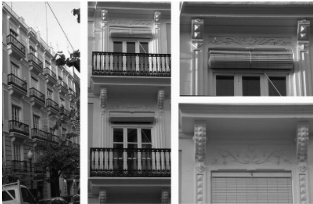
Figura 3 Edificio en la calle Cirilo Amorós nº 45 Construido en la última década del XIX. Según consta en los Archivos Municipales, en los años treinta se solicitó licencia para incrementar una planta. La sobre-elevación se llevó a cabo reproduciendo el sistema de huecos y la decoración de las plantas inferiores. La continuidad de los oficios y de la producción industrial permitió que, como se puede observar en las imágenes, se pudiera encontrar el mismo modelo de cerrajería de fundición. No sucedió lo mismo con la decoración de las bandejas de los balcones, utilizándose moldes de escayola con un dibujo levemente parecido.
