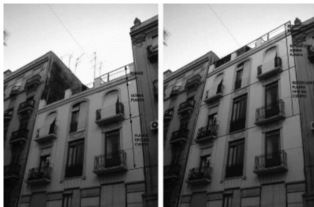
Figura 6 Figuración de una alteración de volumen por sobre-elevación conforme ordenación individualizada del PEP-2
