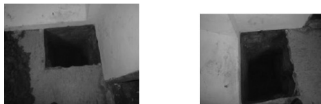
Figura 3. Cata realizada en el suelo de la base del pilar de esquina
