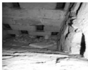
Figura 6. Análisis estructural del edificio; a) Muros de carga de ladrillo; b) Forjado de bóvedas tabicadas apoyando en los perfiles IPN
