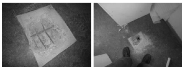
Figura 4. Cata en forjado de suelo planta 1ª y 2ª
