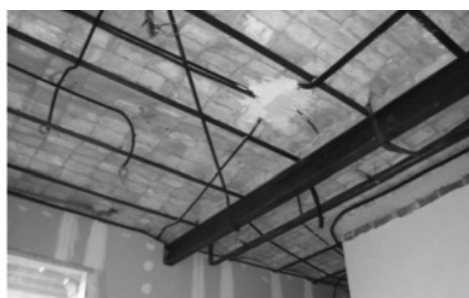
Figura 6. Análisis estructural del edificio; a) Muros de carga de ladrillo; b) Forjado de bóvedas tabicadas apoyando en los perfiles IPN
