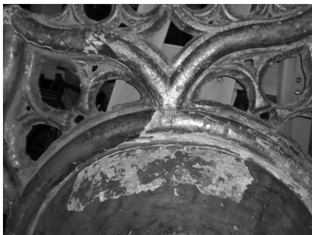
Figura 2. Proceso de limpieza y eliminación del dorado
