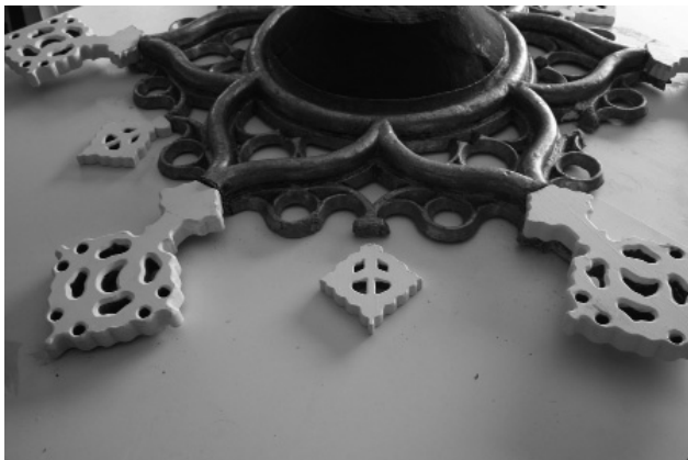
Figura 6. Piezas mecanizadas ubicadas en su lugar mediante tubillones
