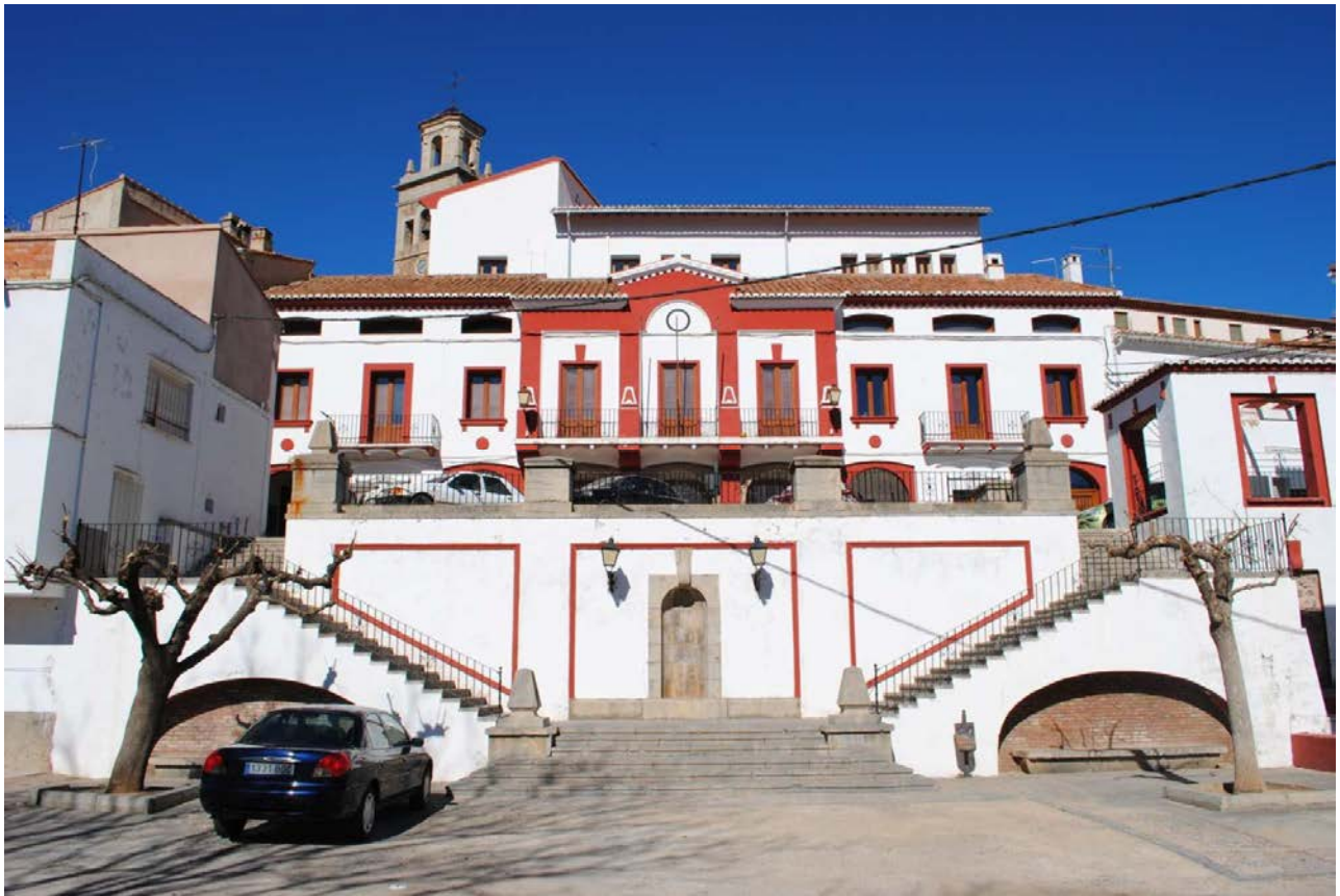
FOTOGRAFIA DESDE LA CARRETERA (ZONA BAJA). 2012
