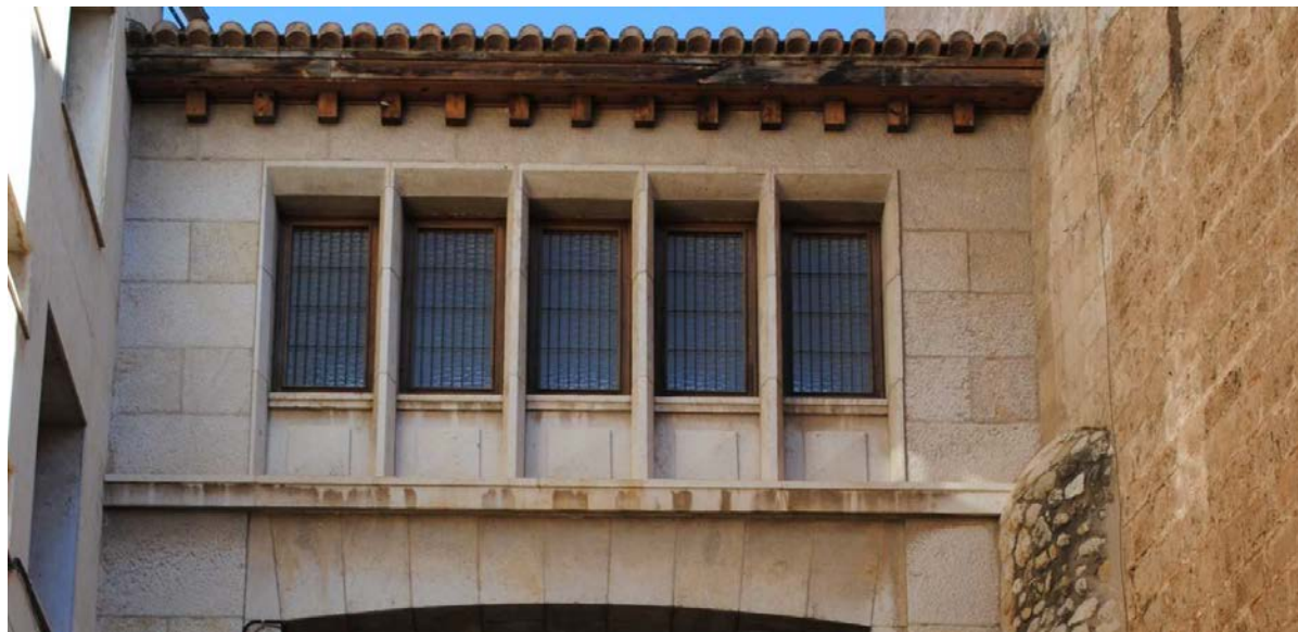
FOTOGRAFIA PUENTE PALACIO-CATEDRAL
