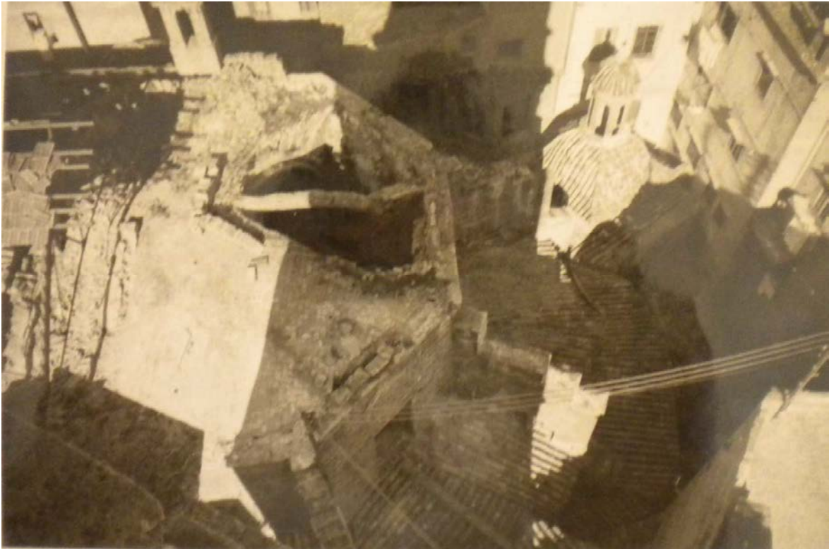
FOTOGRAFIAS DEL ESTADO PREVIO A LA INTERVENCIÓN
