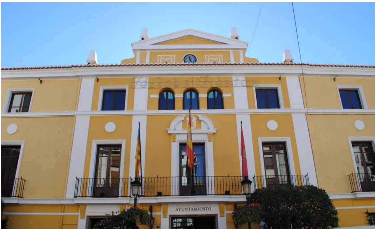
FOTOGRAFIAS FACHADA PRINCIPAL
