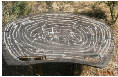
Figura 63. Base de panel sin panel. Fuente: Elaboración propia
