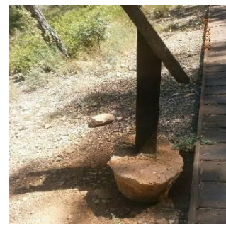
Figura 66. Base de un panel fuera del suelo. Fuente: Elaboración propia
