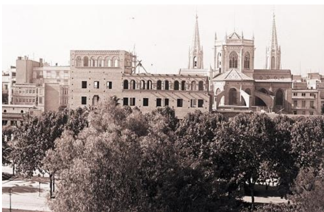
Colegio Dominicos en construcción.
