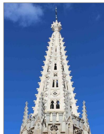
Aguja de la torre restaurada.
