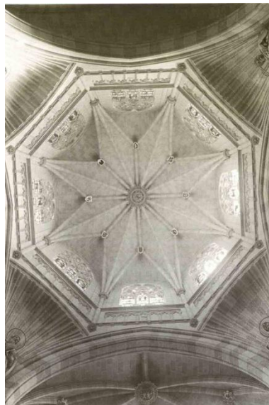
Vidrieras originales del cimborrio.
