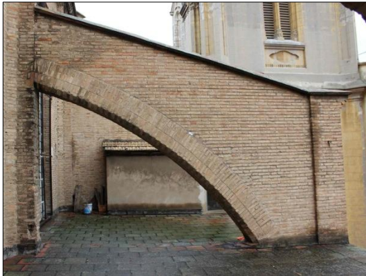
Arco Arbotante de ladrillo macizo de la Basílica San Vicente Ferrer.
