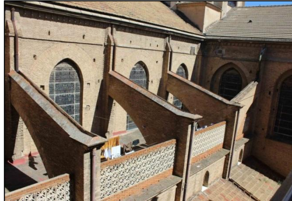
Arbotantes y vista de su desagüe de la Basílica San Vicente Ferrer.
