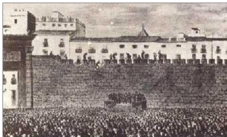
Derribo de la muralla de Valencia
