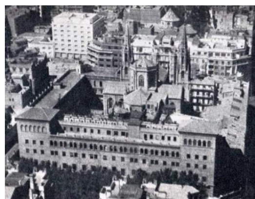
Vista aérea manzana de los Dominicos.
