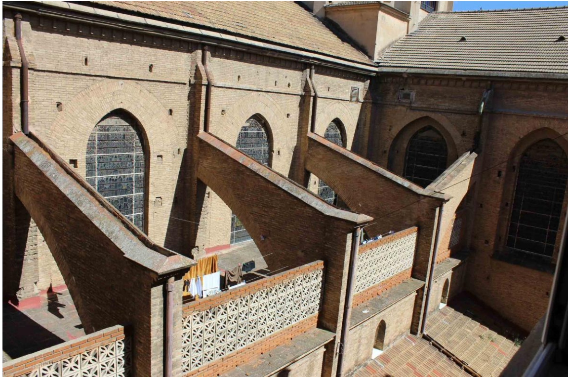
Exterior de la Iglesia. Vista de los arbotantes
