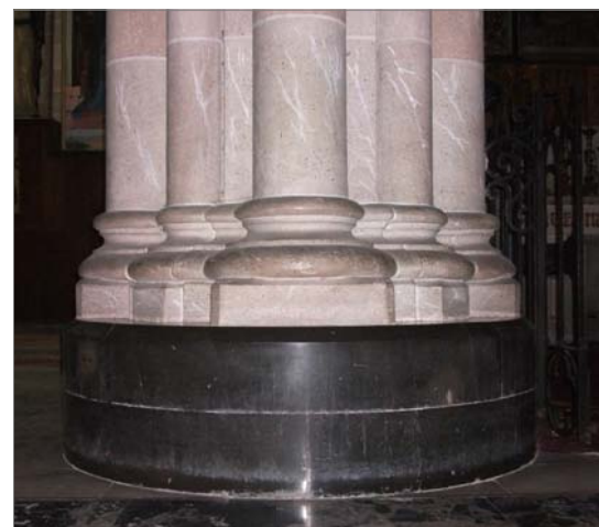
Perímetro del nervio menor 0.40m Perímetro del nervio mayor 0.70m Lado del cuadrado que inscribe a la pilastra 1.75m
