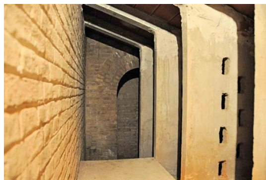
Cubierta inclinada de la las capillas con tabiquillos conejeros.
