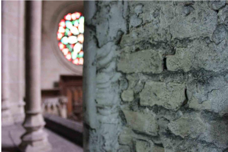
Hollín posado en el interior del triforio.
