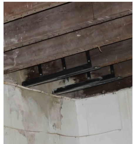
Refuerzo de dos vigas ya existente
