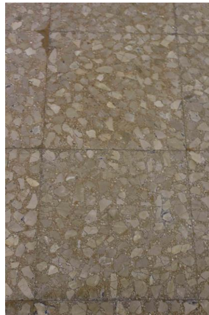
Pavimento Actual de terrazo color pardo.
