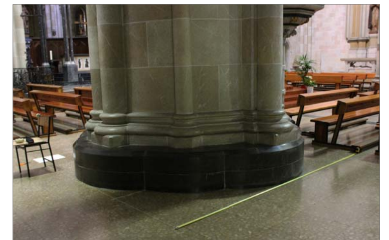
Perímetro del nervio menor 0.40m Perímetro del nervio mayor 0.70m Lado del cuadrado que inscribe a la pilastra 3.65m
