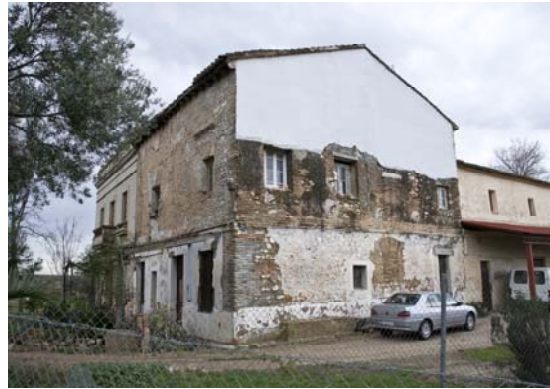
Fachada lateral-Norte. (Fuente propia)
