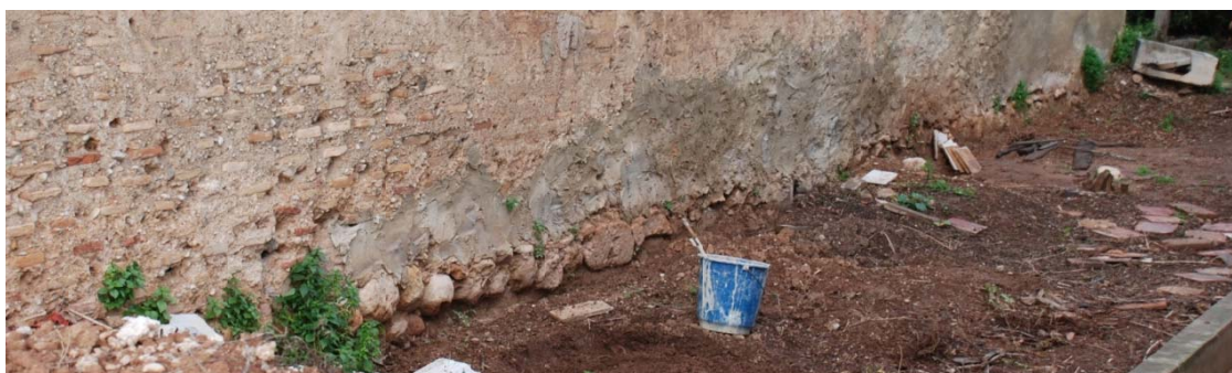
Fotografía de la fachada Sur donde se aprecia el arranque del muro y la tipología de cimentación. (Fuente propia)
