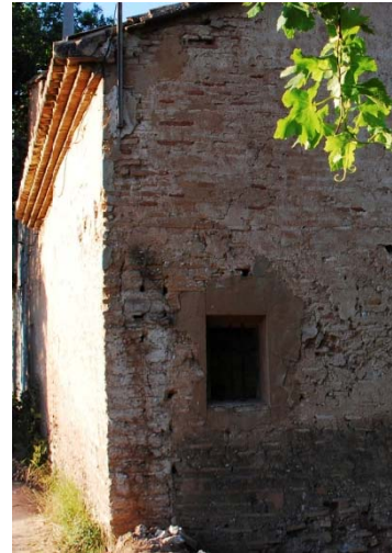
Fachada oeste. (Fuente propia)
