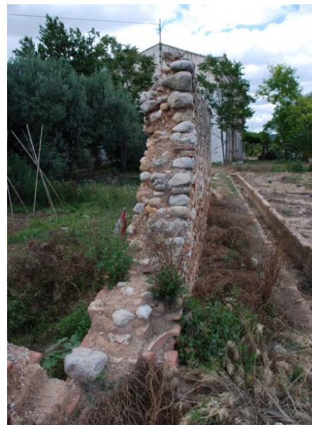
Parte lateral del muro. (Fuente propia)
