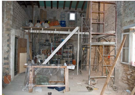
Vista a la izquierda desde acceso a planta superior. (Fuente propia)
