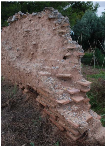
Parte trasera del muro perimetral. (Fuente propia)
