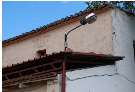
Tejado metálico de fachado Norte. Bloque 1 (Fuente propia)
