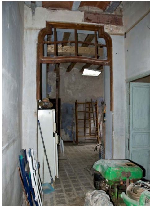
Espacio de comunicación entre pasillo y la Llar desde puerta principal. (Fuente propia)
