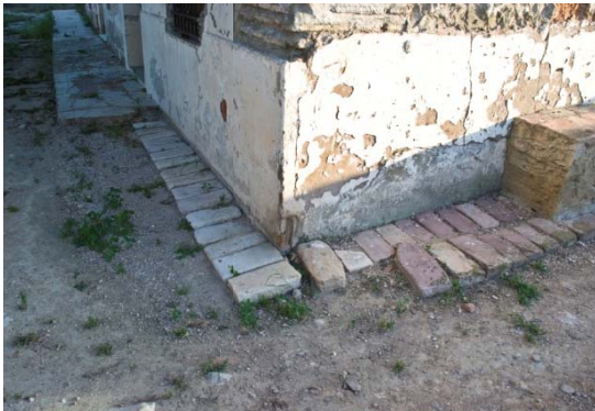
Esquina de fachada principal
