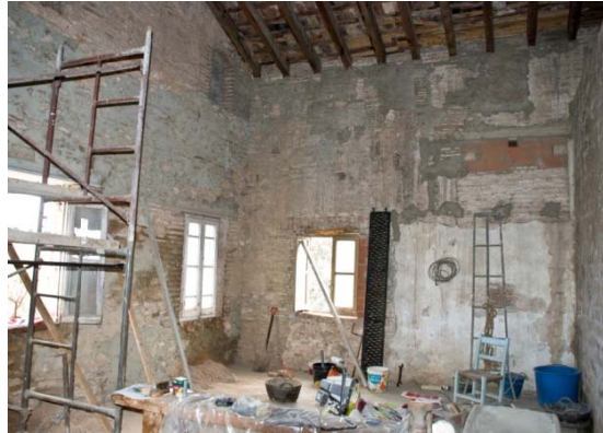
Vista a la derecha desde escaleras. (Fuente propia)
