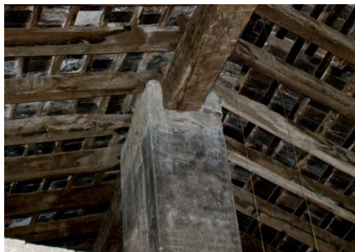
Apoya de viga de cumbrera. (Fuente Propia)
