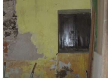
Paramento interior de fachada norte. (Fuente propia)
