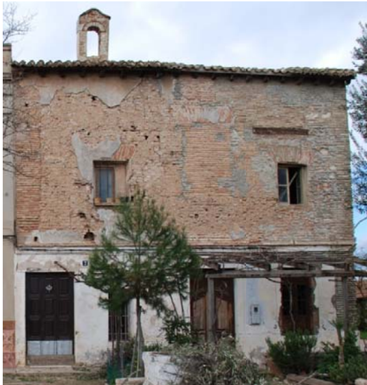
Fachada Este de ladrillo macizo de menos tamaño y mortero de tierra. (Fuente propia)
