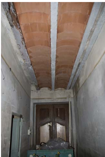
Abajo: sustitución de viguetas por viguetas de hormigón prefabricado. (Fuente propia)
