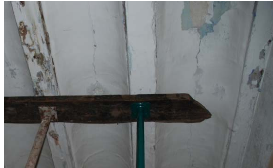
Viguetas Hab. 1 (Fuente propia)
