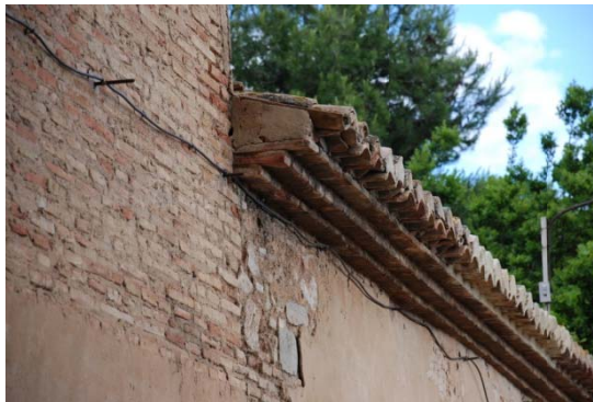
Cornisa Fachada Oeste. (Fuente propia)
