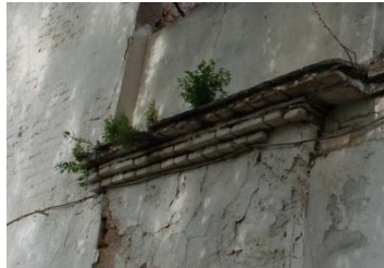
Cornisa fachada oeste. (Fuente propia)
