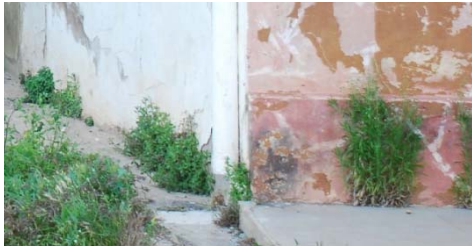
Zócalo bloque 4. (Fuente propia)
