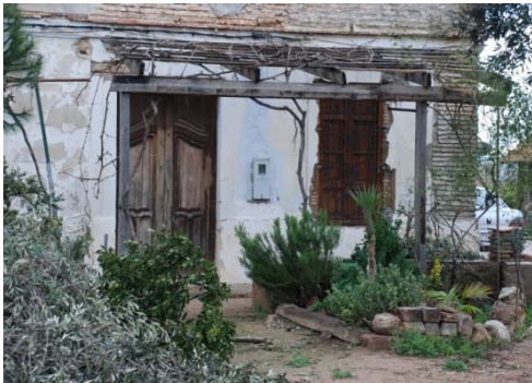
Entrada principal en fachada Este. (Fuente propia)
