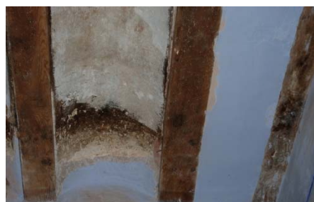
Viguetas pasillo. (Fuente propia)
