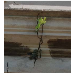
Antepecho bloque 4. (Fuente propia)
