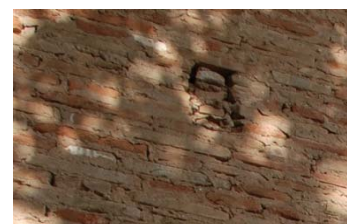
Fachada oeste. (Fuente propia)
