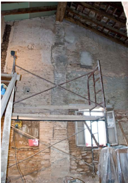
Vista del intradós del muro de fachada norte y pilar de apoyo de la viga de cumbrera. (Fuente propia)
