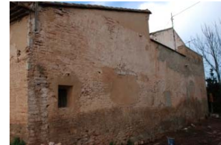
Fachada Sur. (Fuente propia)
