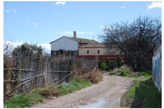
Acceso desde Ruta 2 hacia el camino lateral de la Alquería (Mandingorra). (Fuente propia)
