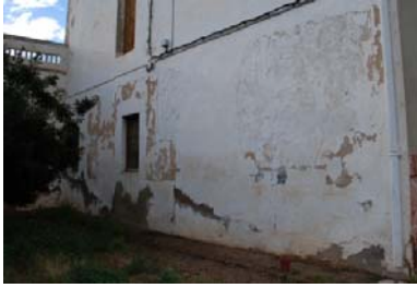
Fachada oeste. (Fuente propia)
