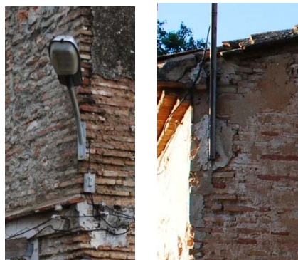
Farolas ancladas a la fábrica. (Fuente propia)
