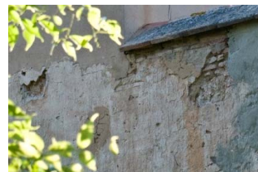
Fachada sur (Fuente propia)
