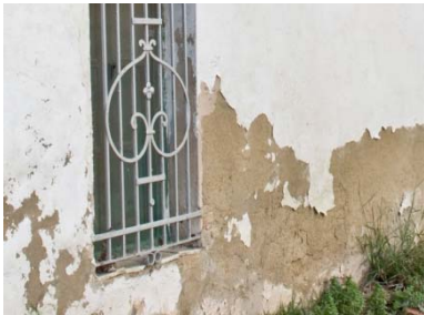
Fachada oeste. (Fuente propia)
