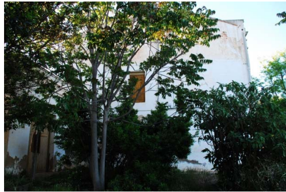
Fachada Sur bloque 4. (Fuente propia)
