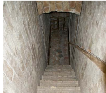
Vista interior de la escalera. (Fuente propia)
