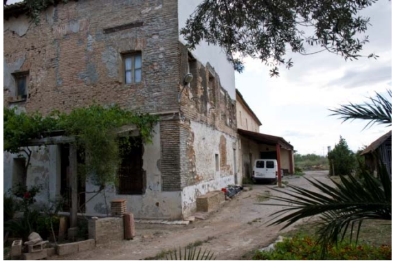
Camino lateral desde fachada principal. (Fuente propia)
