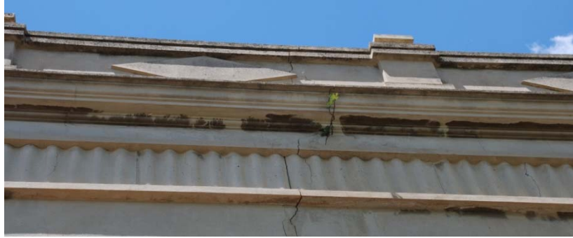
Antepecho de bloque 4. (Fuente propia)
