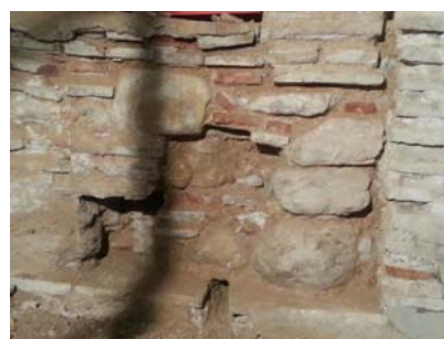
Foto del interior de la planta superior. Intradós del muro de fachada norte. (Fuente propia)
