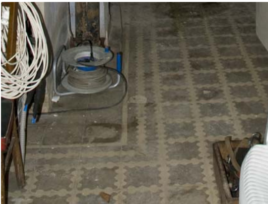
Pavimento colocado en el resto de la planta del bloque 2. Baldosa hidráulica de 20 x 20 cm sobre capa de tierra y cemento de agarre. (Fotografía propia)
