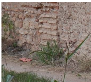
Fachada oeste. (Fuente propia)
