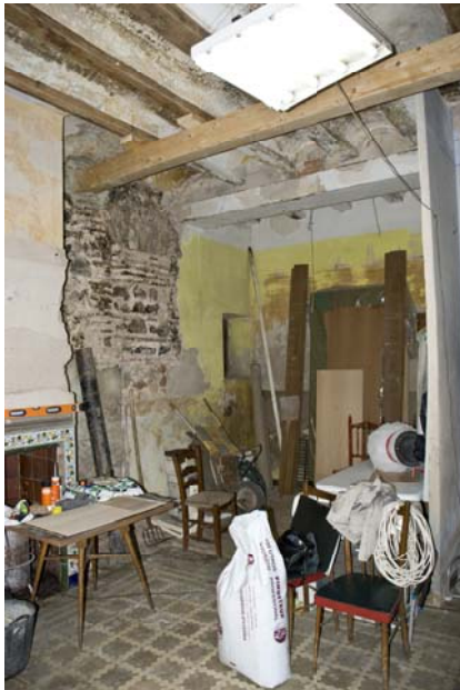
Arriba: Viga de apoyo con puntal y viga mixta.
