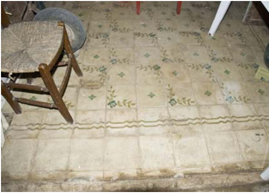
Pavimento colocado en la estancia 2 de menor tamaño. Baldosa hidráulica de 20 x 20 cm con motivos florales en tonos azulados verdosos. (Fotografía propia)
