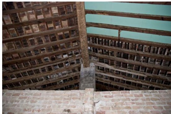
Apoyo de cumbrera y división de ladrillo de 3 cm. (Fuente propia)
