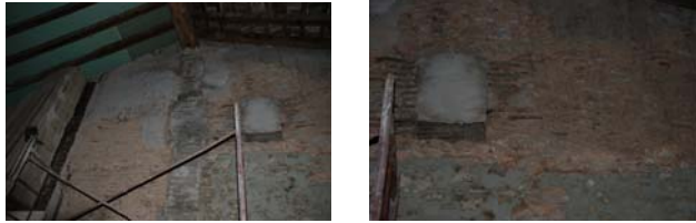
Reposiciones y rejuantados. Trasdós de fachada norte
