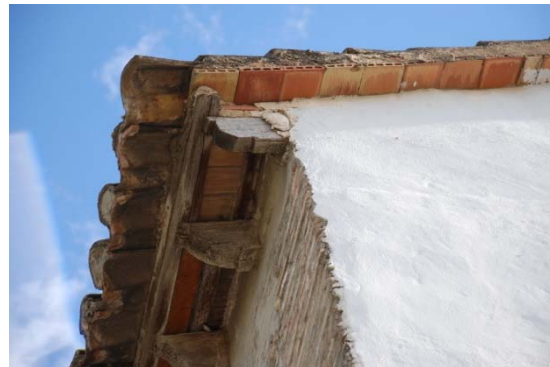
Alero fachada principal. Cabezas de viguetas y bocateja. (Fuente propia)
