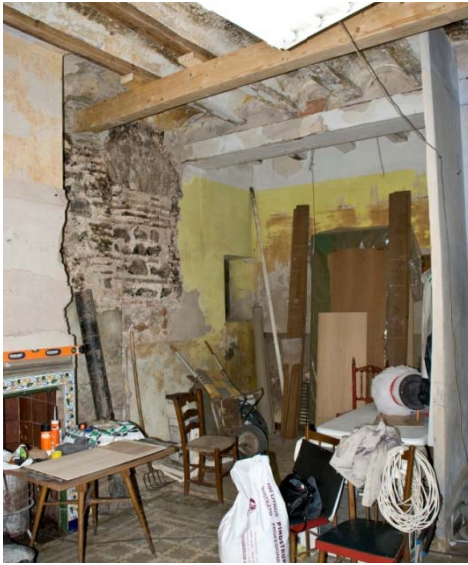
Zona de antigua Llar y estancia 2 al fondo. (Fuente propia)
