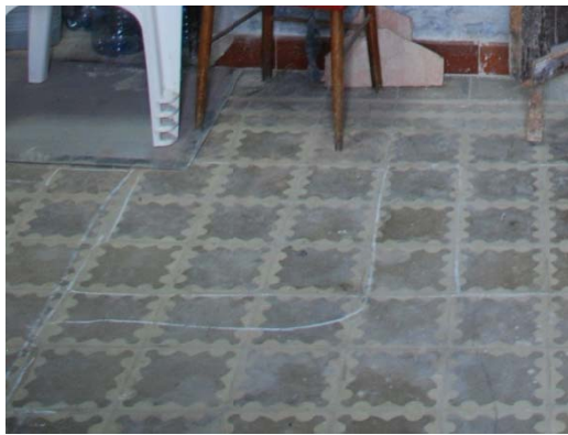
Pavimentos de espacios de comunicación. (Fuente propia)
