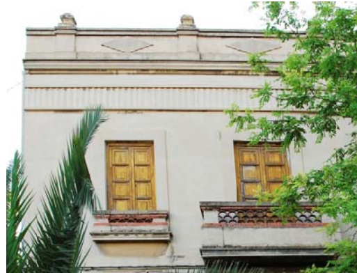
Fachada este bloque 4. (Fuente propia)
