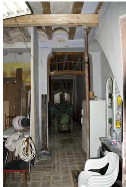
Arriba: Viga de apoyo con puntal y viga mixta.
