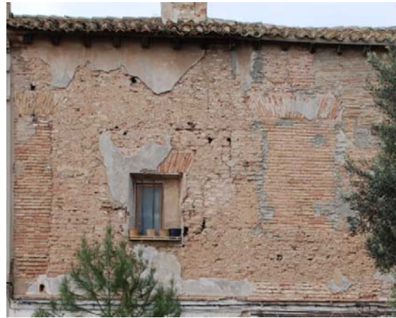
Fachada Este de ladrillo macizo de menos tamaño y mortero de tierra. (Fuente propia)
