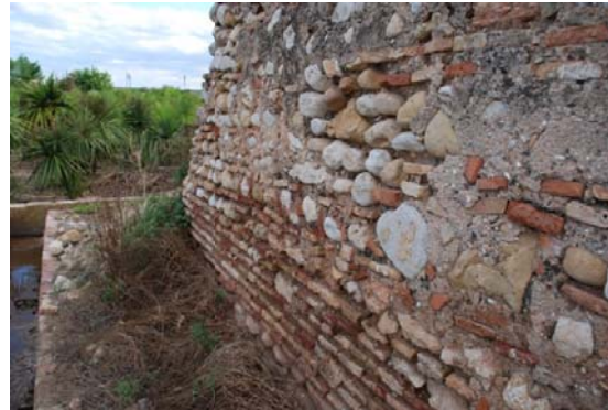
Composición del antiguo muro perimetral del corral. (Fuente propia)
