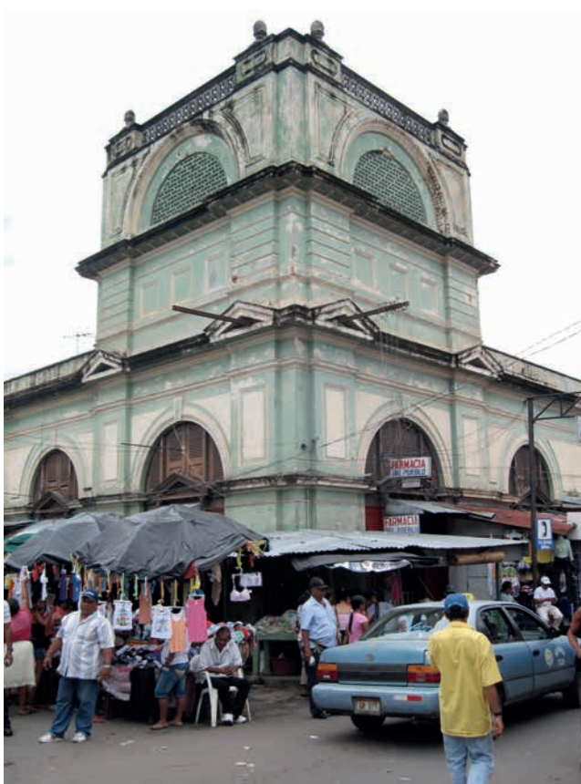
Edificio del mercado en Granada (Nicaragua). Fotografía: G. Muñoz.
