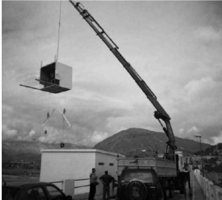
FIGURA 42 Trabajos de instalación de equipos para la sonda multiparamétrica autoposicionable (Fuente: www.chj.es )
