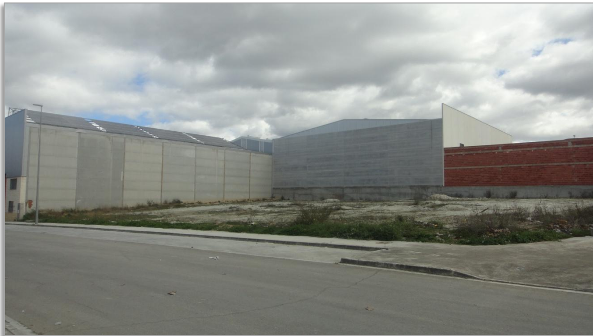
Fuente: Elaboración Propia. "Figura 6: Foto solar 1".
