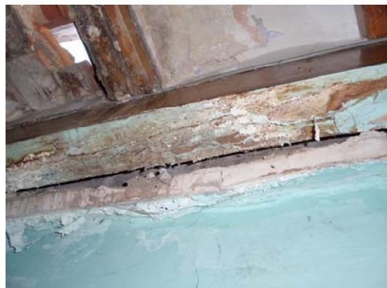
34 Ataque en las vigas de apoyo de viguetas
