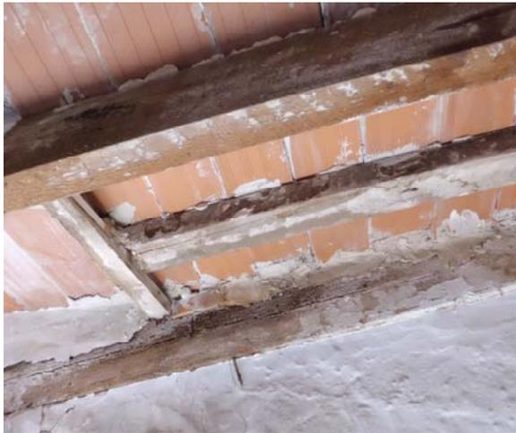
28 Filtración de la cubierta transitable
