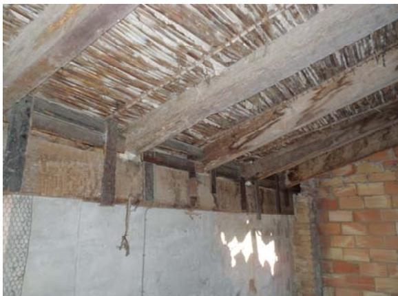
26 Filtraciones sobre las correas de la cubierta
