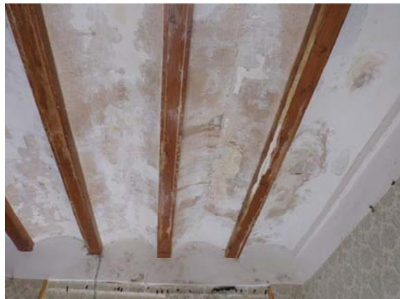
32 Condensación debido a los cambios de temperatura
