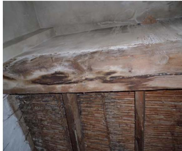
29 Filtración de la cubierta transitable forjado 2º
