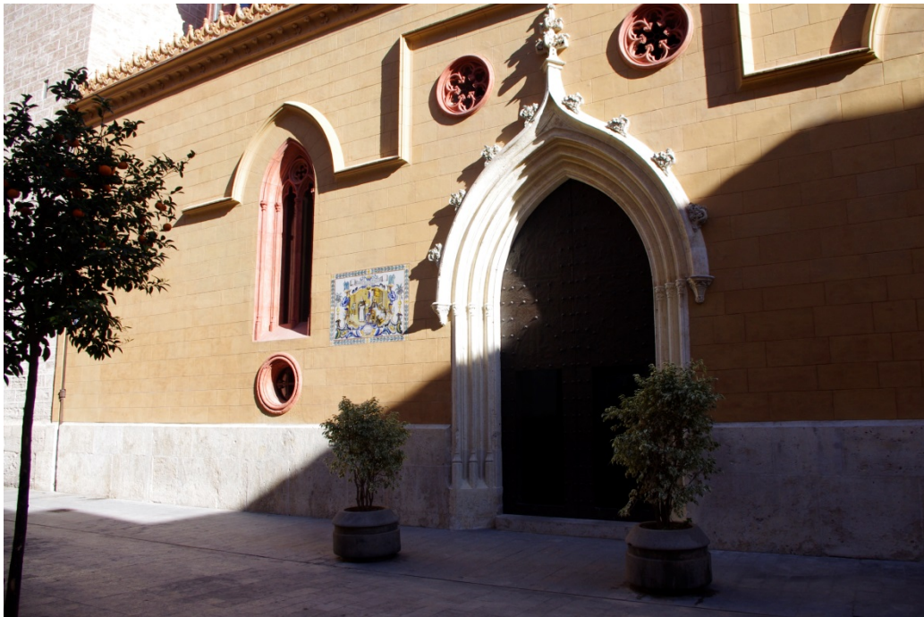
Fotografía 2.10. Fachada sur. (Plaza de San Nicolás)
