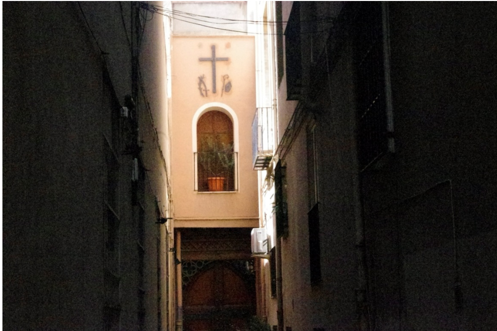
Fotografía 2.9. Fachada norte, vista desde el callejón de acceso al templo.
