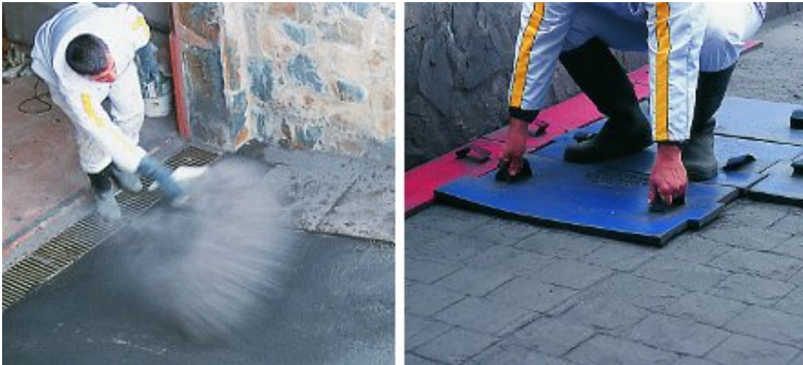
Gráficos 7.8 y 7.9. Aplicación de desmoldante y estampado
