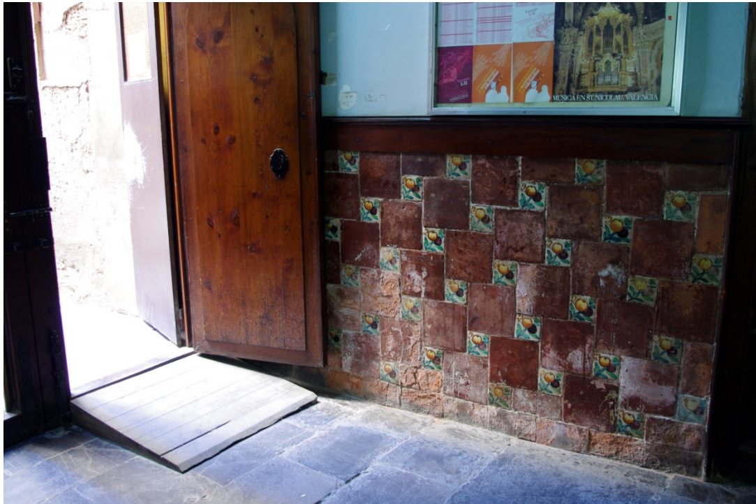
Fotografía 2.17. Interior del acceso desde el callejón de Caballeros 35.
