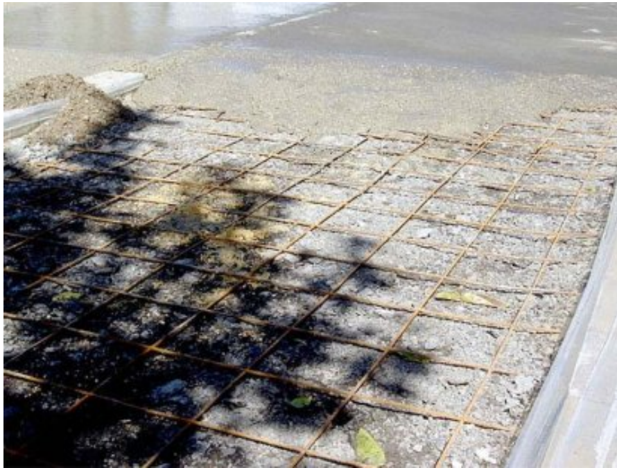
Gráfico 7.6. Hormigonado sobre mallazo electrosoldado.
