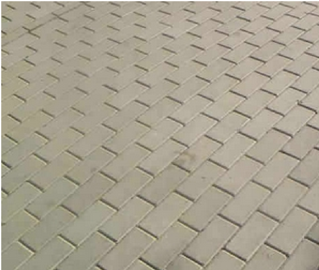
Gráfico 7.11. Acabado final del pavimento
