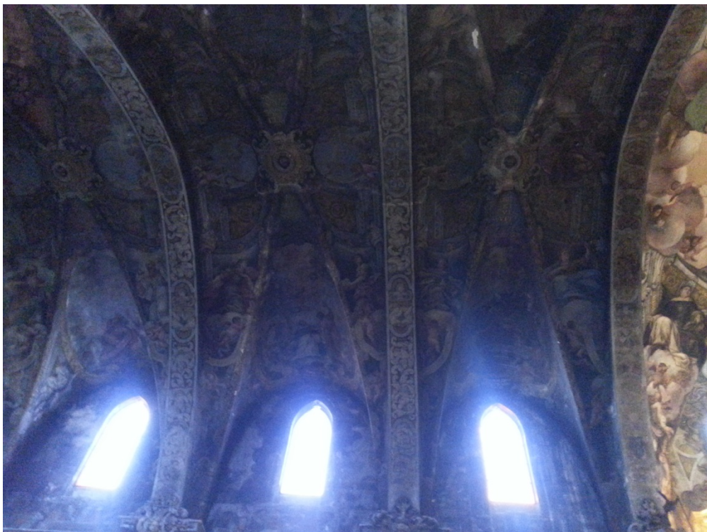
Gráfico 5.12. Revestido de plementería y pintado de frescos sobre bóveda de crucería.
