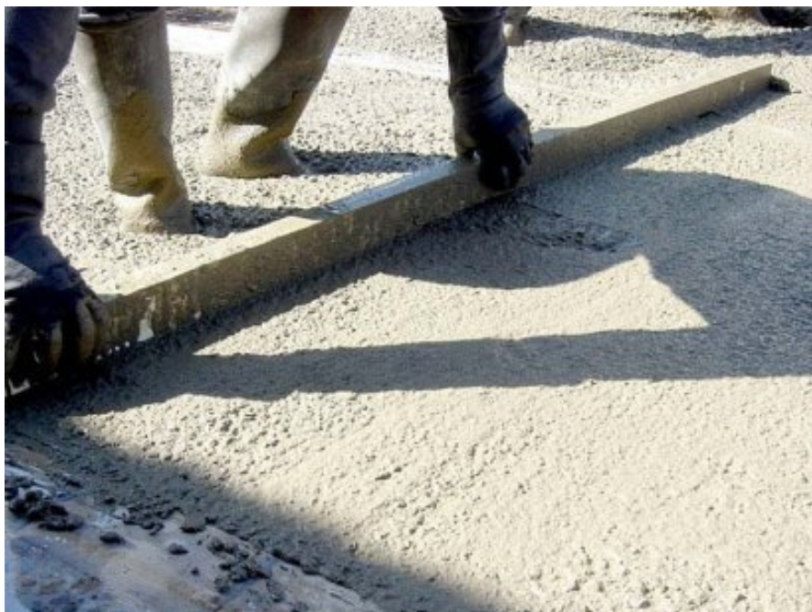
Gráfico 7.7. Ejecución de pendientes mediante reglas según planos adjuntos.
