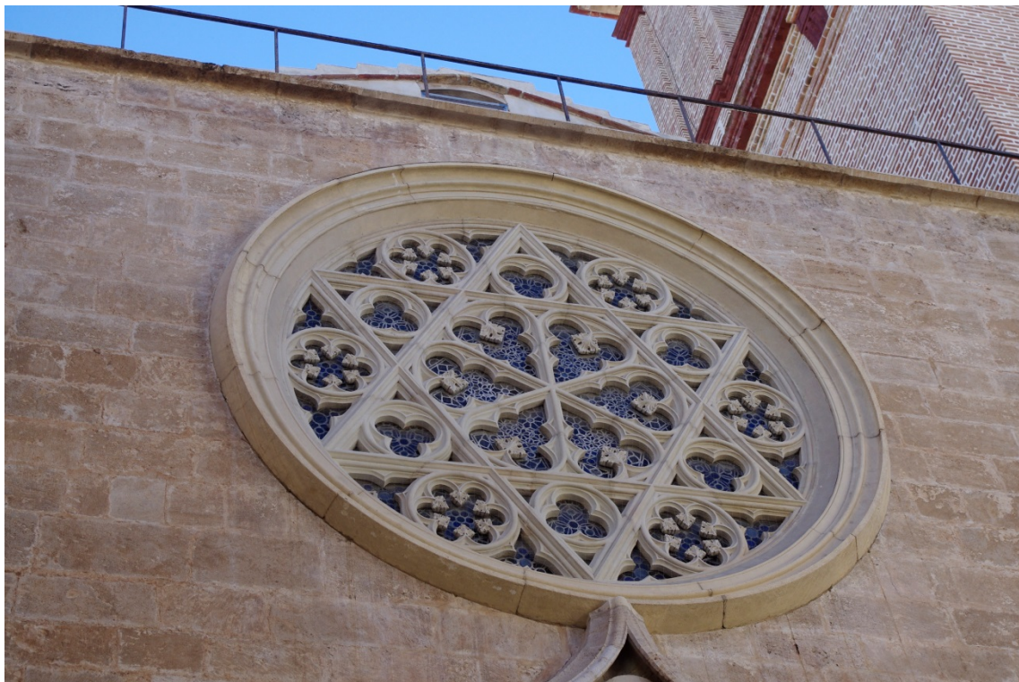
Fotografía 2.12. Óculo en fachada oeste.
