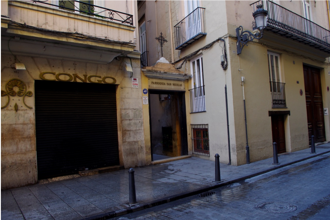
Fotografía 2.13. Acceso al callejón desde calle Caballeros, 35
