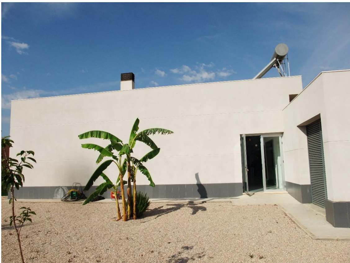
Figura IV.4: Salida a patio y cuarto de instalaciones (fachada noreste)
