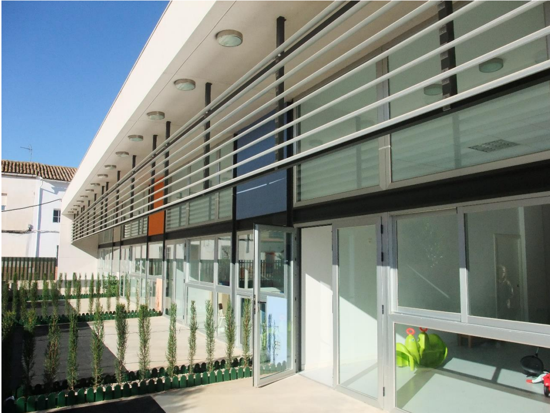
Figura 3.13: Huecos de la fachada sureste (aulas) recayente a patio.
