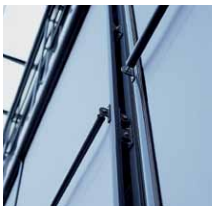
Seguro para el viento a partir de b_k / h_1 > 1/3
