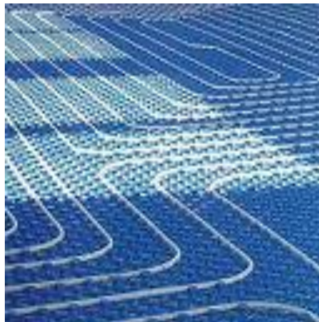
Figura 3.15: Instalación suelo radiante ( www.bisbalsl.es )
