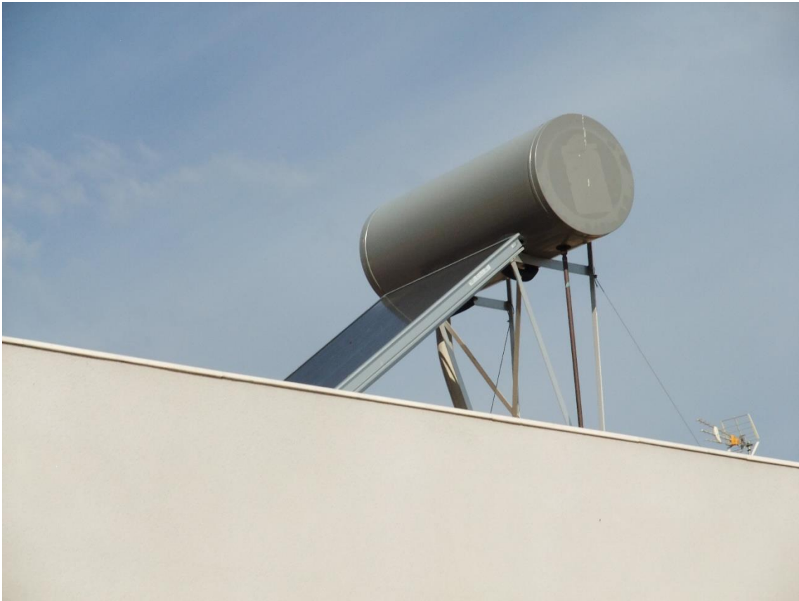
Figura IV.11: Placa solar ACS
