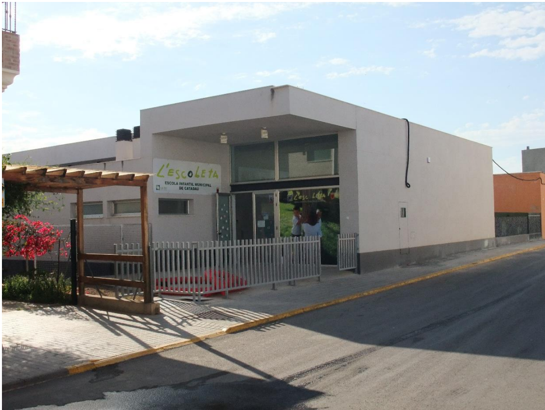
Figura IV.1: Entrada principal escuela infantil (fachada suroeste)
