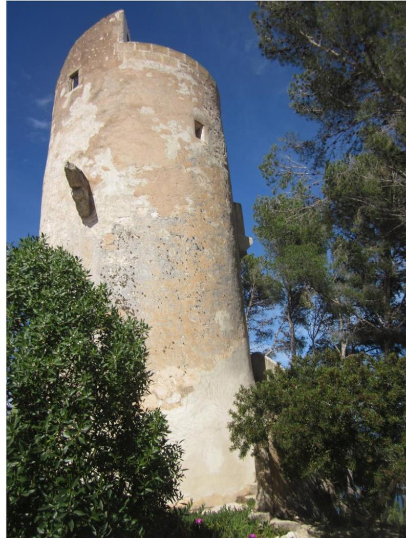
Imagen Torre del Portichol, donde se puede apreciar las hiladas de sillería adheridas en la parte superior; la restauración del talud con mortero de cemento, y el estado actual de la torre, marzo 2013
