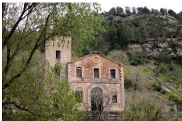
Figura 1.3: Fàbrica de llum de l'Infern, una de las centrales hidroeléctricas existentes en el Racó del Duc.
