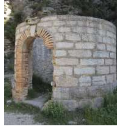
Figura 3.7: Antiguo depósito del ferrocarril.
