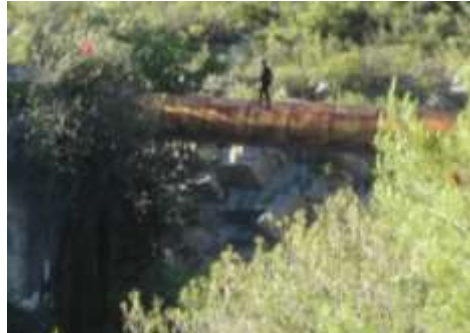
Figura 2.13: Canalizaciones de agua sobre el río Serpis a la entrada del Barranc de l'Infern.
