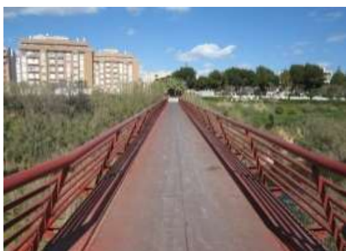
Figura 2.7: Puente de entrada a Gandia del antiguo ferrocarril Alcoi – Gandia.
