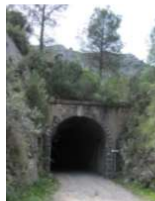
Figura 2.25: Túnel de la Mina llarga.
