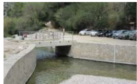
Figura 2.15: Pontón junto a la Fàbrica de l'Infern
