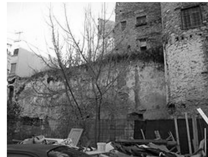
Restos de la muralla islámica al lado de la Torre del Ángel
