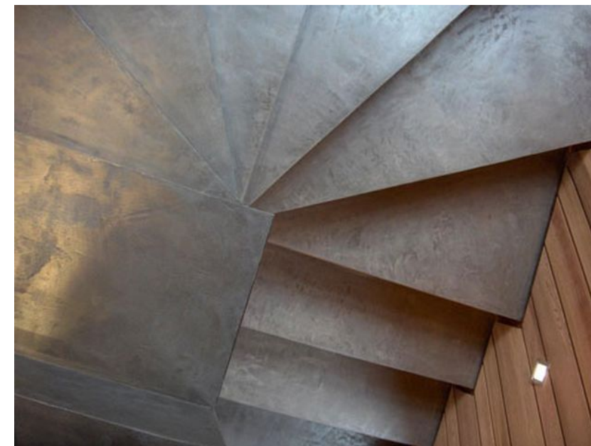
Suelo hormigón pulido
