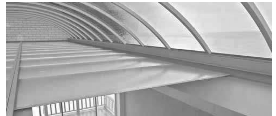
Falso techo polycarbonato
