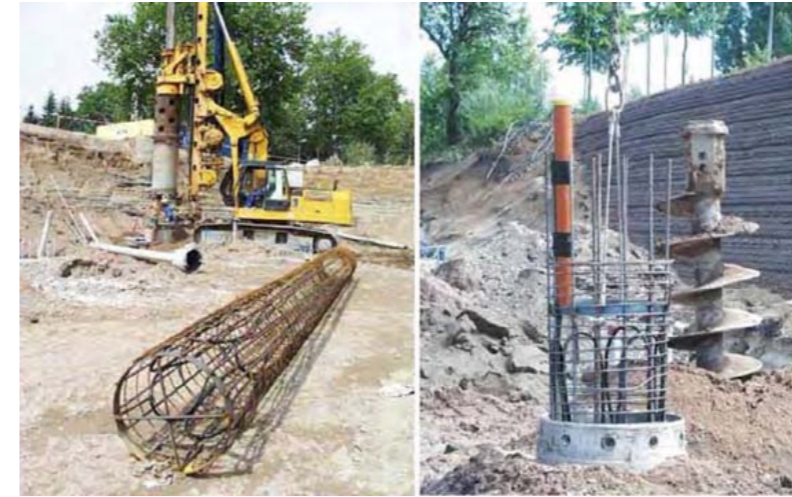
Armaduras de pilote con captadores antes y después de su colocación
