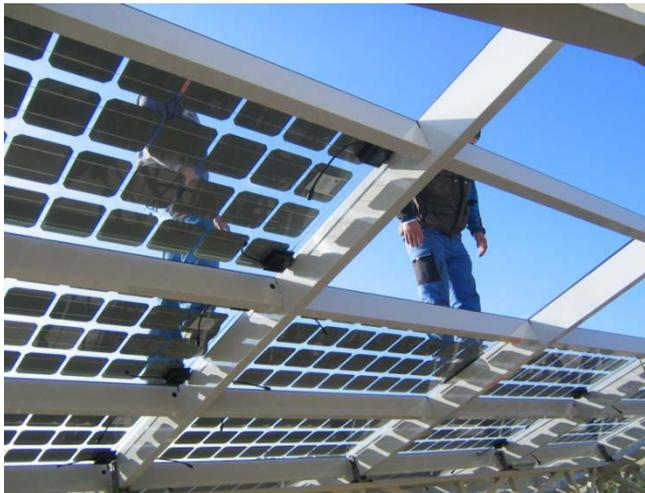
Detalle del vidrio fotovoltaico
