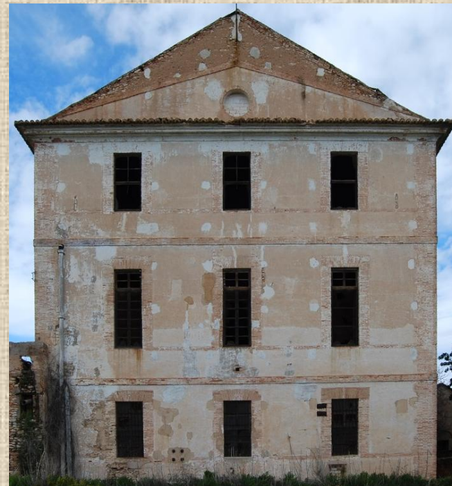
MURO CON MAMPOSTERÍA Y LADRILLOS
