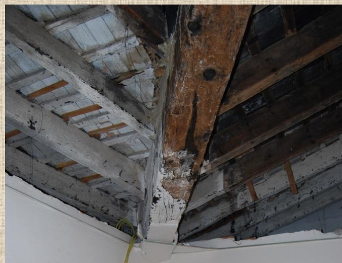
CUBIERTA CON VIGAS, CORREAS, ENLISTONADO, TABLERO Y TEJA CURVA
