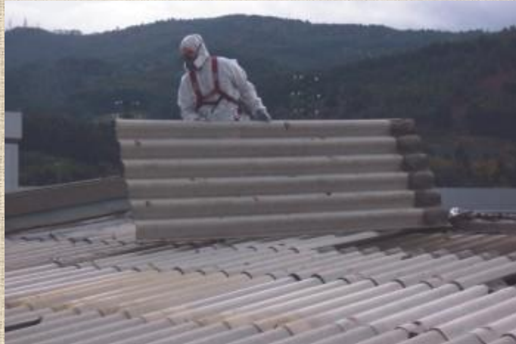
RETIRADA DEL APLACADO DE FIBROCEMENTO
