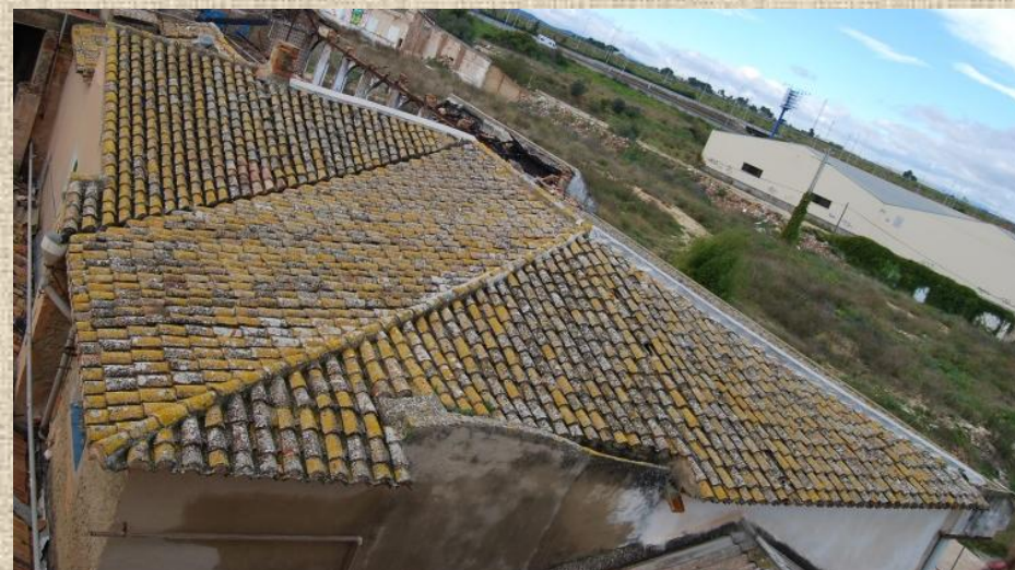
CUBIERTA CON VIGAS, CORREAS, ENLISTONADO, TABLERO Y TEJA CURVA
