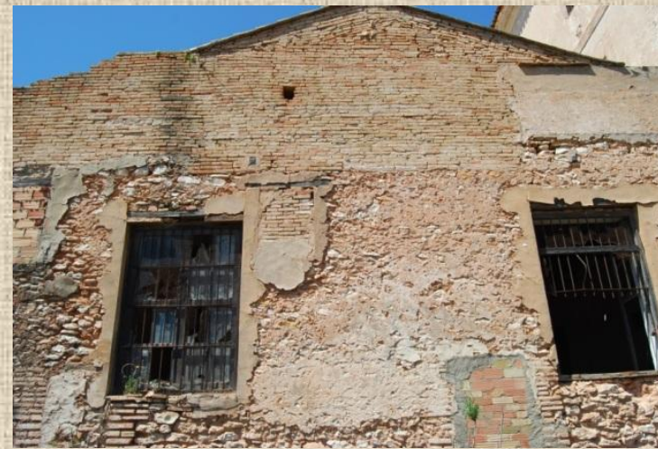
MUROS CON MAMPOSTERÍA
