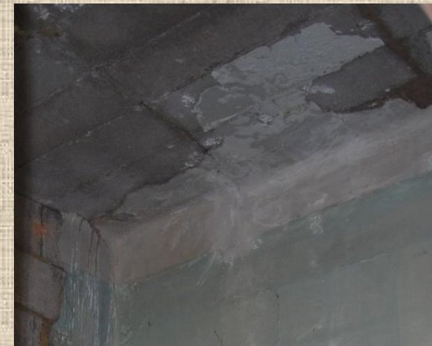
FROJADO/CUBIERTA DE VIGUETAS Y BOVEDILLAS
