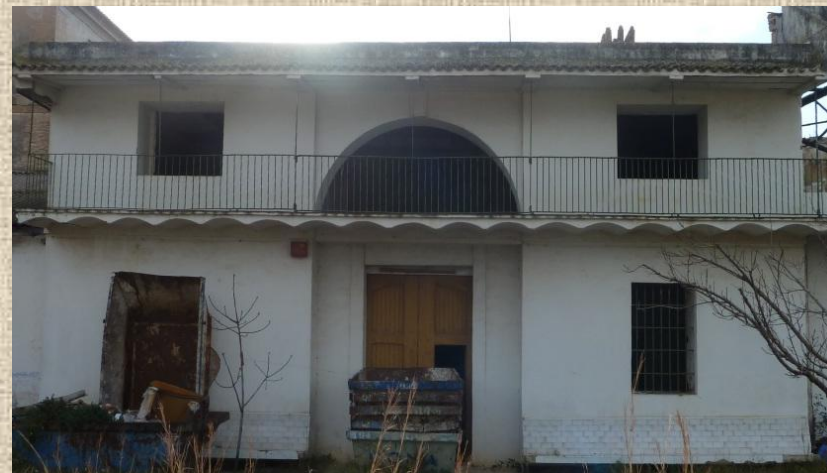
MUROS DE MAMPOSTERÍA
