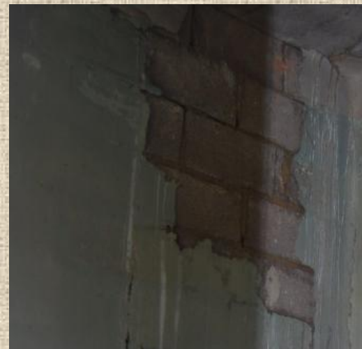
MUROS DE BLOQUE DE HORMIGÓN
