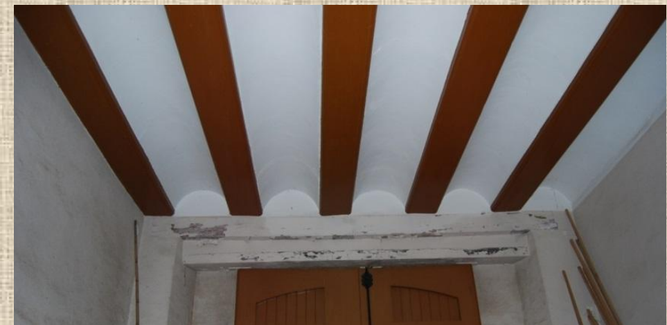
FORJADO CON VIGAS DE MADERA Y REVOLTONES DE LADRILLO
