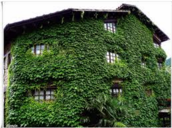
Fachada cubierta de hiedra
