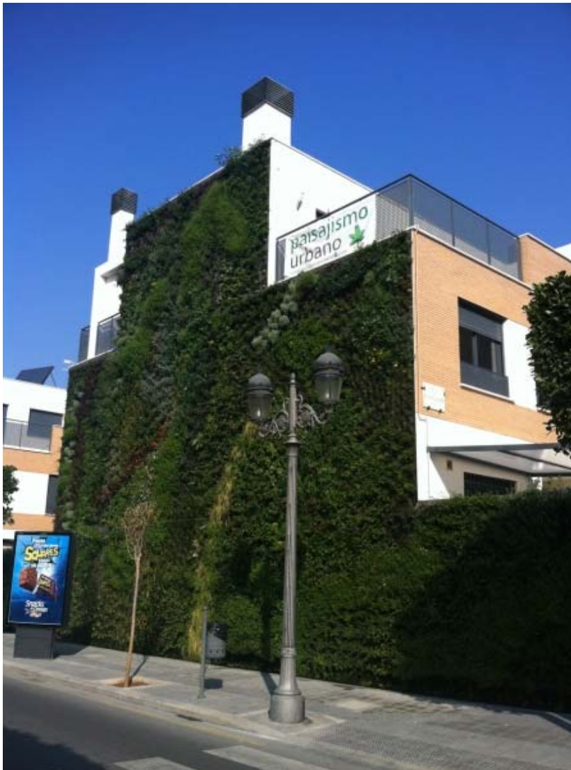
Fachada ejecutada en edificio situado en Paterna (Valencia)
