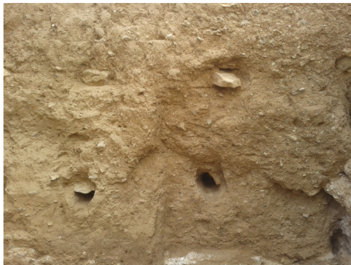
Imagen 2.1. Tierra de un antiguo muro de tapia
