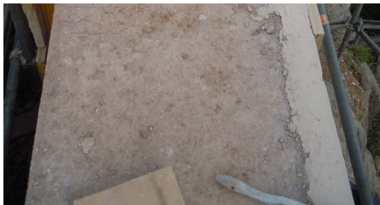
Imagen 3.48. Coronación muro de tapia negro
