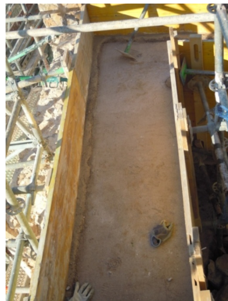
Imagen 3.46. Vertido y apisonado Tierra estabilizada
