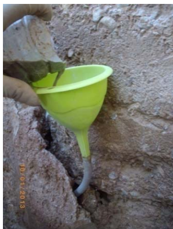
Imagen 3.106: Vertido de mortero de inyección.
