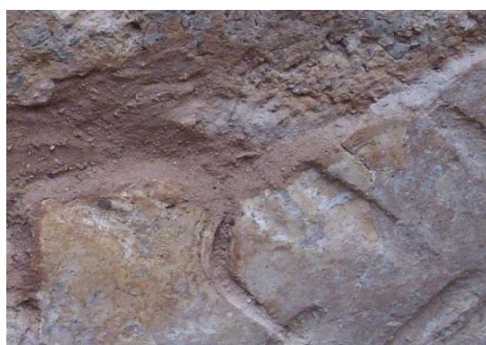
Imagen 3.110: Aplicación de mortero en Bordes.
