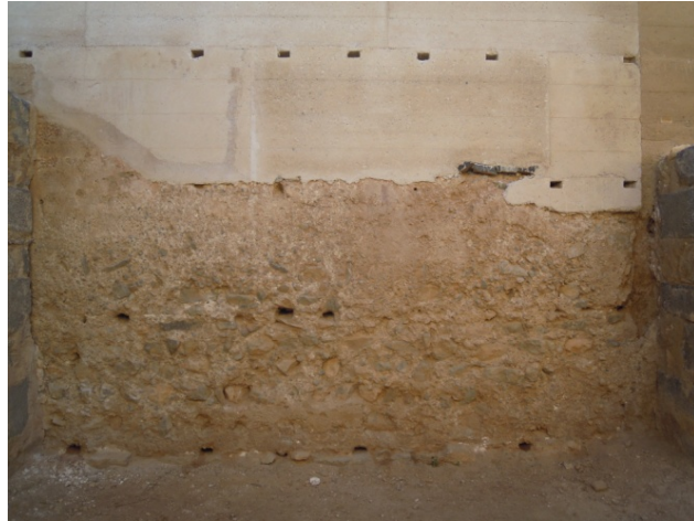
Imagen 3.10: Resultado muro de tapia de tierra calicostrada.
