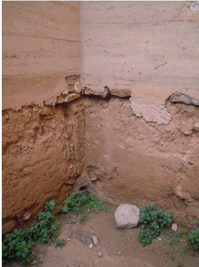
Imagen 1.25: Losas de piedra para diferenciar zonas de nueva ejecución de zonas existentes
