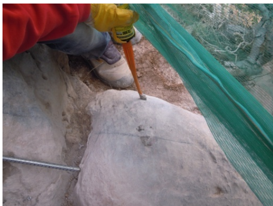
Imagen 3.39, Imagen 3.40; Fijación de la armadura a la roca mediante anclaje químico.
