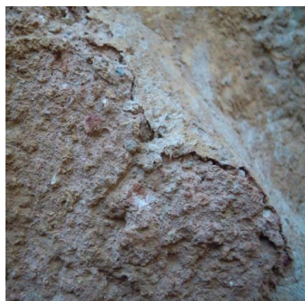
Imagen 3.83. Mortero de intervención separado del original
