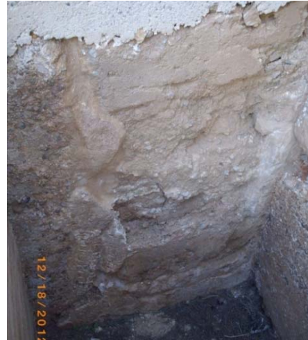
Imagen 3.63. Estado inicial del paramento; diferentes niveles
