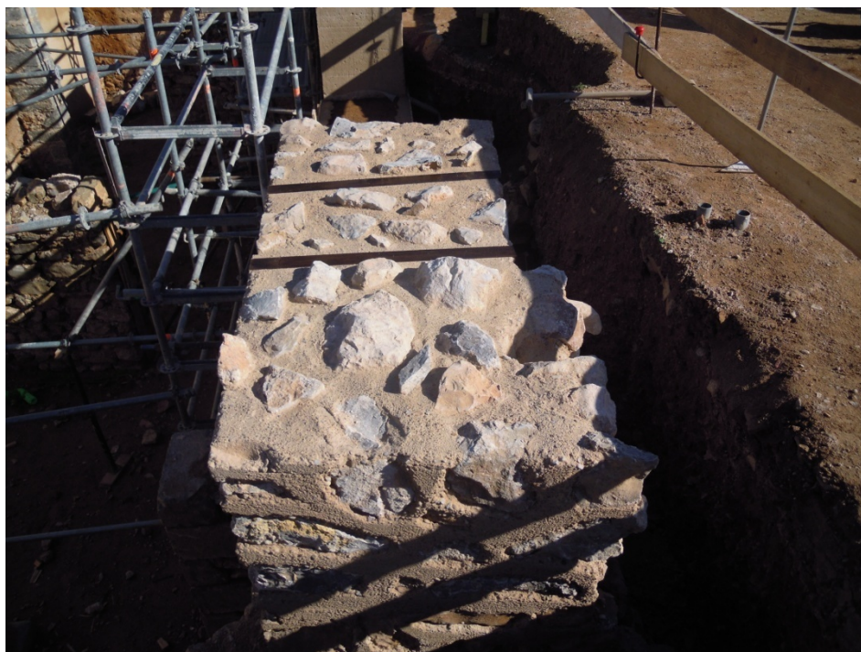
Imagen 3.4: Recreido de muro de tapia de hormigón de cal con mampuestos
