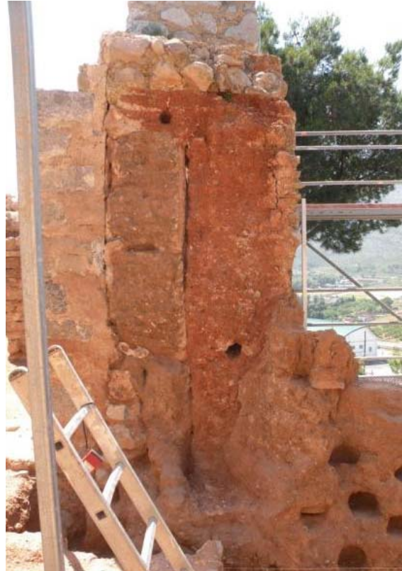
Imagen 3.52. Excavaciones arqueológicas llevadas a cabo en una anterior actuación en la torre Norte.
