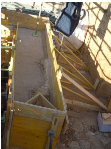
Imagen 3.45. Ejecución de costras.
