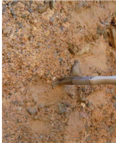
Imagen 3.111: Humectación posterior de los morteros añadidos
