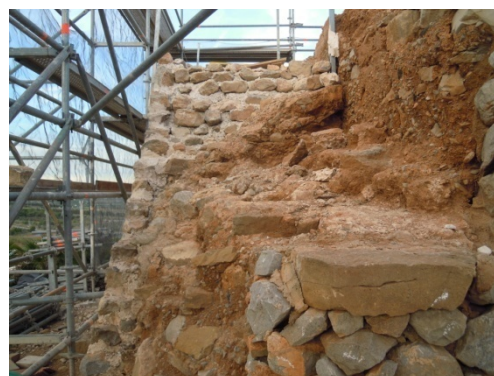
Imagen 3.36; Muro de Mampostería adosado a Muro de Tapia de Tierra Calicostrada.
