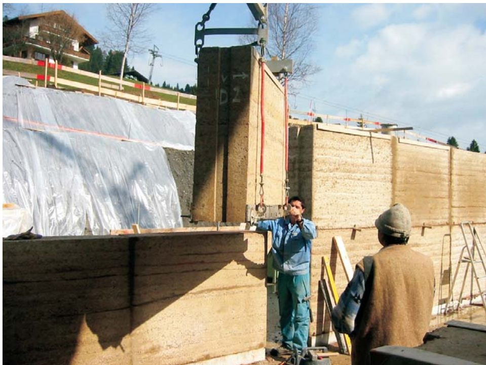
Imagen 2.9; Ensamblaje de muro de tapia prefabricado.
