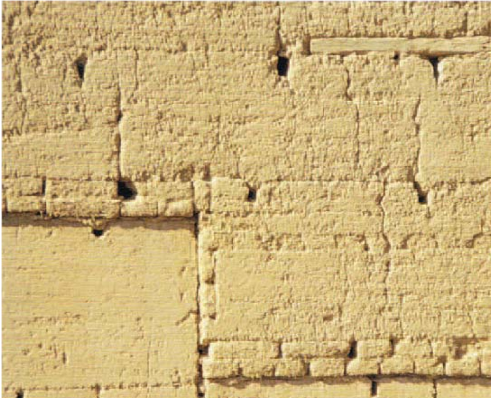
Imagen 1.16: Muro de tapia de tierra
