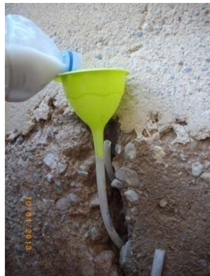
Imagen 3.105: Vertido de dispersión de resinas.
