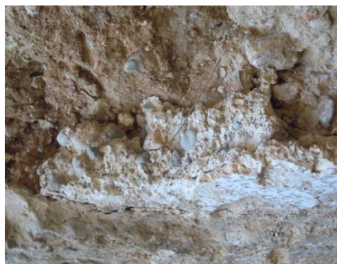
Imagen 3.81. Muestras donde se aprecian los grosores de los aridos
