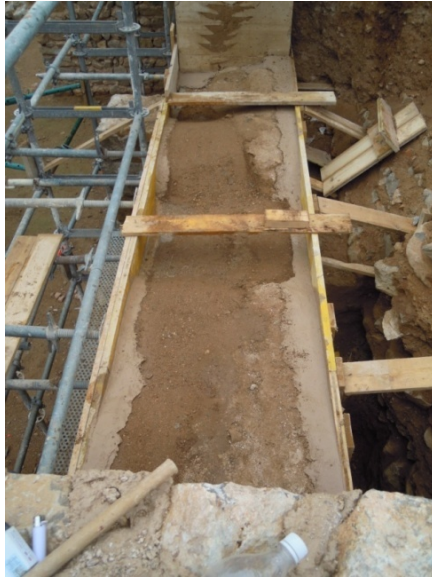
Imagen 3.8: Momento del vertido de las costras y de la tierra estabilizada en Muro de tapia de tierra calicostrada.
