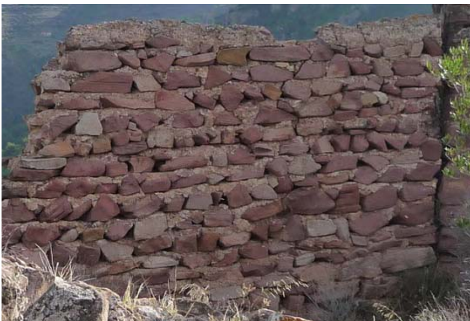
Imagen 1.20: Paramento de Muro Tapia de Piedra y Tierra. En El Castell Vell, Castellón
