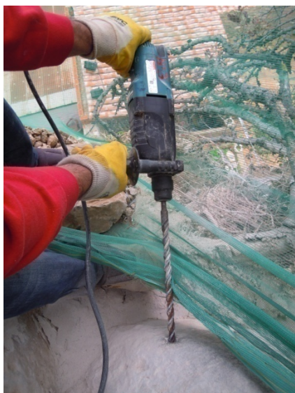
Imagen 3.37, Imagen 3.38; Ejecución de taladro en la roca y eliminación de restos de la perforación
