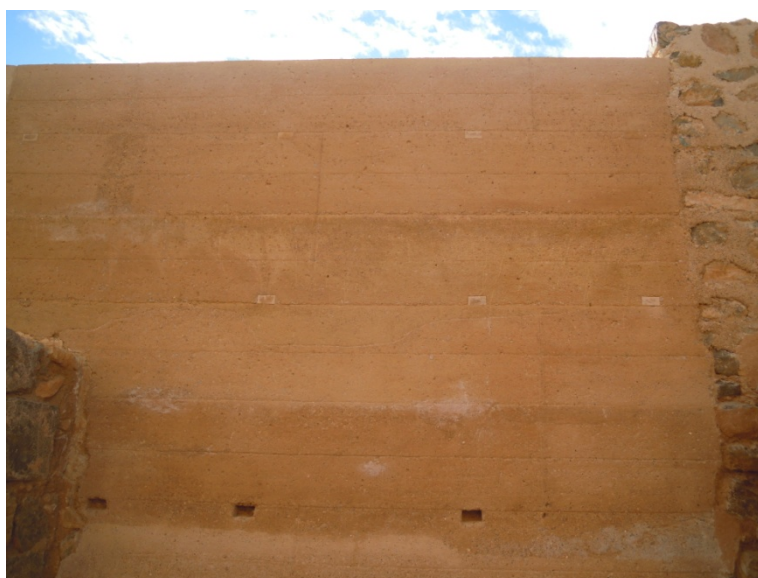
Imagen 4.9. Incisión sobre paramento en línea donde se localizaba el tapial antiguo
