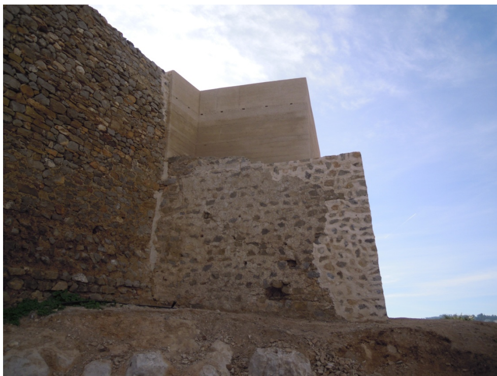
Imagen 3.59. Vista exterior Alzado Norte de la Torre Sudoeste
