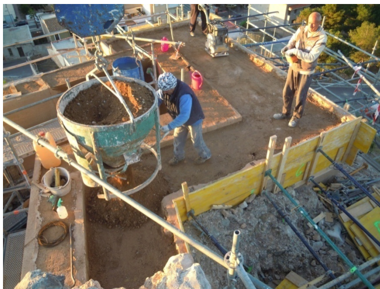
Imagen 3.51. Vertido y apisonado de la tierra
