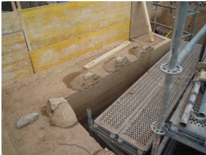
Imagen 3.47. Tacos de madera para imitar a las agujas originales en el paramento cubiertos con mampuestos.
