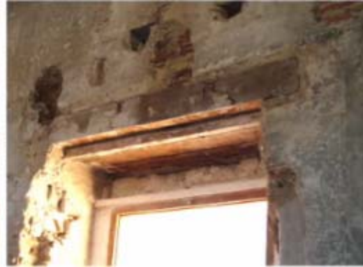
Imagen 1.18: Dintel de Madera en Muro de Tapia
