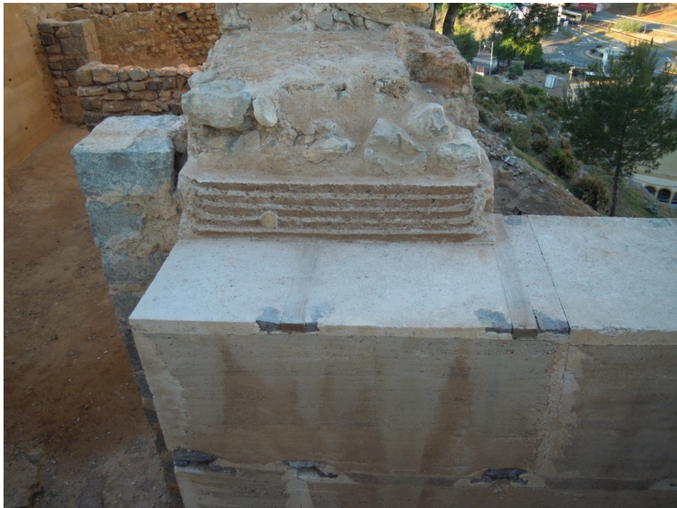
Imagen 3.53. Reconstrucción de la torre original en la Torre Norte, Coronación de los dos muros mediante tapia de tierra calicostrada. Y la solera de 21 cm de espesor de muro de mampuestos con hormigón de cal
