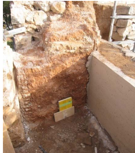
Imagen 3.30; Tramo de Muro de tapia roja. Una sola hoja calicostrada por intradós. Espesor 110 cm.
