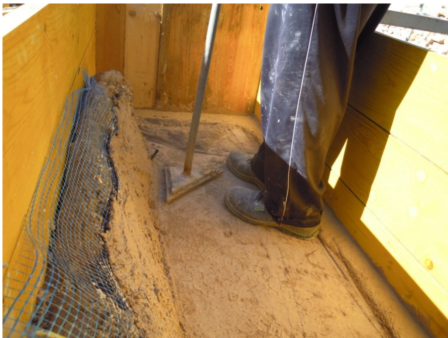
Imagen 3.9: Momento del apisonado con pisón específico para esquinas y zonas delicadas
