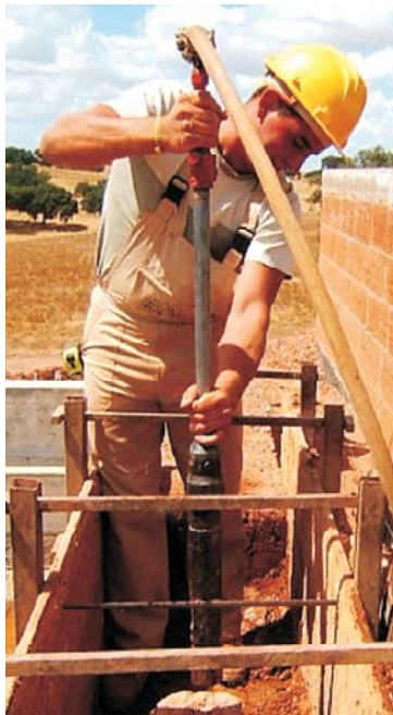
Imagen 2.6; Imagen 2.7. Pisón Mecánico de aire comprimido Sullair
