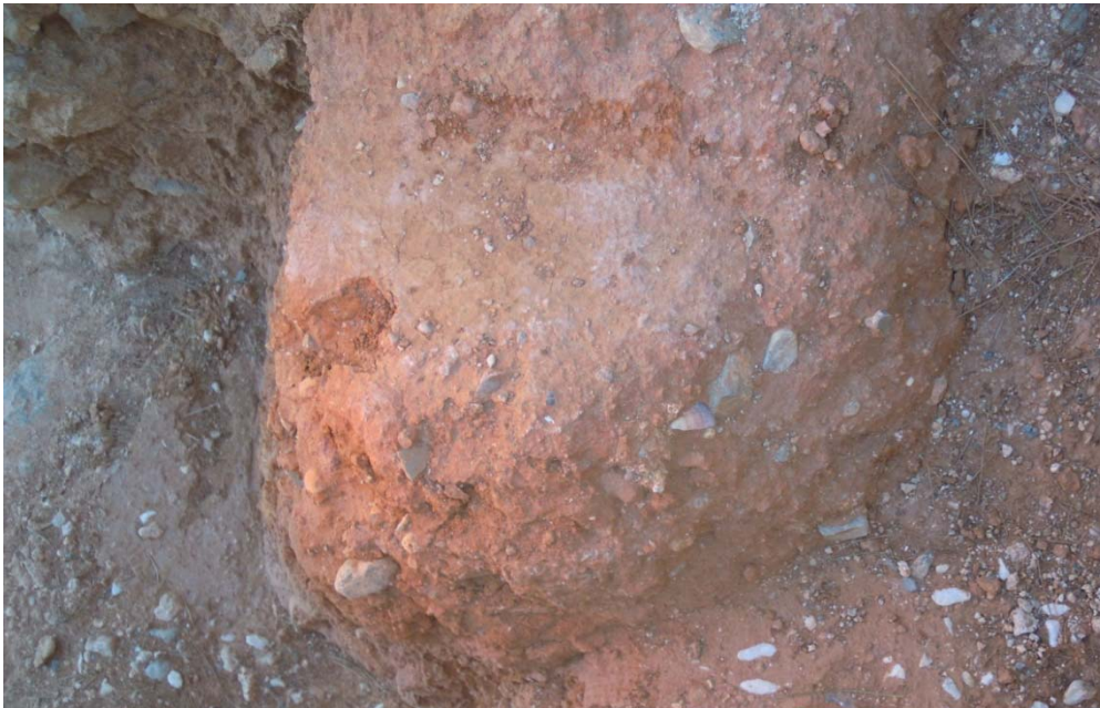
Imagen 1.3: Restos de Muro de Tapia de Tierra localizados en El Castillo de Oropesa
