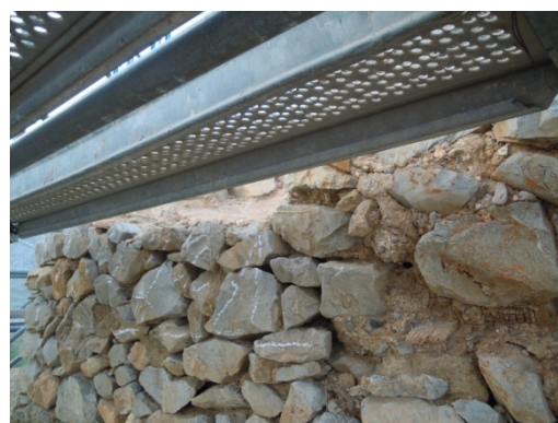
Imagen 3.26; Restos de muro de tapia de mampuestos con hormigón de cal
