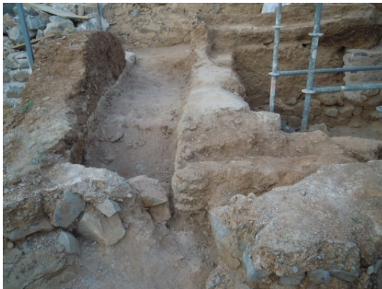
Imagen 3.29; Muro de tapia roja con dos hojas bien diferenciadas.
