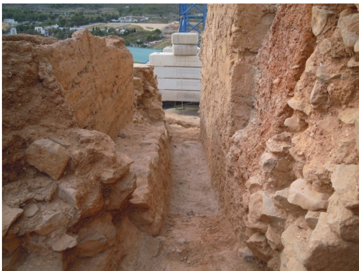
Imagen 3.31 Cimentación de muro de tapia de tierra roja
