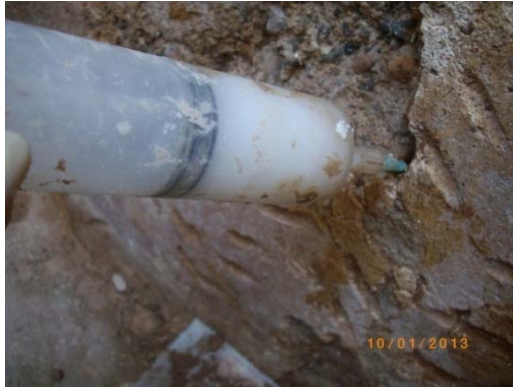
Imagen 3.100: Inyección resina diluida.
