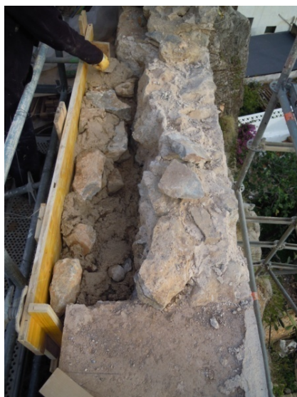
Imagen 3.33; Reconstrucción de 1/2 hoja de muro de tapia de piedra con Horm de Cal.
