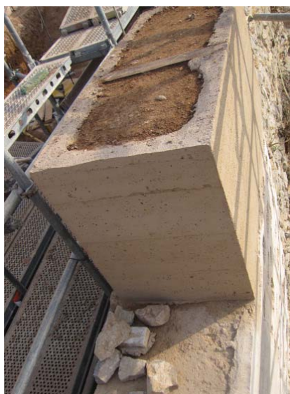
Imagen 4.1. Muro de tapia de tierra calicostrada.
