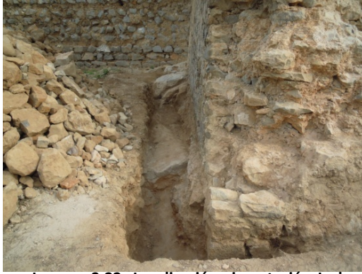
Imagen 3.22; Localización cimentación Lado Norte de la Torre Sudoeste
