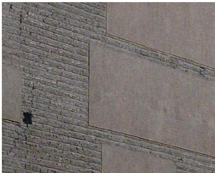
Imagen 1.21: Paramento de Muro Tapia de Tierra Y Machones
