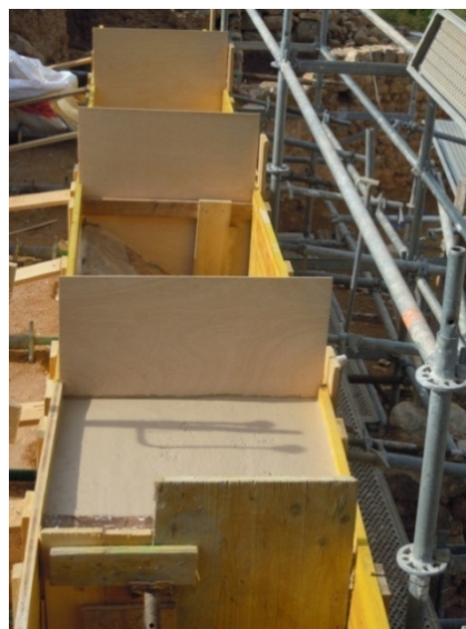
Imagen 3.5; Imagen 3.6.: Tapialeras continuas, con tablas contrachapado formando juntas verticales. Primero se llenan los dos tapiales extremos y luego se llena el tapial central
