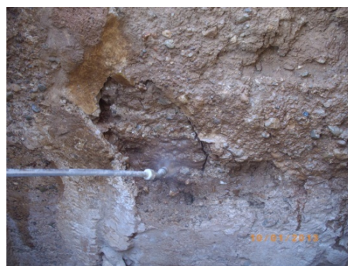
Imagen 3.99: Humectación generalizada antes de aplicar materiales
