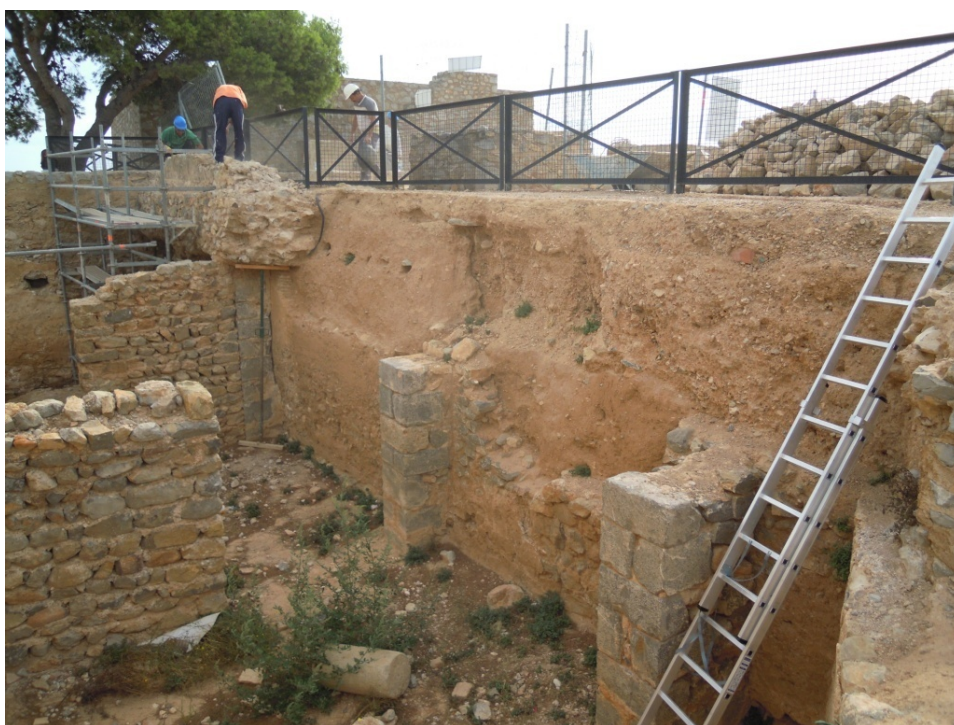
Imagen 2.1: Estado inicial del muro de separación de la sala medieval con el aljibe
