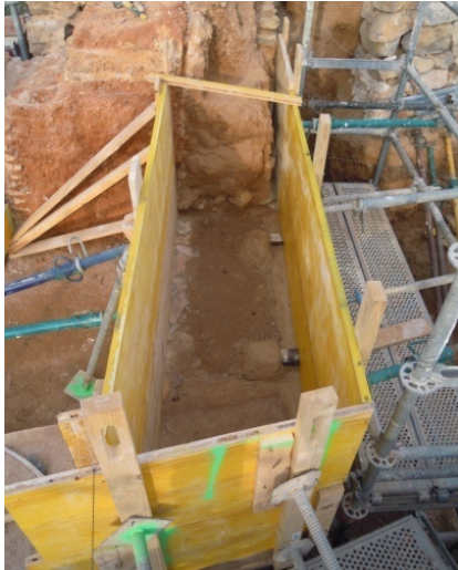
Imagen 3.43. Tapiales y Tacos para marcar huecos de agujas en el paramento.
