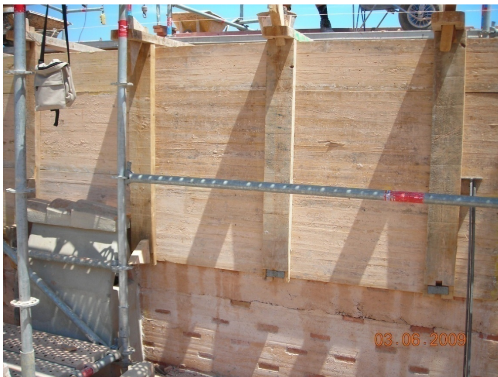
Imagen 1.9: Reconstrucción de muro de Tapia en el Ciudad Amurallada de Mascarell
