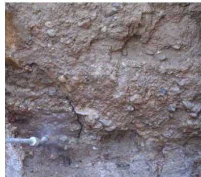
Imagen 3.113: Impregnación de resina muy diluida en el tapial
