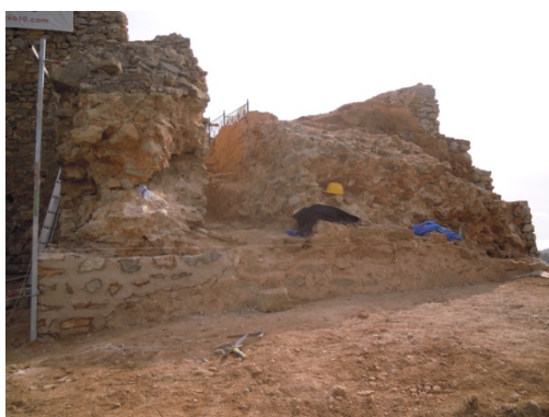
Imagen 3.35; Ejecución muro mampostería ordinaria en Alzado Oeste de la Torre Sudoeste.
