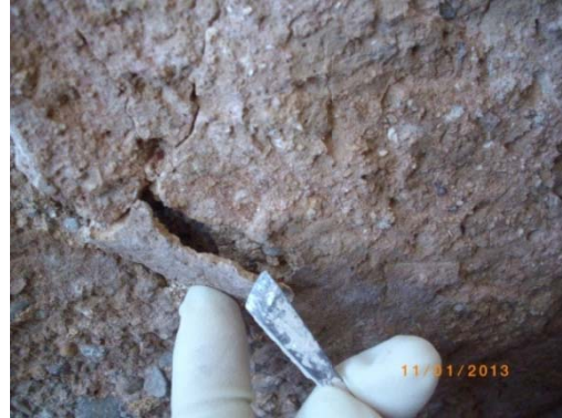
Imagen 3.75. Eliminación del mortero con gubias
