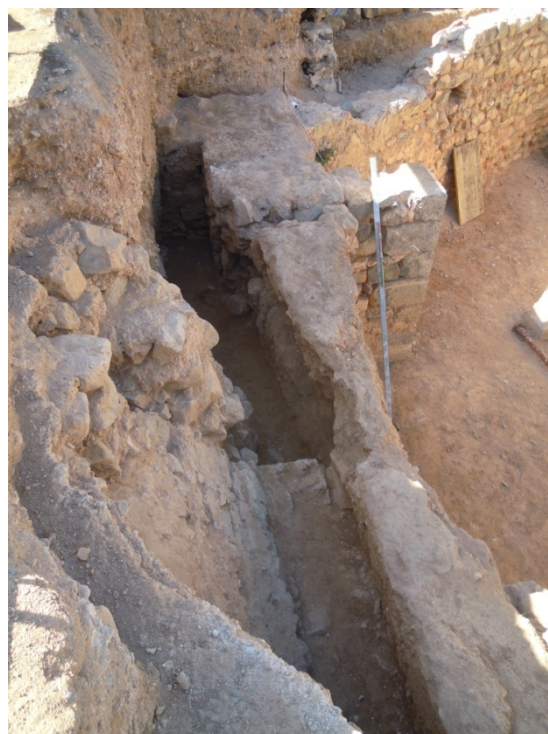
Imagen 3.3: Restos de muros de tapia calicostrada y de Muro de tapia de piedra con hormigón de cal.
