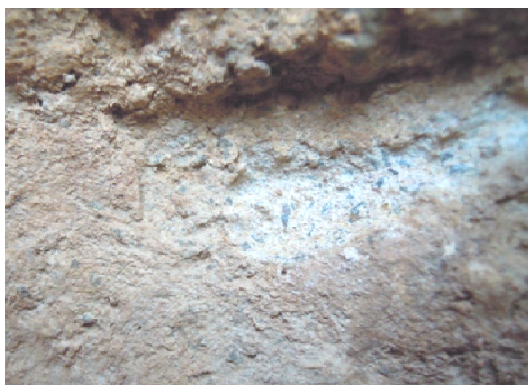
Imagen 3.80. Aspecto del mortero duro y rígido
