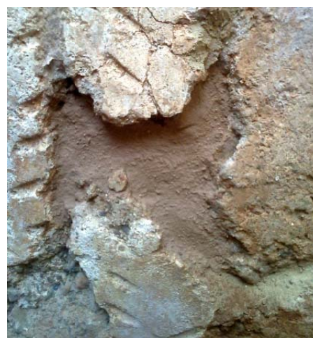
Imagen 3.109: Aplicación de mortero plano a Bajo Nivel.
