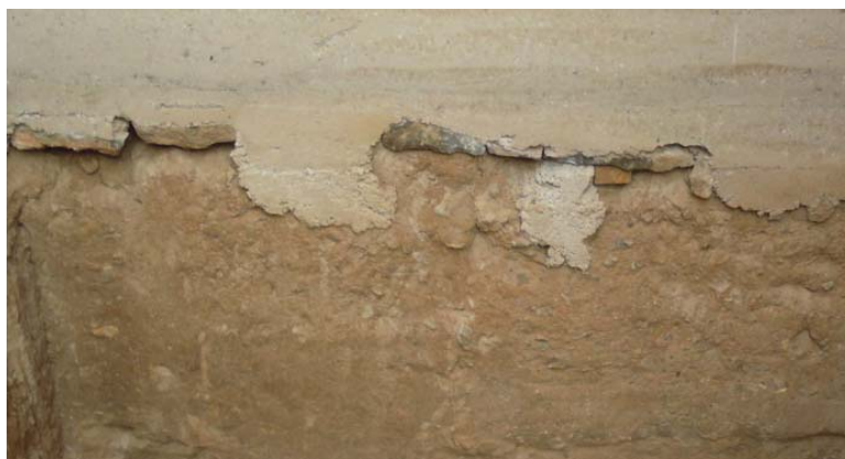
Imagen 3.17; Losas de piedra marcando separación entre las zonas de nueva ejecución y las existentes
