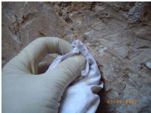
Imagen 3.96: Empacos de acetona para retirar resina
