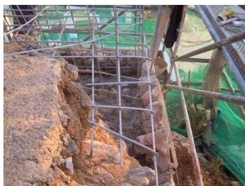
Imagen 3.41, Imagen 3.42; Montaje del armado, Ejecución Muro mampostería ordinaria y hormigonado.
