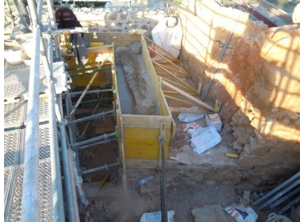
Imagen 3.44. Tapiales en reconstrucción tramo de muro de la torre Original donde se ha perdido 1/2 hoja
