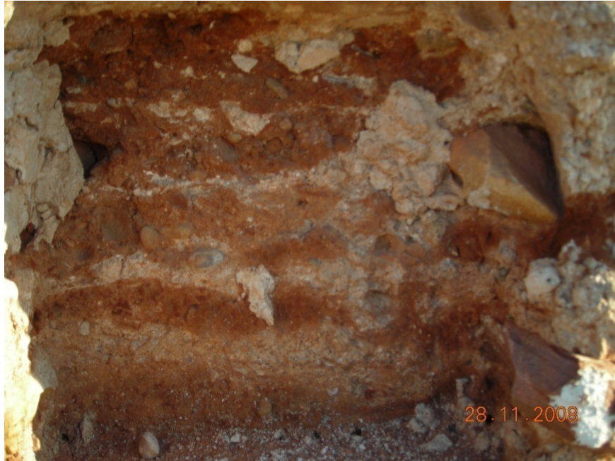
Imagen 1.19: Sección de Muro Tapia de Tierra Calicostrada
