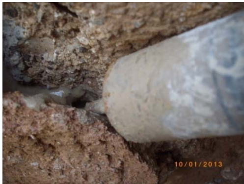
Imagen 3.102: Inyecciones de cal hidráulica
