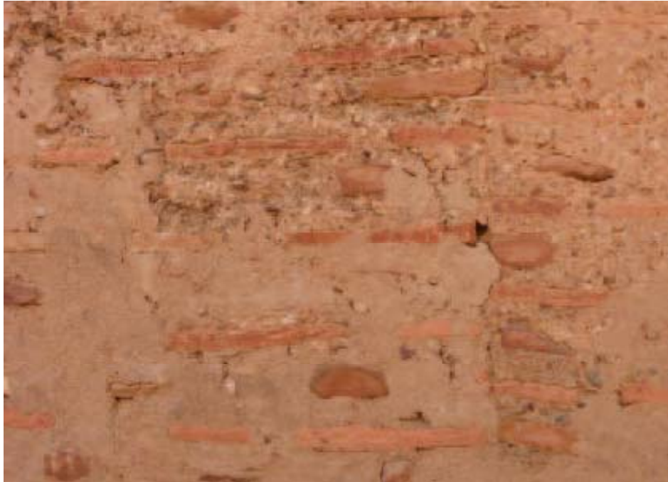
Imagen 1.20: Paramento de Muro Tapia Valenciana
