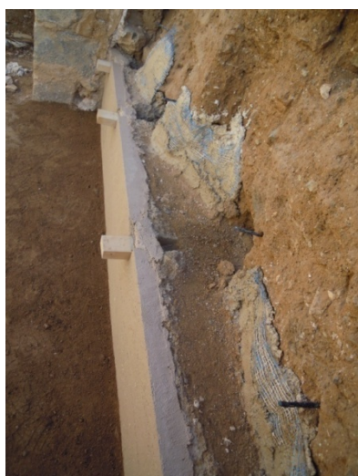
Imagen 3.7; Tacos de madera para dejar hueco en el paramento exterior como si de una aguja se tratase
