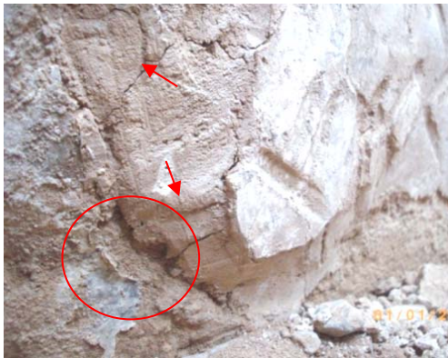
Imagen 3.71. Pegotes de resina sobre grietas en el mortero
