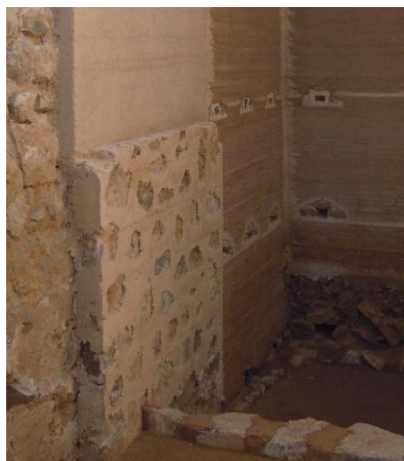
Imagen 1.23: Reconstrucción de Muro Tapia de Piedra con Hormigón de Cal en el Castillo de Oropesa
