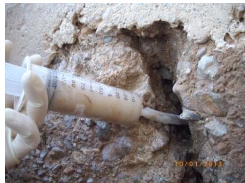
Imagen 3.103: Inyecciones de cal en huecos mayores mediante mangueras
