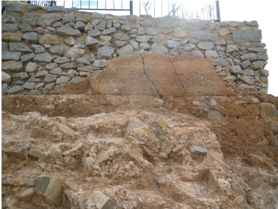
Imagen 3.19; Estado inicial exterior torre Sudoeste por su lado Oeste
