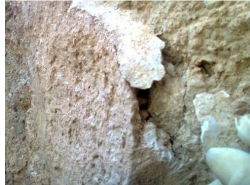
Imagen 3.85. Otro hueco posterior bajo otro mortero de intervención.
