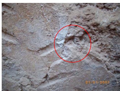
Imagen 3.90. Pegote más rígido que los materiales de alrededor
