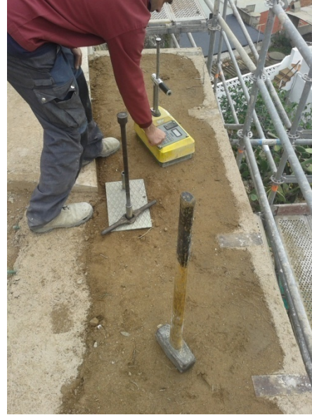
Imagen 3.62. Ensayo de Densidades y grado de compactación
