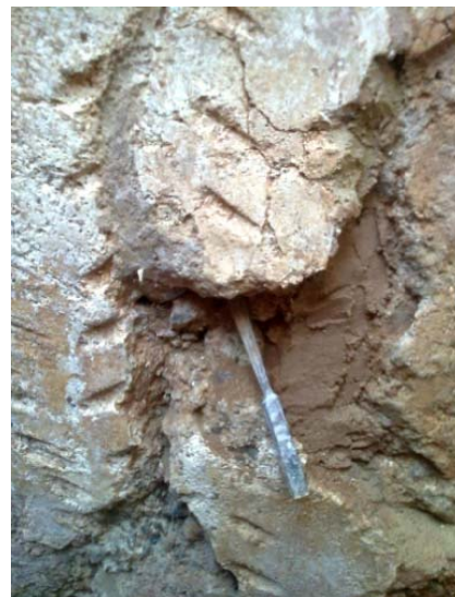
Imagen 3.87. Otra muestra de placas sin colmatar por detrás
