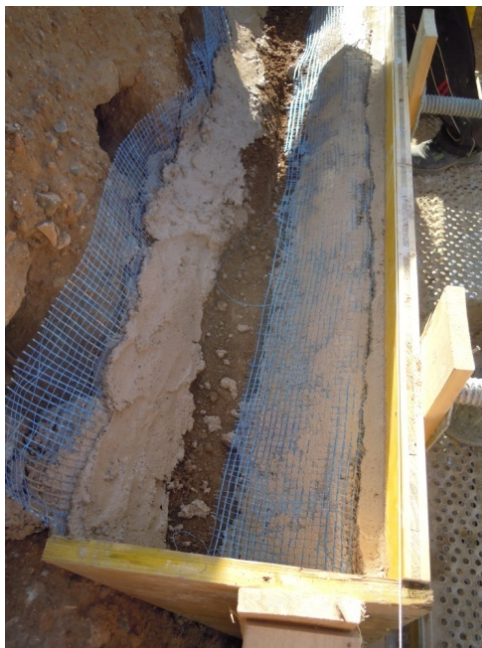
Imagen 3.14; Imagen 3.15; Colocación de Malla de fibra de vidrio entre calicostrado y tierra estabilizada y entre tapia vieja y tapia nueva
