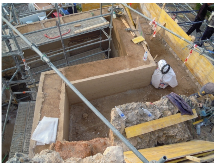
Imagen 3.50. Tapias de la tapia roja solo por el exterior
