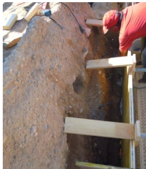
Imagen 3.12: Montaje de tapial a una cara.
