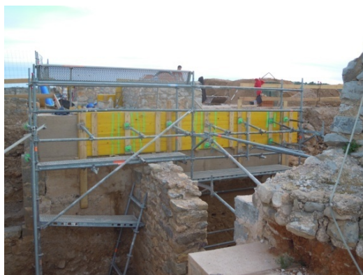
Imagen 3.5; Imagen 3.6.: Tapialeras continuas, con tablas contrachapado formando juntas verticales. Primero se llenan los dos tapiales extremos y luego se llena el tapial central
