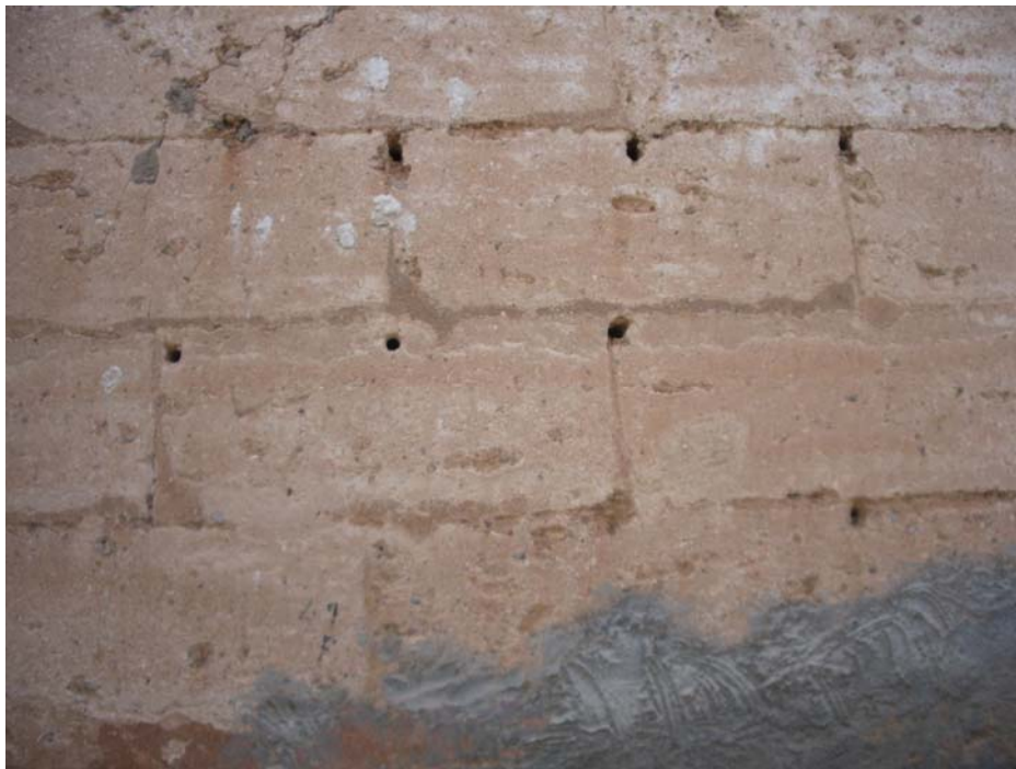
Imagen 1.21: Paramento de Muro Tapia de Brenca
