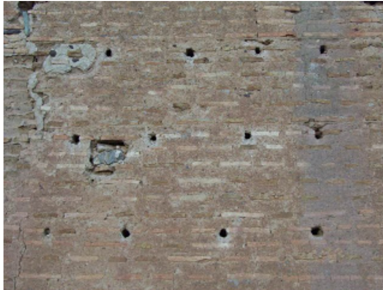
Imagen 1.25: Muro de tapia de Ladrillo
