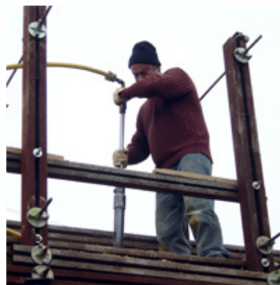
Imagen 2.6; Imagen 2.7. Pisón Mecánico de aire comprimido Sullair
