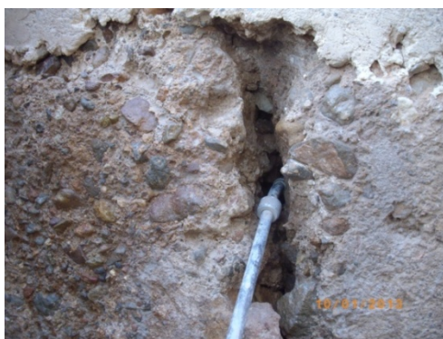
Imagen 3.98: Humectación interior de grietas
