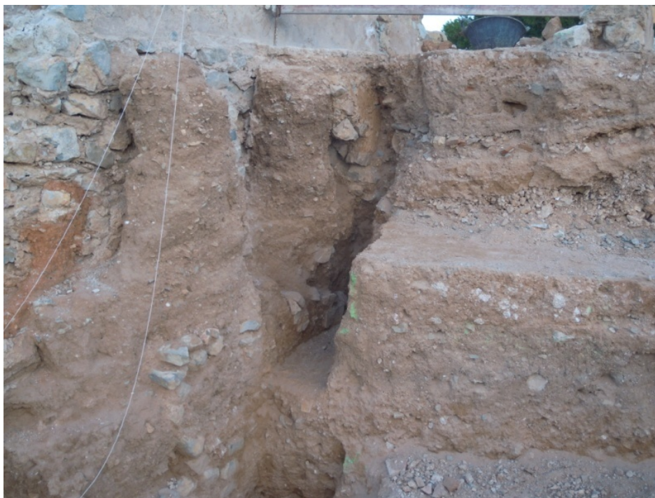
Imagen 3.32; Restos de muro de tapia de tierra calicostrada en tramo Norte del Castillo
