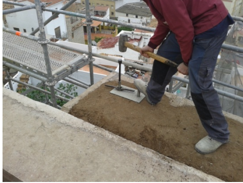
Imagen 3.61. Ensayo de Densidades y grado de compactación
