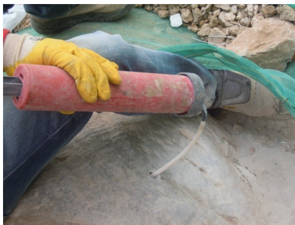
Imagen 3.37, Imagen 3.38; Ejecución de taladro en la roca y eliminación de restos de la perforación
