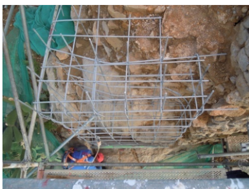
Imagen 3.41, Imagen 3.42; Montaje del armado, Ejecución Muro mampostería ordinaria y hormigonado.
