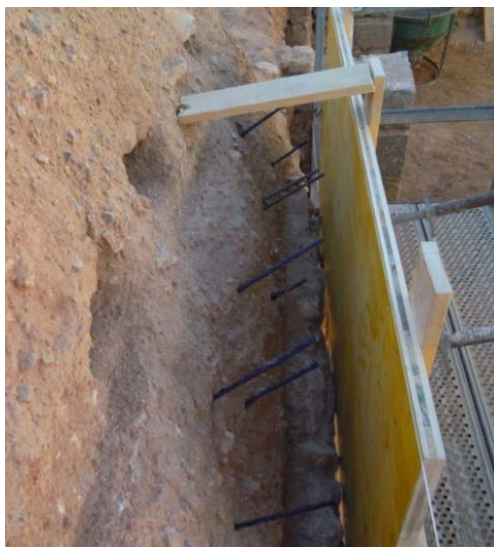
Imagen 3.11: Varillas de fibras de carbono para mejorar la unión obra vieja-obra nueva.
