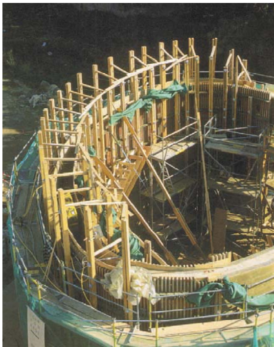
Imagen 2.3. Encofrado en la Capilla de la reconciliación. Berlín.
