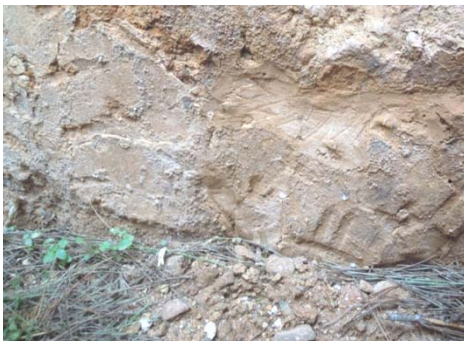
Imagen 3.65. Restos de Mortero y enlucidos. Vegetación
