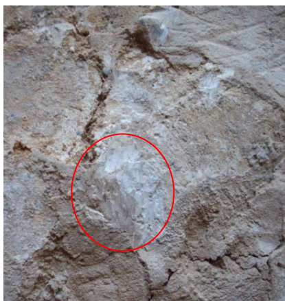
Imagen 3.92. Aspecto de los pegotes epoxídicos tras muelas abrasivas
