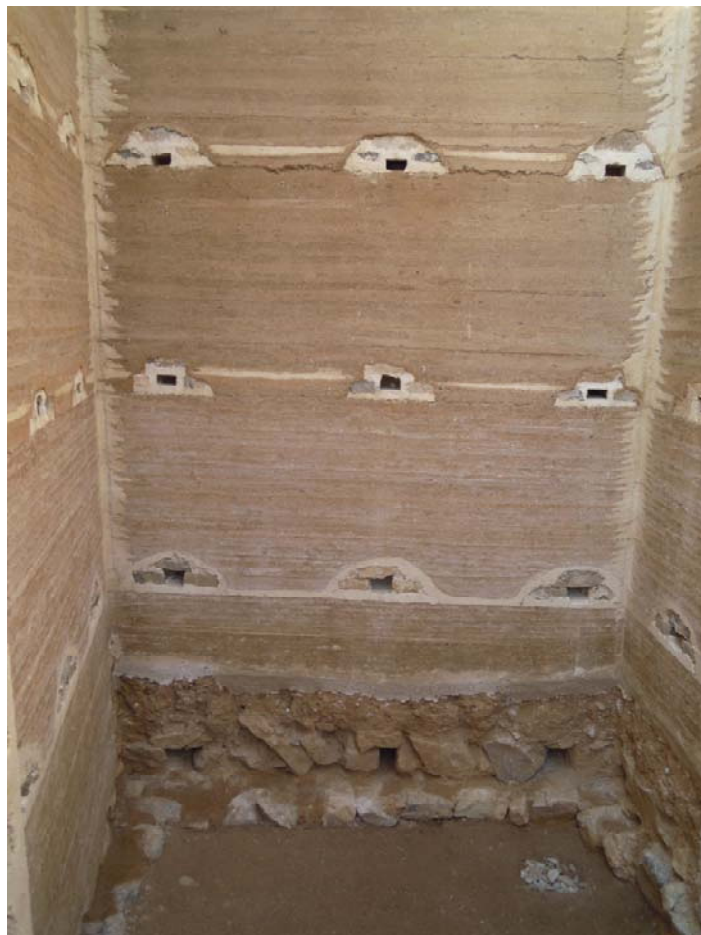
Imagen 3.49. Resultado final de la reconstrucción del muro original. Paramento con tierra estabilizada, donde se pueden ver los mampuestos que envuelven los huecos de las agujas.
