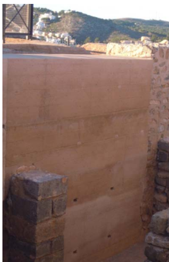
Imagen 4.6. Muro de Tapia de Tierra Calicostrada.
