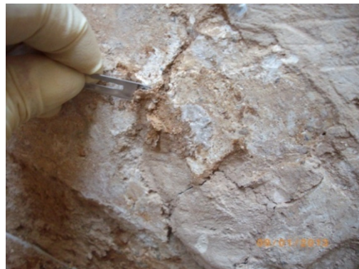
Imagen 3.97: Eliminación de morteros reblandecidos con disolventes
