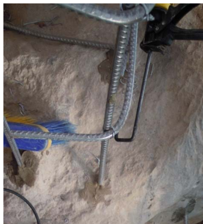
Imagen 3.39, Imagen 3.40; Fijación de la armadura a la roca mediante anclaje químico.
