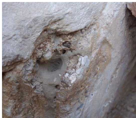
Imagen 3.107: Colmatación de huecos
