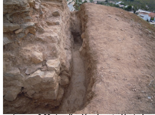
Imagen 3.23; Localización cimentación Lado Oeste de la Torre Sudoeste
