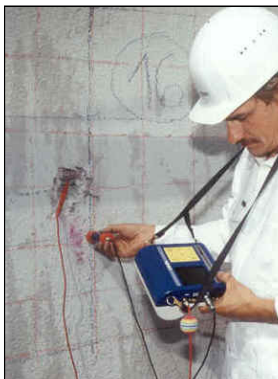
Figura 2.122. Medida de potencial de corrosión in situ con sensor potenciométrico.
