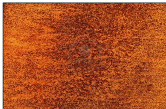
Figura 2.26. Plancha metálica atacada por corrosión uniforme.
