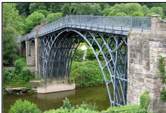
Figura 2.4. Puente de hierro construido por Darby sobre el Severn.
