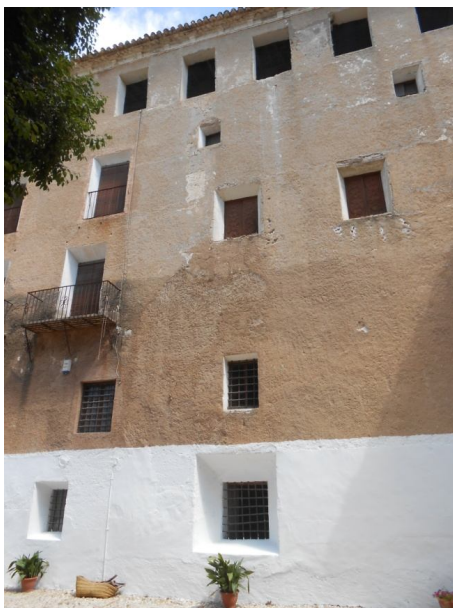
Fachada del edificio, de tres plantas más la cámara. Observamos la desigualdad existente a la hora de ejecutar los huecos de la misma, con tamaños y niveles diferentes, así como su considerable grosor.
