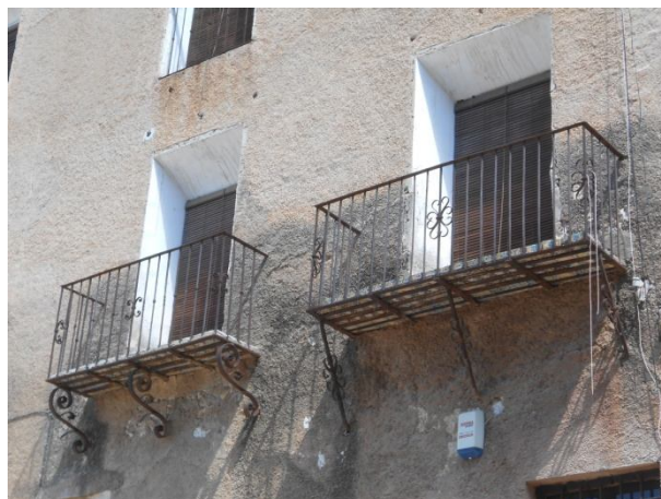
Balcones con rejería y solado de azulejos en la primera planta de la fachada principal del monasterio.
