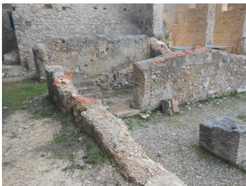
Solución adoptada para la conservación de los muros en las inmediaciones del claustro a base de mortero de cemento. En mi opinión y a la vista de todos poco eficaz, ya que está, de nuevo, totalmente destruido.
