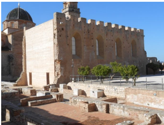
Muro Sur del Refectorio con sus cuatro ventanales apuntados abocinados. Observamos también la coronación del edificio con almenas.
