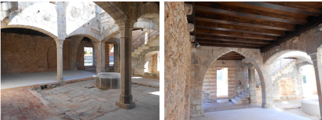
Interior del claustro bajo del Palacio del Abad, en el que destaca sus arcos escarzanos y apuntados. El conjunto es de una belleza notoria.
