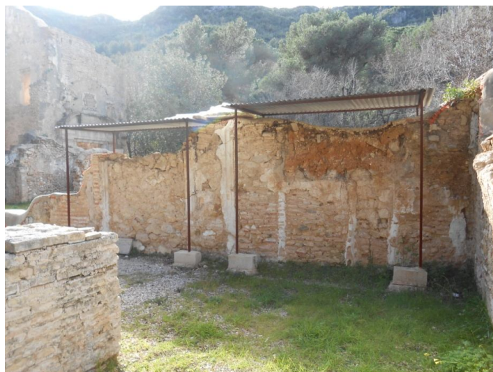
Protección del muro con cobertizo realizado con bloques de hormigón cegados que sirven de apoyo de la estructura; perfiles metálicos como soportes; y chapa metálica ondulada como techo del mismo. Esta solución es poco estética.
