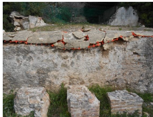
Solución adoptada para la conservación de los muros en las inmediaciones del claustro a base de mortero de cemento. En mi opinión y a la vista de todos poco eficaz, ya que está, de nuevo, totalmente destruido.
