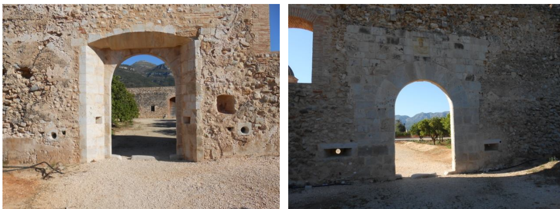
La Puerta de la Xara está realizada mediante arco de medio punto, pero según en el lado en que te encuentres, la terminación del mismo es diferente.
