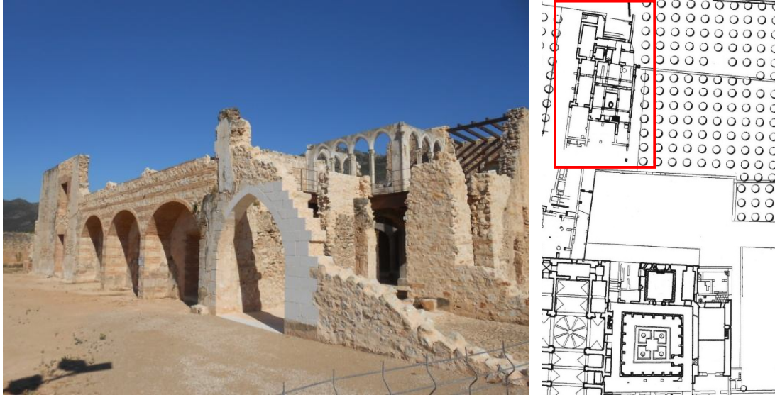
Actualmente se está interviniendo en el Palacio del Abad. En la imagen podemos observar la disposición del claustriillo y la ubicación del Palacio en el plano, siendo este de grandes dimensiones.
