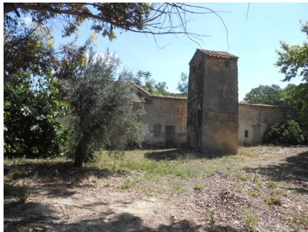
A la derecha del pórtico de entrada se encuentran las ruinas del poblado morisco, con su torre de vigilancia como elemento característico.
