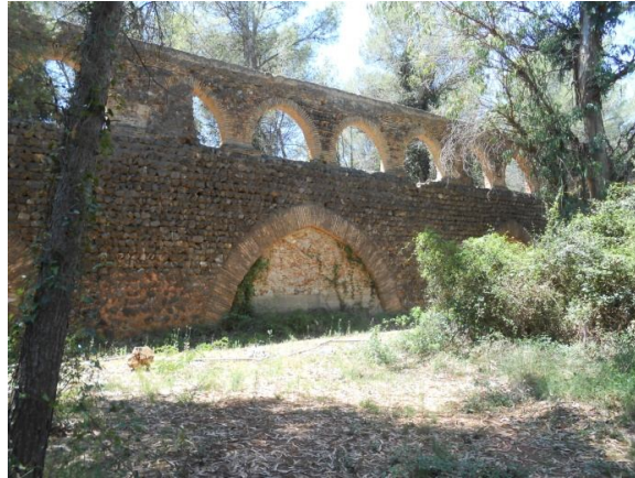
Imagen del alzado del Acueducto en dos alturas, necesarias para salvar los desniveles existentes: la parte inferior y superior ejecutadas con arcos apuntados, aunque la superior de menor tamaño.
