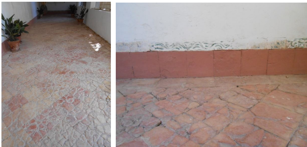
Pavimento de piezas de barro cocido desgastadas. En la imagen de la derecha también se puede observar la cenefa cerámica que decoraba el remate del pavimento.
