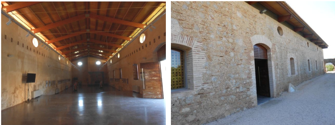
Imágenes que nos muestran el interior y el exterior de la Almazara, hoy en día reconstruida para albergar todo tipo de eventos socio-culturales.
