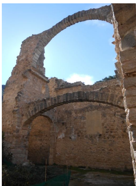
Arcos existentes en la zona del Coro de la iglesia.
