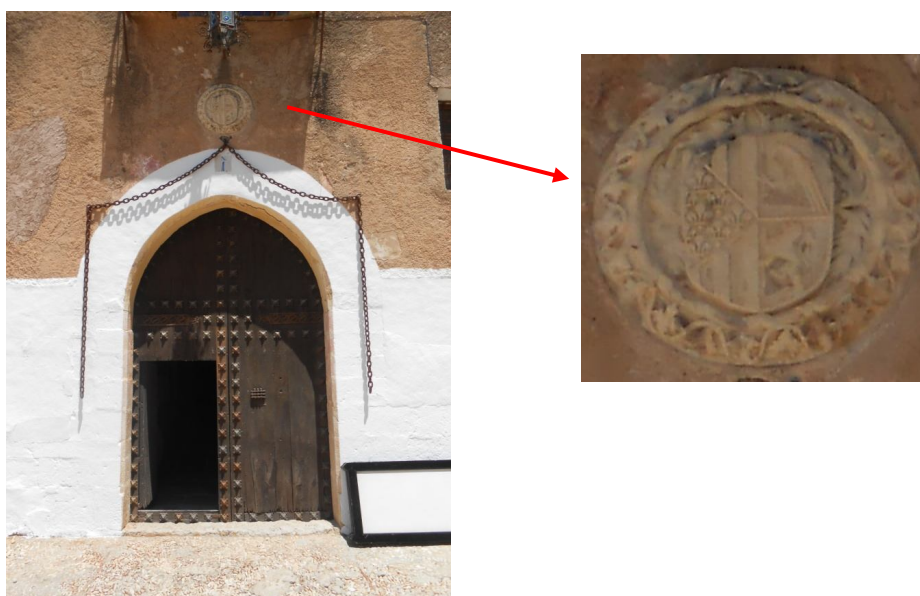
Portada principal de acceso al monasterio, realizado mediante arco apuntado. Sobre él, y en detalle en la imagen de la derecha, tondo con el escudo del fundador del Cenobio.
