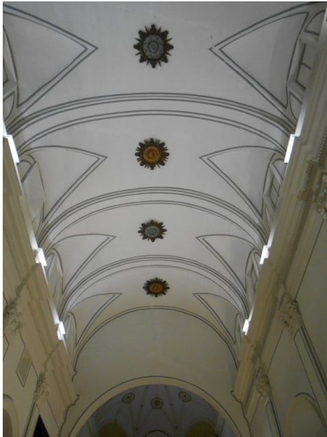
Bóveda de cañón de la iglesia, observándose en la parte superior de la misma las ventanas para aumentar la entrada de luz al Templo o lunetos.
