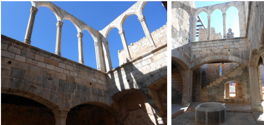
Imágenes del conocidísimo sobreclaustro del Palacio del Abad, formado por arcos apuntados de piedra arenisca: cuatro en su lado mayor y tres en su lado menor.
