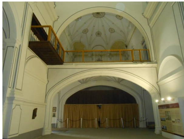
Imagen desde el centro del interior de la iglesia hacia el coro, donde se observa la bóveda estrellada con lunetos que lo caracteriza.
