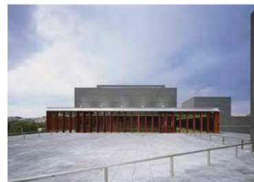
imagen Baluarte, Francisco Mangado
