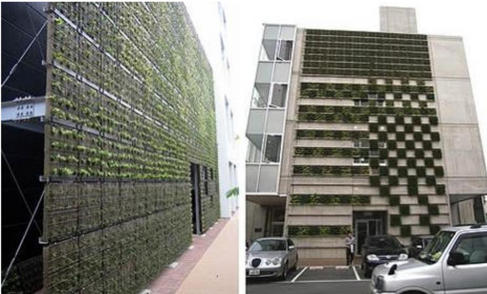
Imagen 28. Ejemplos de fachadas con parabienta
