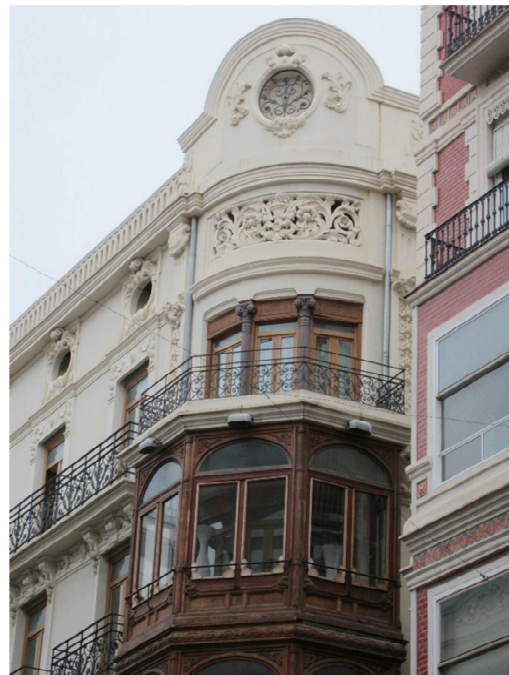
Detalle del muro de coronación
