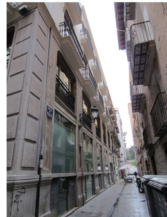
Fachada Calle Verger
