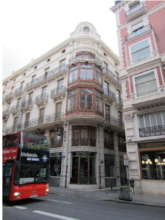
Fachada Calle de la Paz
