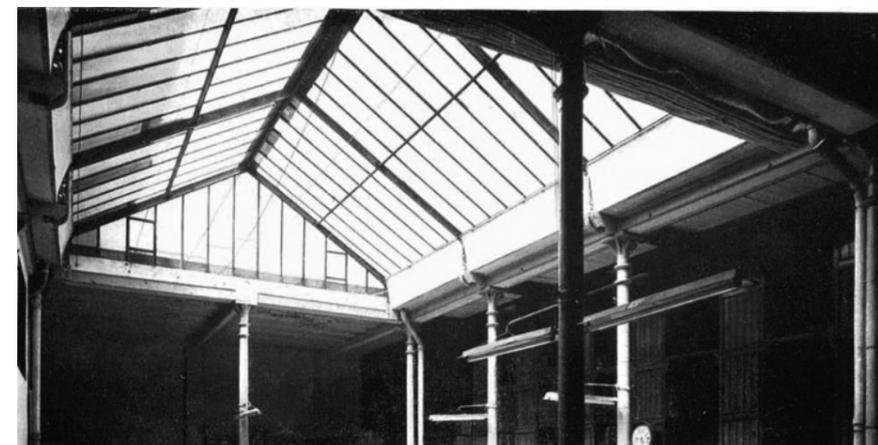
AH 2.9. Ventanal de la planta alta de las oficinas, en carpintería de hierro. Los triángulos que forman los cuadrados esquinados y rotos, contienen cristales rojos. Fuente: el edificio de la editorial Montaner y Simón, por A.Cirili Pellicer
