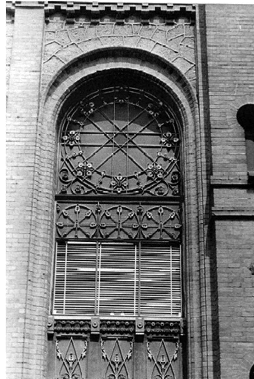
AH 2.3 Ventanal de las oficinas, flanqueado por una torrecilla con escalera de caracol. Nótese los temas plásticos de estilización erizada y rígida de la palmeta, las clavijas, los temas radiales, el arco ultrapasado y las formas estrelladas formadas por pares de tirantes.
